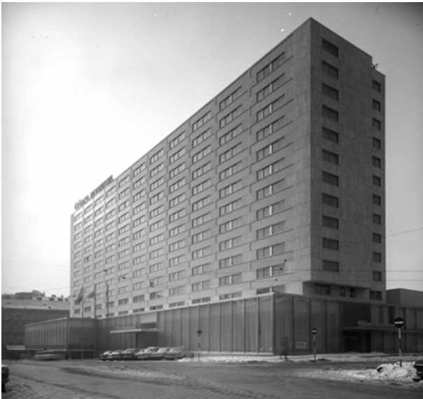
Abb. 3: Wien, Hotel InterContinental, Fassade Johannesgasse, 1964
