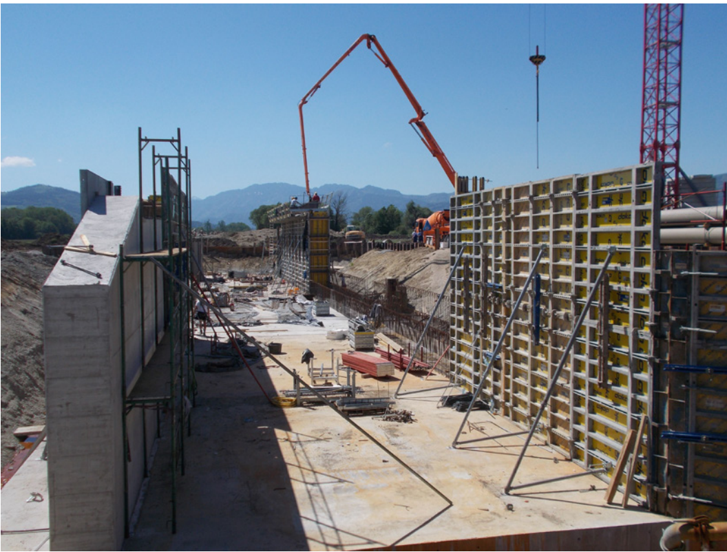
Abb. 4: Betonarbeiten für den Grundablass (Rückhaltebecken Krems-Au)
