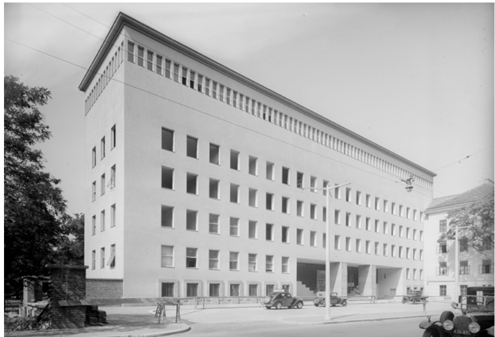
Abb. 1: Wien, Funkhaus Wien, Nordostansicht, 1937
