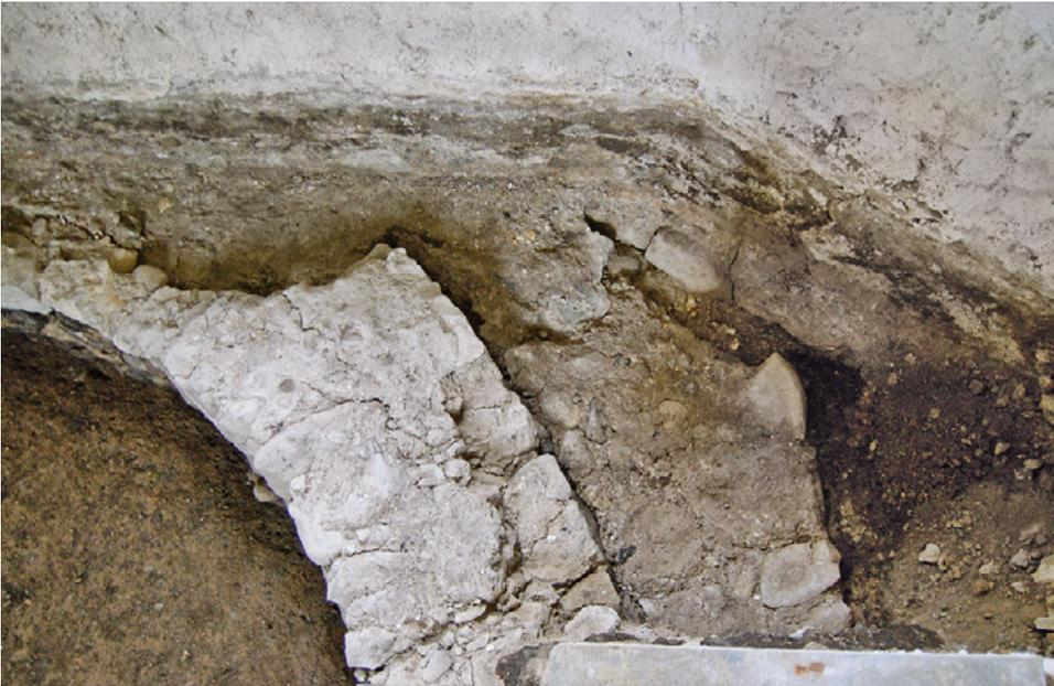
**Abb. 12:** St. Johann. Nordhälfte der Fundamente der romanischen Apsis und des frühgotischen Polygonalchores.
