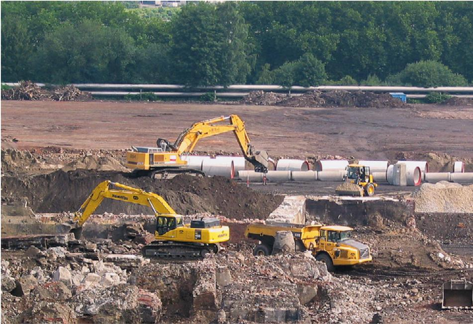
**Abb. 20:** Essen, ehemalige Krupp'sche Gussstahlfabrik. Arbeiten im neuen Quartier. Zu sehen sind Kanalschächte und Fundamentmauern des 19. und 20. Jahrhunderts aus Beton und Bruchsteinen.
