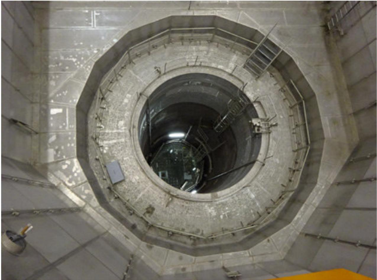
180. Zwentendorf, NÖ, Atomkraftwerk, Reaktorhalle, Einblick von der Brennelementwechselbühne in das Flutbecken des Reaktorkerns
