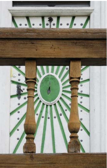
Haustüre mit Stiegenaufgang vor der Sanierung
