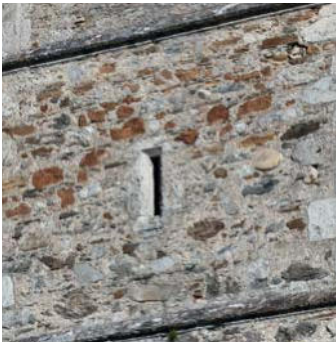
Detail Turmmauerwerk mit partiell erhaltenen gotischen Putzen
