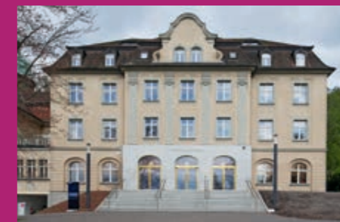
Außenansicht: Außenansicht der Vorarlberger Landesbibliothek © Bundesdenkmalamt, Foto: Bettina Neubauer-Pregl
