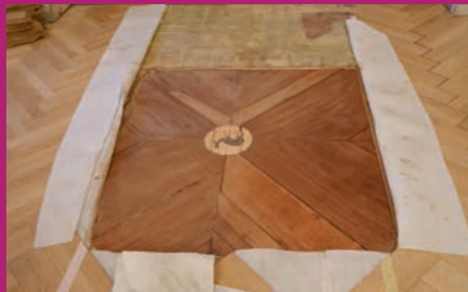
Der originale Tafelparkettboden nach der Reinigung, Befundung 2020 © Kazuhiro Yajima
