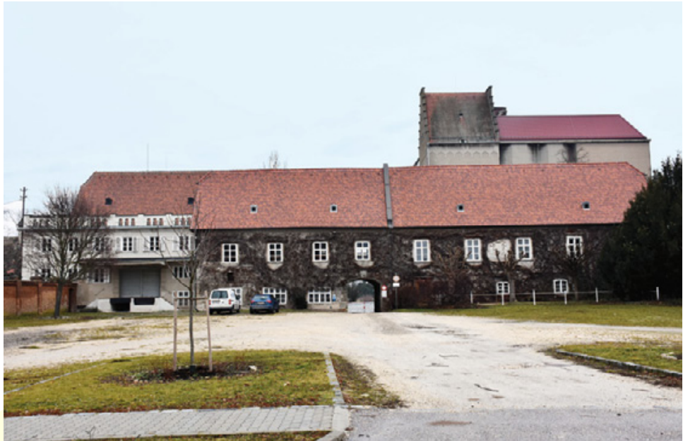
Abb. 15: Laa an der Thaya, Hoffmannmühle. Ansicht des ehemaligen Mühlengebäudes von der Stadtseite (Westen).
