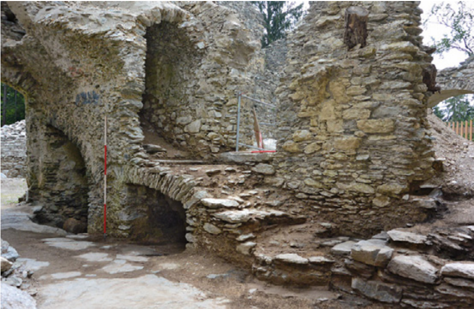
Abb. 7: Umberg (Mnr. 75451.18.01). Treppenhaus in Raum B-II-1.
