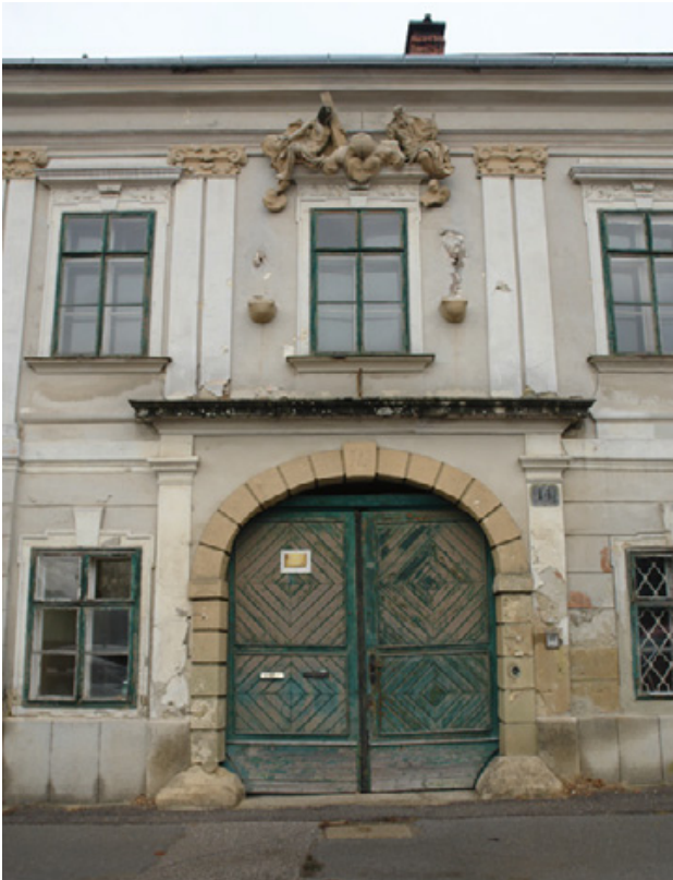
Abb. 42: Stockerau, Bürgerhaus Austrasse Nr. 14. Ausschnitt der Straßenseite mit der Eingangssituation.
