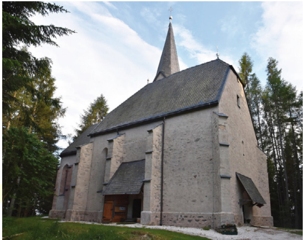
Abb. 13: Wölfnitz, Filialkirche hl. Leonhard an der Saualpe. Ansicht des renovierten Kirchenbaus (Blick von Nordwesten).
