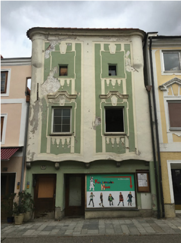
Abb. 3: Enns, Bürgerhaus. Ansicht der spätbarock-frühklassizistischen Südfassade.
