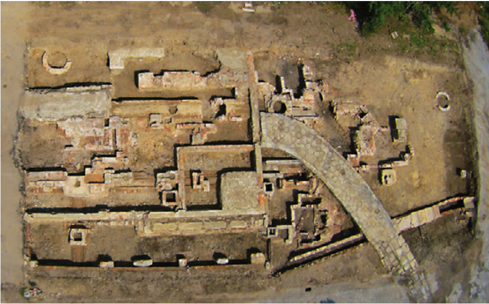
Abb. 1: Baierdorf (Mnr. 63109.18.01). Flaschenabfüllanlage der ehemaligen Reininghausbrauerei und NS-zeitliche Zufahrt (Ansicht gegen Norden).
