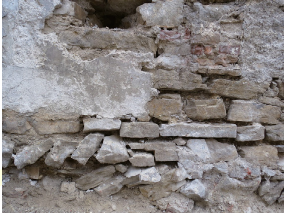
Abb. 1: Innere Stadt, Palais Windisch-Graetz. Mauerwerk des späten Hochmittelalters in der Grundstücksmauer zwischen Nr. 12 und Nr. 10.
