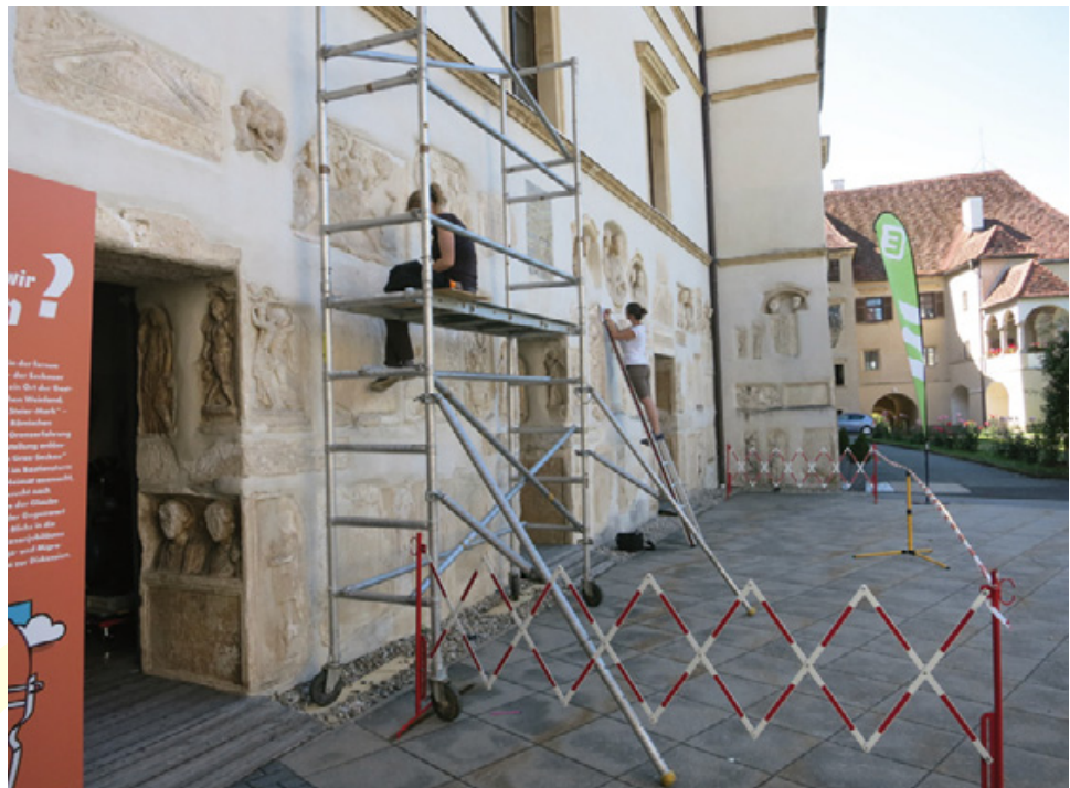
Abb. 19: Leibnitz, Schloss Seggau (Stmk.). Konservierungsarbeiten an der »Römersteingalerie«.
