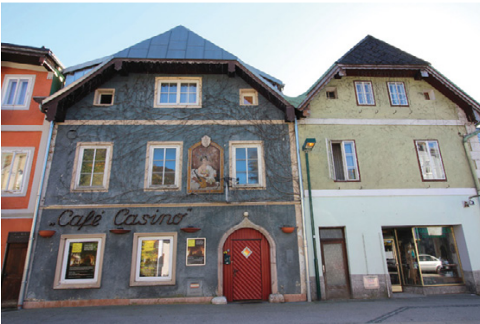
Abb. 1: Bad Ischl, Bräu Griebel Kellerhaus. Fassade des Bräu Griebel Kellerhauses.
