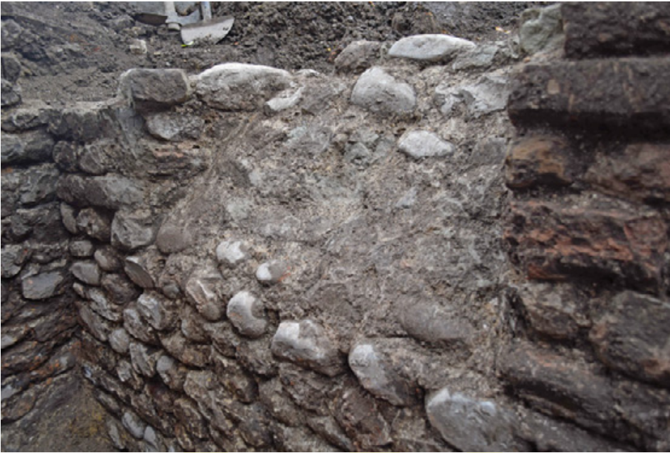
Abb. 2: Bregenz (Mnr. 91103.18.02). Lichteinlass in römischem Mauerwerk.
