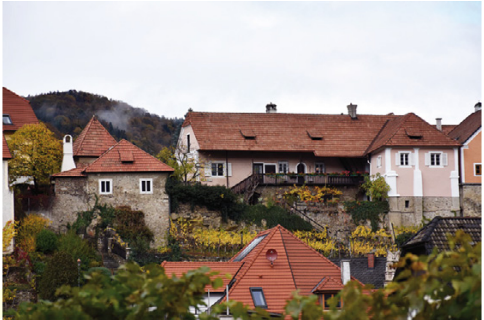
Abb. 50: Weißenkirchen, Bürgerhäuser. Ansicht der Häusergruppe von Süden.
