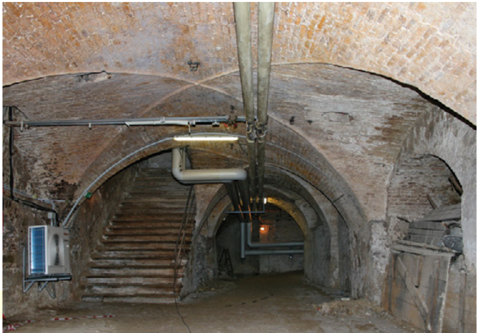
Abb. 3: Innere Stadt, Erzbischöfliches Palais. Renaissancezeitlicher Kellerraum (1579?) im 2. Kellergeschoß (Blick nach Westen).
