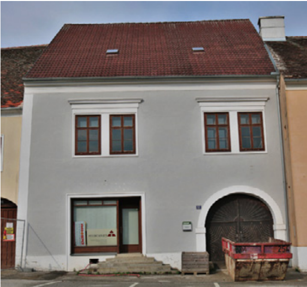
Abb. 1: Stadtschlaining, Bürgerhaus. Fassade zum Hauptplatz mit Doppelfenstern im Obergeschoß aus der Mitte des 17. Jahrhunderts.
