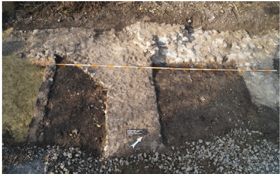
Abb. 2: Enns (Mnr. 45102.15.07). Romanische Fundamentmauern der 1792 abgetragenen Kirche Maria Anger.
