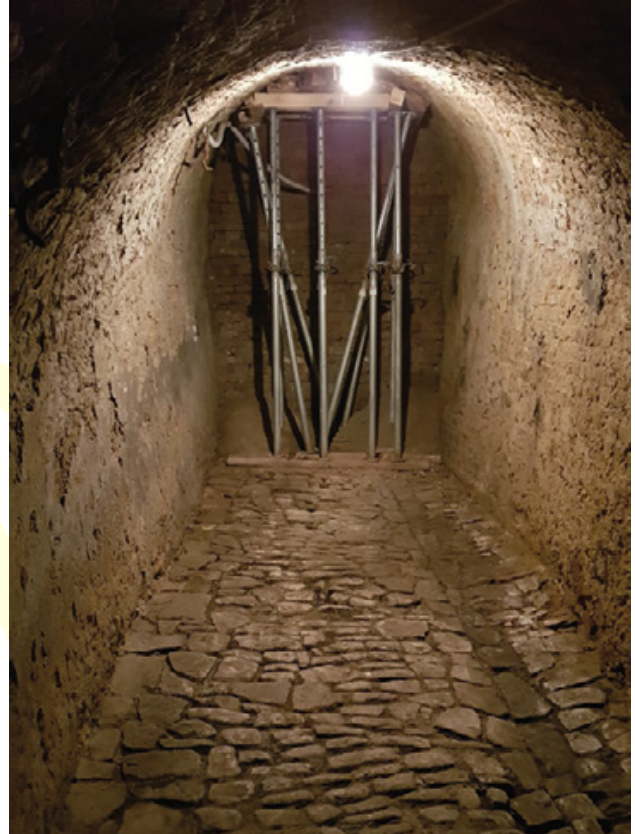
Abb. 18: Wien, Innere Stadt. Gepflasterte Rampe zum unteren rechten Flankenhof der Mülkerbastion.
