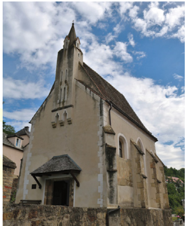
Abb. 37: Stein, Förthofkapelle. Ansicht von Südwesten.
