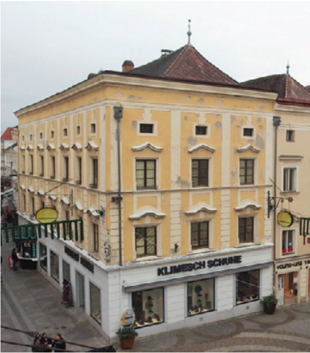
Abb. 11: Krems, Untere Landstraße Nr. 2, Bürgerhaus. Außenansicht von Nordwesten.
