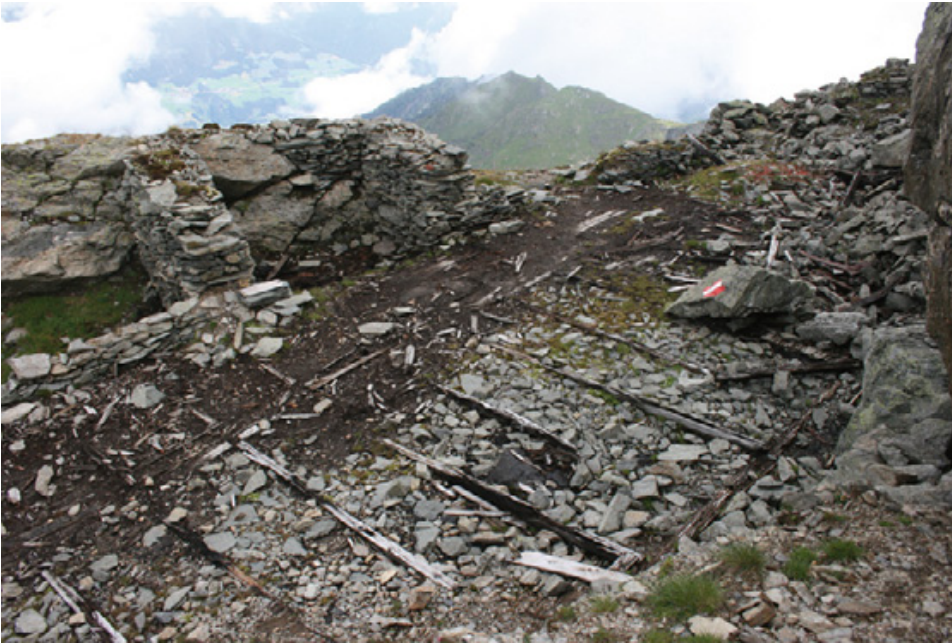
Abb. 4: Hollbruck (Mnr. 85204.18.01). Innenraum der Baracke der Feldwache Schöntalhöhe (Blick Richtung Osten).
