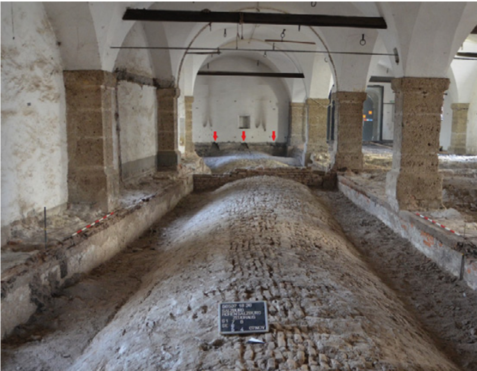
Abb. 8: Salzburg (Mnr. 56537.18.36). Burg Hohensalzburg, Zeughaus. Südschiff mit barockem Gewölbe. Im Hintergrund die Außenseite des sogenannten Schleudertores mit Schießscharten.
