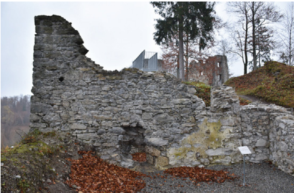
Abb. 5: Hohenems, Burg Alt-Ems. Fertiggestellte Westmauer-Außenseite des Nordwest-Rondells.
