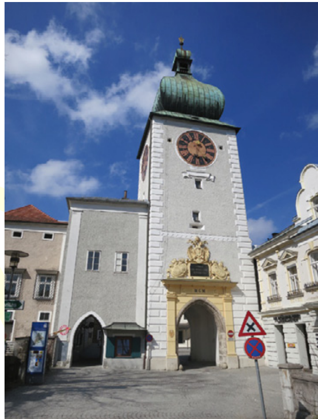
Abb. 48: Waidhofen an der Ybbs, Stadtbefestigung. Feldseite des Ybbsturms.
