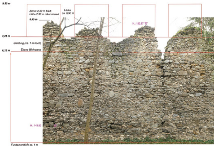
Abb. 21: Marchegg, Stadtbefestigung. Rekonstruktion des Aufbaus der Stadtmauer mit Zinnen.
