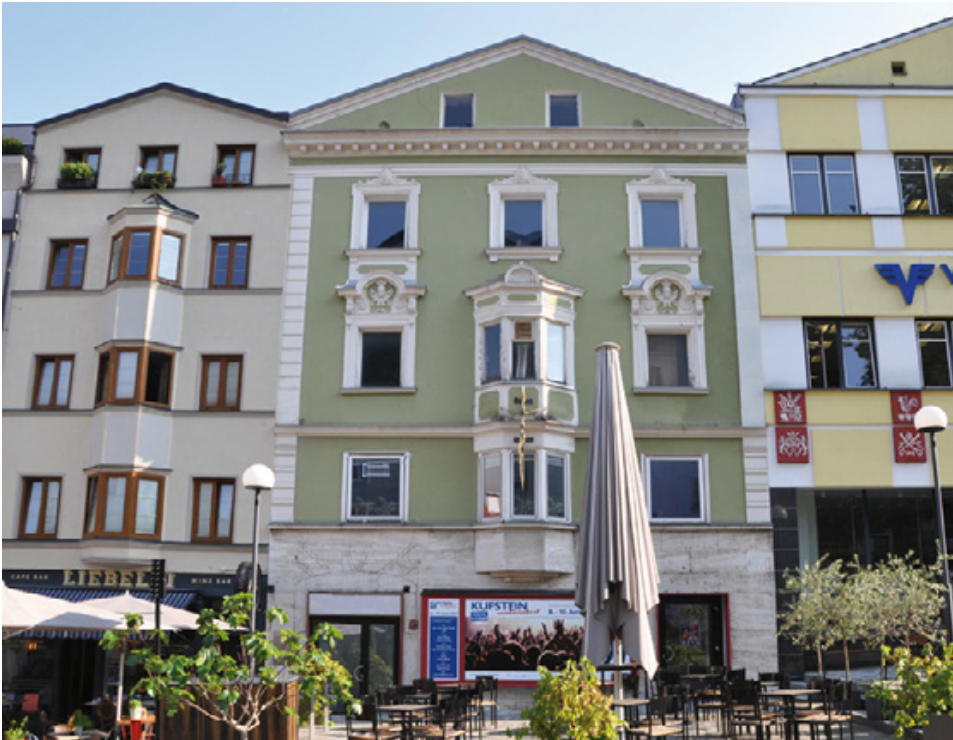
Abb. 3: Kufstein, Gasthaus Goldener Hirsch. Platzseitige Fassade mit historischem Dekor und Neufärbelung des späten 20. Jahrhunderts.
