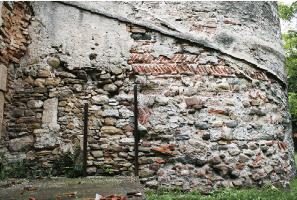
Abb. 46: Traismauer, Marktbe- festigung, Ostfassade des Hungerturms (rechts spätrömisches Mauerwerk, links spätmittelalter- liche Ausbesserung).
