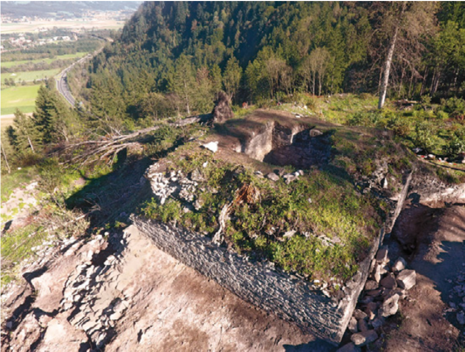
Abb. 5: Sachsenburg (Mnr. 73417.18.01). Der Wehrturm in der unteren Burg nach Grabungsende (Blick nach Südosten).
