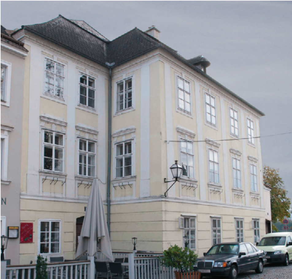
Abb. 35: Stein, Bürgerhaus Schürerplatz Nr. 10. Außenansicht von Nordwesten.
