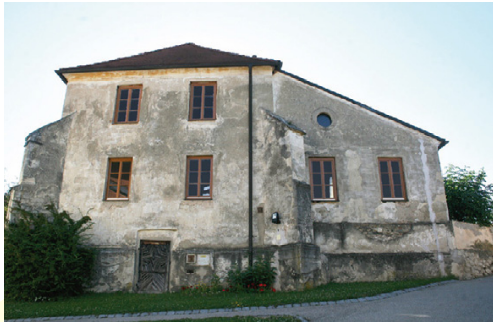
Abb. 19: Lengenfeld, Karner. Ansicht des Karners (links) mit südlichem Anbau (Blick von Westen).
