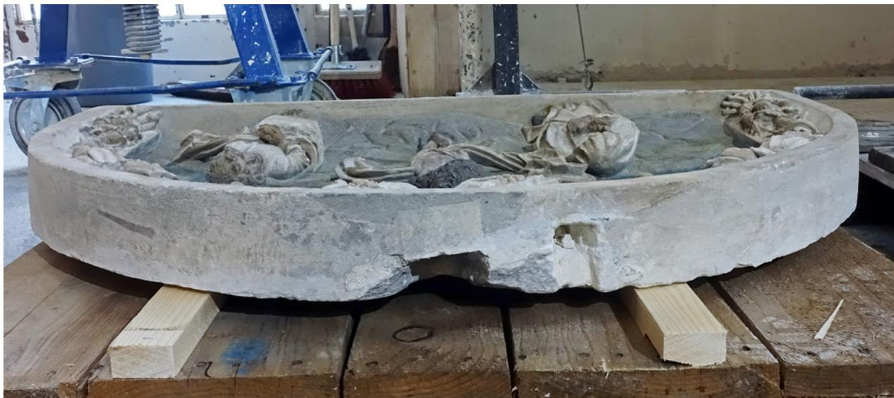
Abb. 7: Rechweinepitaph: Die Aufnahme zeigt die Oberkante der rundbogigen Lünette mit der ursprünglich mittigen Verankerung, die im Zuge einer Versetzung ausgebrochen ist: Daneben befindet sich eine neue Verankerungsstelle
