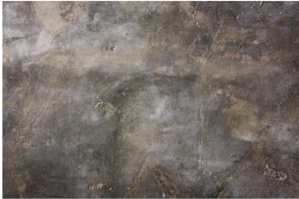
Abb. 3: Vorzustand, oberflächlich aufliegende Weißschleier durch Gipskristallisation
