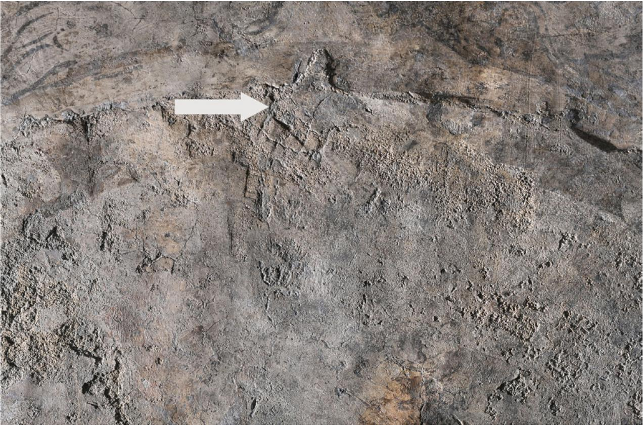
Abb. 3: Ausschnitt aus dem Bogenverlauf mit auffälliger „Putznase“: Diese Störung im älteren Malputz (um 1511) ist vermutlich während der Abnahme des Epitaphs mit einem Werkzeug entstanden
