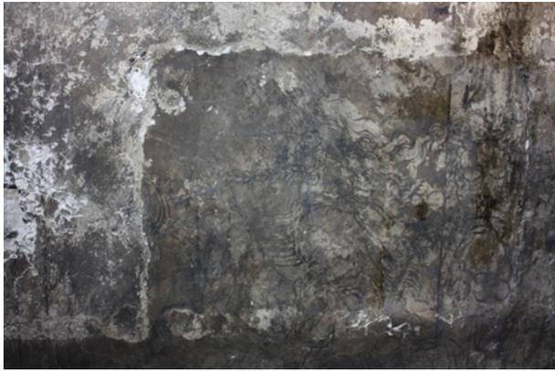
Abb. 7: Vorzustand, linker Bildbereich mit erkennbarem Fugenverlauf der Quadersteine des Trägermauerwerks
