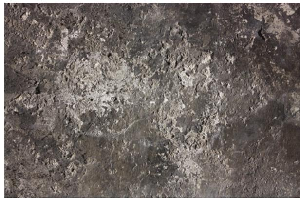
Abb. 6: Vorzustand, Erosion der Malschicht im oberen Bildbereich
