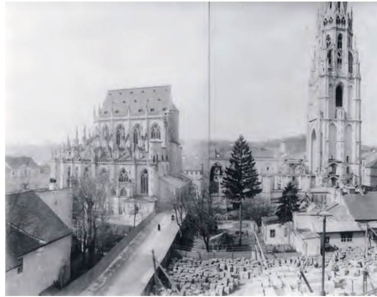
Abb. 6: Zugang zum Dom während des Baus des Langschiffes, 1910
