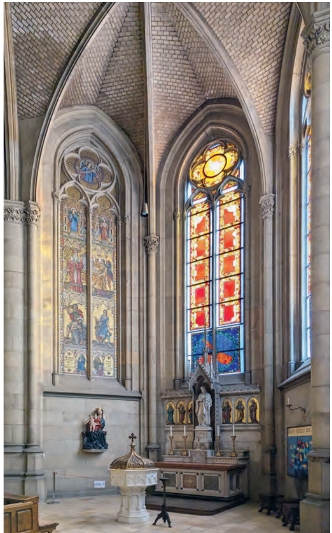
Abb. 5: Linzer Mariendom, dritte Kapelle im westlichen Chorungang, Wand mit Blendmaßwerk
