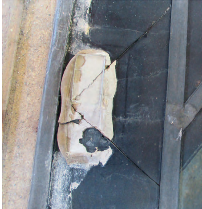
Abb. 4: St. Florian-Fenster, Rechteckfeld 8a, Außenseite, Kittbatzen samt Glasplättchen, nach 1945 behelfsmäßig zur Sicherung am Schnittpunkt zweier Sprünge angebracht
