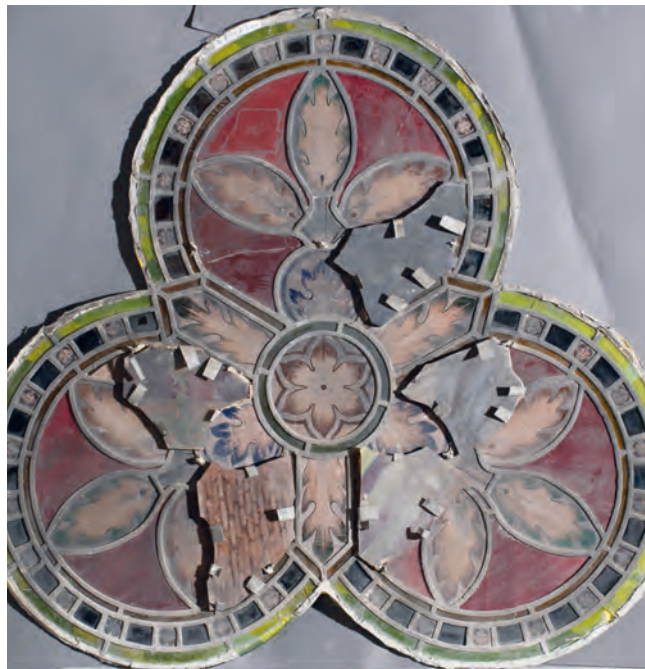
Abb. 5: Biblische Gestalten um Maria I-Fenster, Hochchor, Südostseite, 1884/85, rechter Dreipass im Maßwerk, Innenseite, behelfsmäßig geschlossene Fehlstellen mittels nach 1945 angebrachter „Flickstücke“
