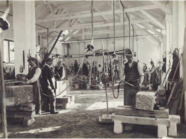
Abb. 3: Steinbearbeitung mittels Pressluft in der Linzer Dombauhütte
