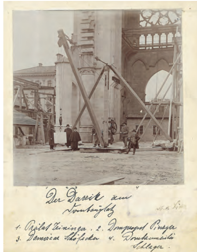
Abb. 4: Amerikanische Hebemaschine „Derrick“ beim Bau des Linzer Mariendoms
