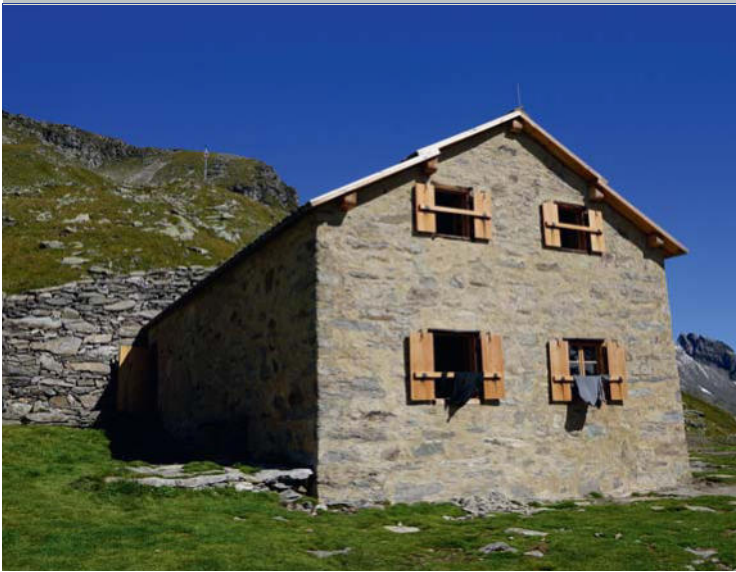
Alte Prager Hütte nach Fertigstellung
