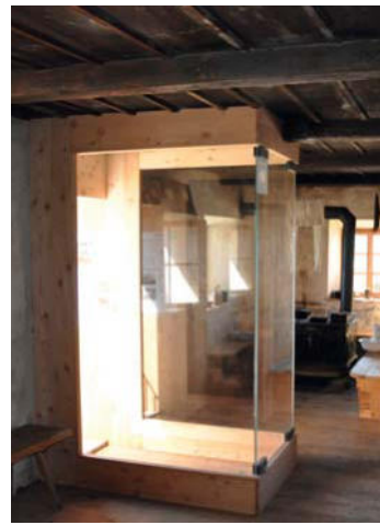
Innenraum mit gläsernem Windfang
