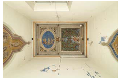
Zustand vor Wiederherstellung
