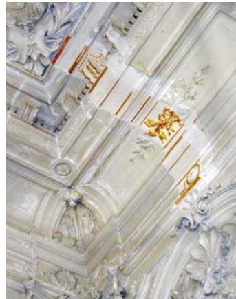
Großer Saal (Freilegung der originalen Deckenfassung)
