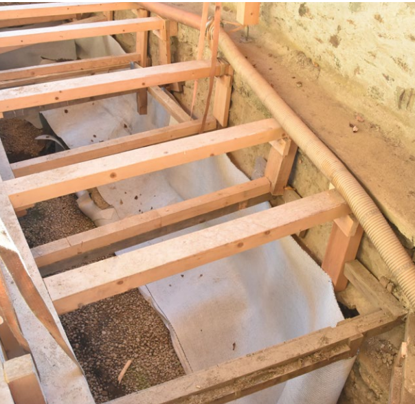
Auffüllung mit Drainageschotter des Schachtes in Raum W im Jahr 2022.
