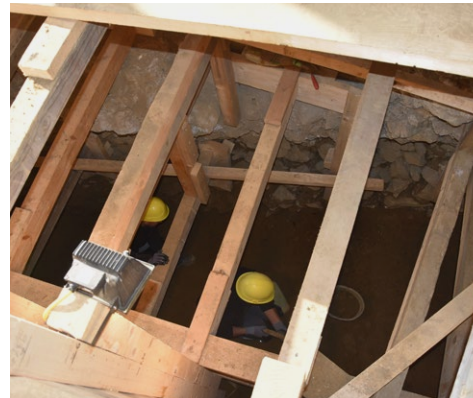
Sicherung des meterhohen Tiefchnittes durch Zimmermannsverschalungen im Raum V.
