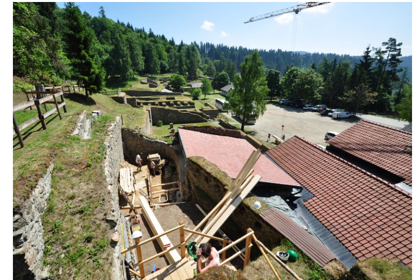
Das Amtsgebäude nördlich der Magdalensberger Forumsthermen am Beginn der Notgrabungen im Jahr 2019, Blick von Westen.
