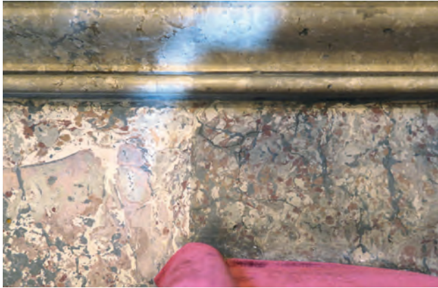
Abb. 5 und 6: Reinigungsproben an der Stuckmarmorausstattung
