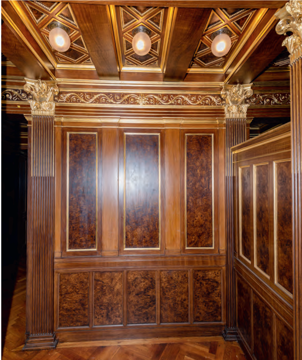
Abb. 5: Bundesversammlungssaal, Galerie, Relief Rankenfries, Detail nach der Fehlstellenergänzung, 2022
