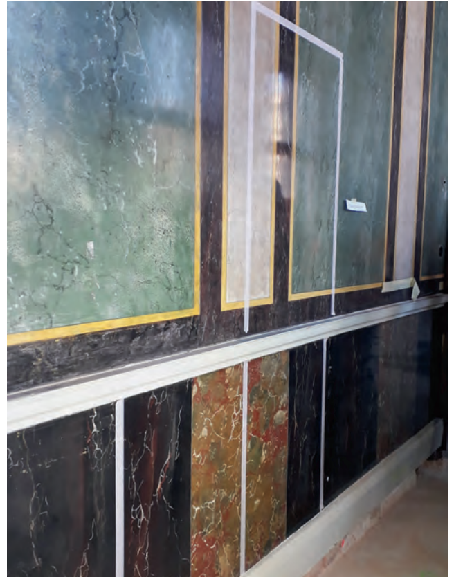
Abb. 7: Abnahme Musterarbeit Stuccolustro in einem Büro der Hauptebene, Aufnahme Februar 2019
