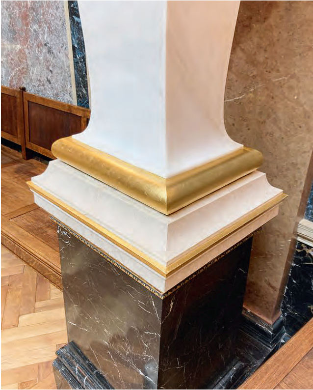
Abb. 4: Natursteinsockel mit Neuvergoldung, Endzustand 2022
