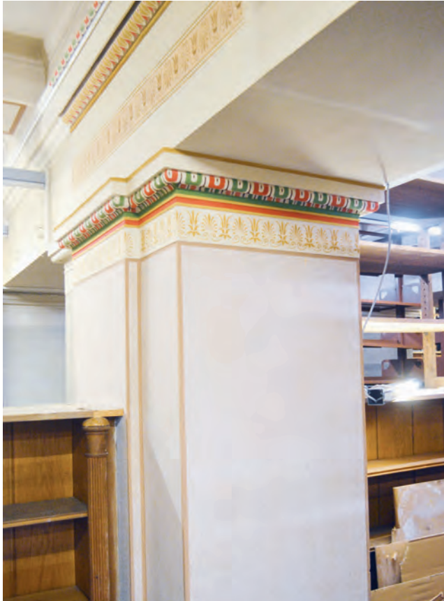
Abb. 10: Teilrekonstruktion der Hansen-Fassung auf Pfeiler und Gebälk, 2017
