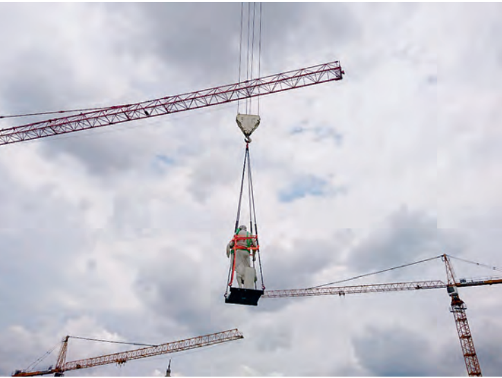
Abb. 2: Demontage der Attikafiguren mittels Kran, Figur „Geodäsie“
