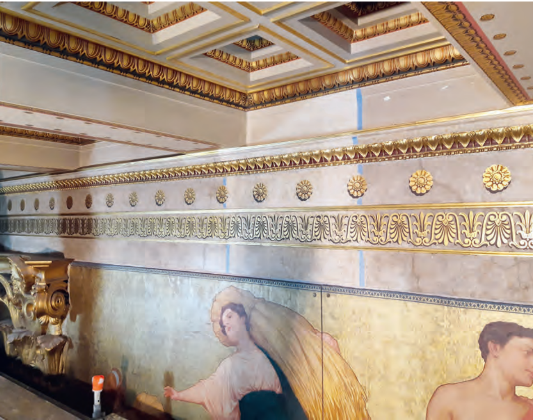
Abb. 10: Abnahme Musterarbeiten Dekorationsmalerei und Marouflagen in der Säulenhalle, Aufnahme Oktober 2020
