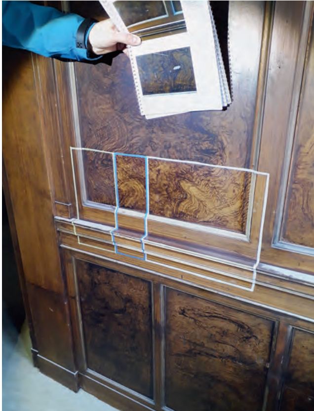
Abb. 6: Abnahme Musterarbeit gefasste Holzoberflächen am Rundgang des Bundesversammlungssaals, Aufnahme Februar 2019
