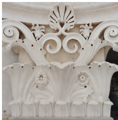
Abb. 5: Sandgestrahltes Kapitell nach der Kittung, Aufnahme 2021
