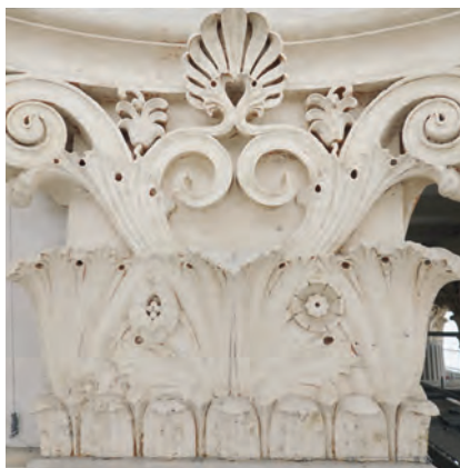
Abb. 4: Sandgestrahltes Kapitell, Aufnahme 2021
