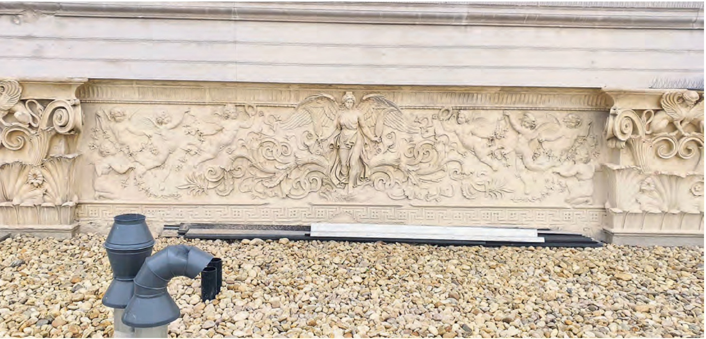
Abb. 4: Natursteinfriese, Endzustand 2022, exemplarischer Ausschnitt
