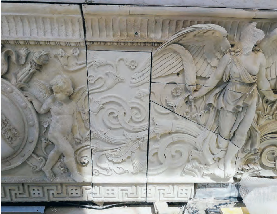
Abb. 3: Natursteinfrieze, eingepasste Rekonstruktionen von Plattenfragmenten
