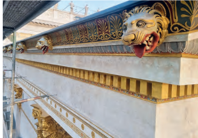
Abb. 8: Hauptgesims nach der Rekonstruktion der Fassung, Aufnahme 2021
