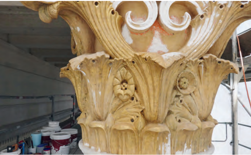
Abb. 3: Ausschnitt vom Kapitell am Eckrisalit mit Reinigungs- und Retuschiermuster, Aufnahme 2021
