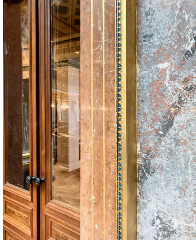
Abb. 5: Türeinfassung mit partieller Neuvergoldung und Rekonstruktion der Polychromie, Endzustand 2022
