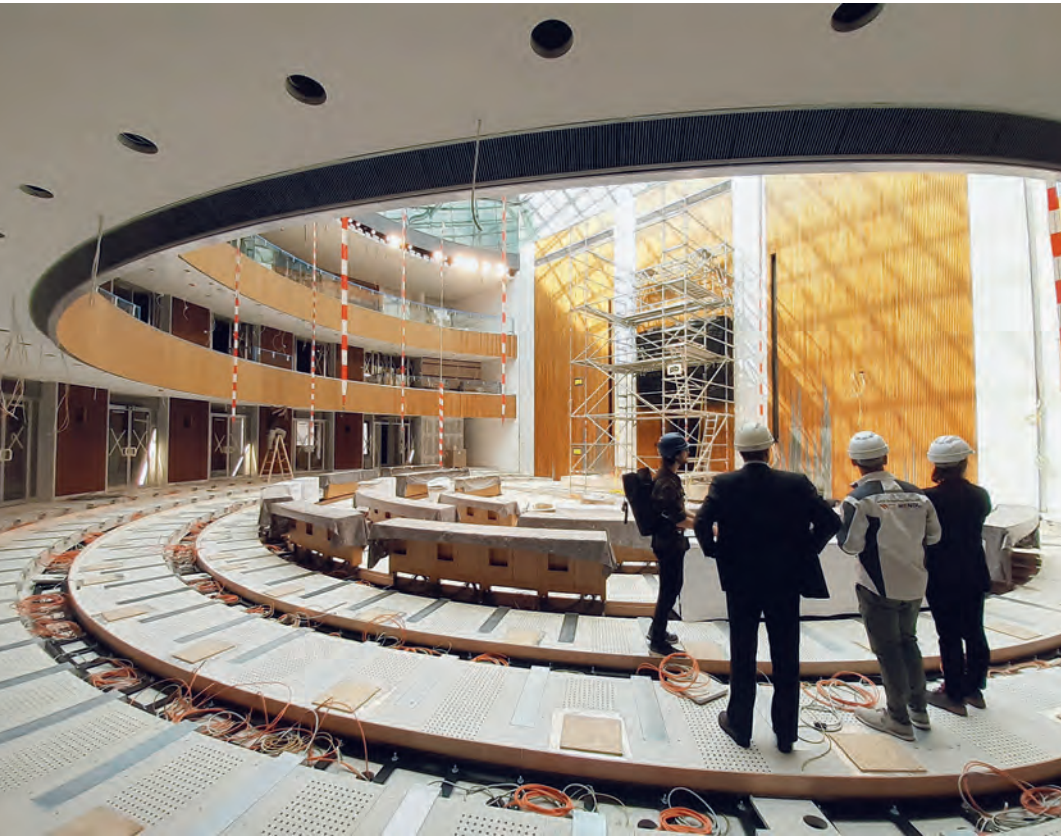
Abb. 12: Aufbau Nationalratssitzungssaal in Arbeit, Aufnahme Oktober 2021
