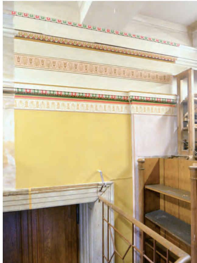
Abb. 9: Teilrekonstruktion der Hansen-Fassung auf der Wand und Architravzone neben dem Eingang, 2023
