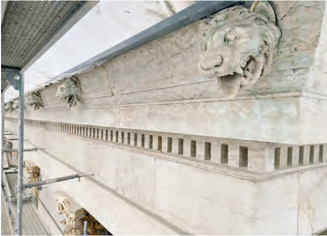
Abb. 7: Sandgestrahltes Hauptgesims, Aufnahme 2021
