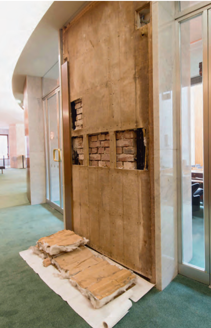
Abb. 2: Befundöffnung und Probedemontage Paneele im Couloir, 2016
