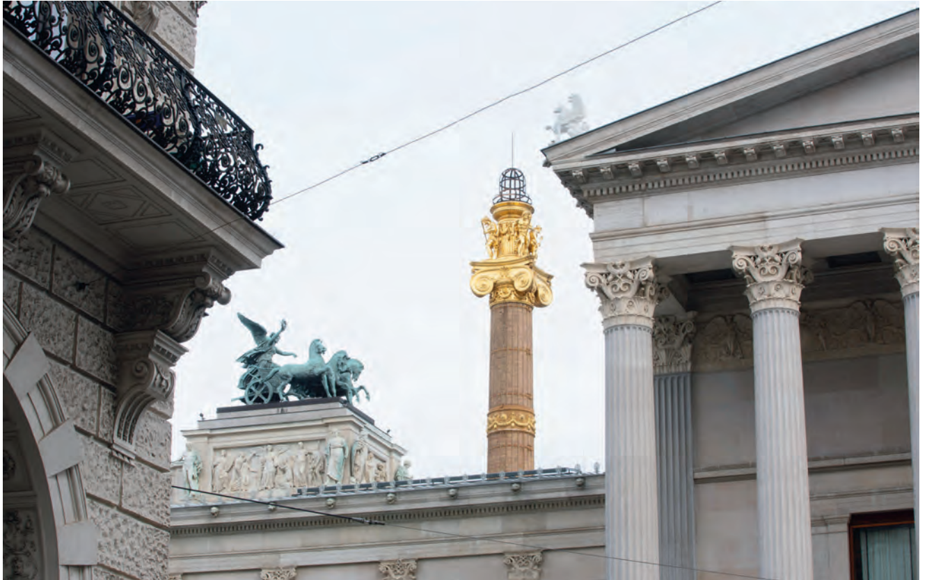
Nr. 12: Blick aus der Doblhoffgasse auf die Westfassade, Quadriga und Schornstein
