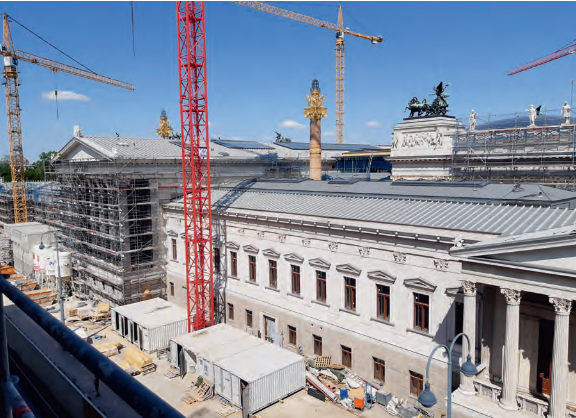
Abb. 11: Westansicht, Dach neu gedeckt und Fassaden- sanierung in Arbeit, Aufnahme Oktober 2021
