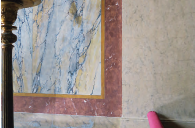
Abb. 3: Ergebnis einer Reinigungsprobe an der Stuccolustroausstattung
