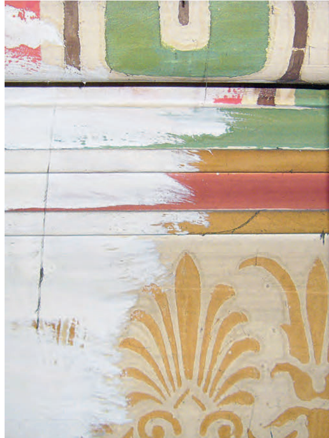
Abb. 6: Befund teilverdeckter Fassung der Fries- und Architravzone, 2006
