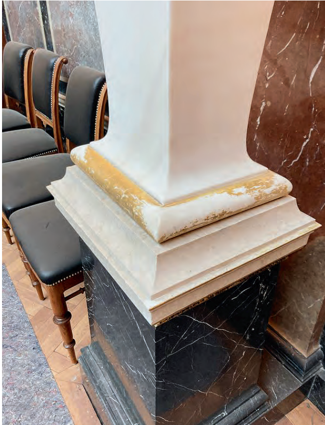
Abb. 2: Natursteinsockel mit Totalverlust der Vergoldung, Vorzustand
