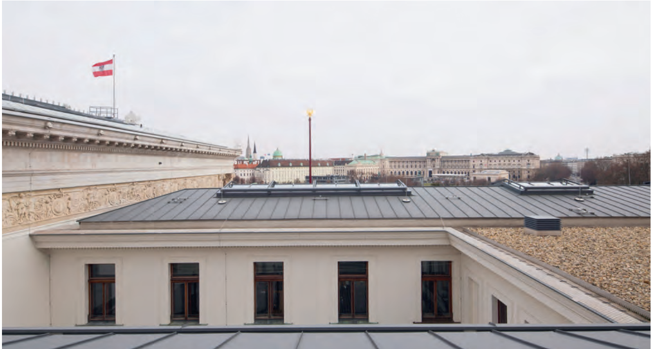
Nr. 44: Dachgeschoß, Blick von einer der vier neu geschaffenen Terrassen auf den Hofburgkomplex sowie die Türme von Stephansdom und Michaelerkirche
