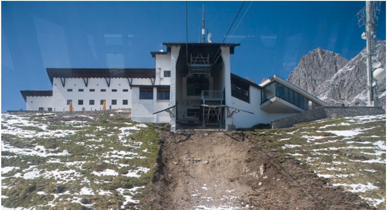
Mittelstation Seegrube während der Bauarbeiten
