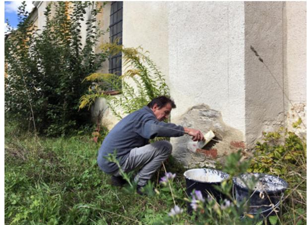
Abb. 154: Wartungsarbeiten in der Sockelzone mit Kalkschlämme (holzgebrannter Sumpfkalk mit Natursand), Kreuzgarten Kartause Mauerbach
