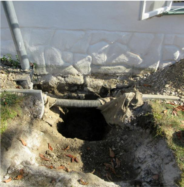
Abb. 171: Wullersdorf, NÖ, an falscher Stelle liegende und unsachgemäß ausgeführte Drainage trägt zu Feuchteschäden bei
