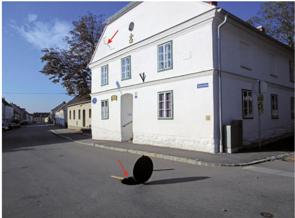
Abb. 172: Wullersdorf, NÖ, durch Kanalbau (siehe Pfeil) verursachte Setzungsrisse von der Giebelmauer (zur deutlicheren Sichtbarkeit im Bild nachgezeichnet) innenseitig bis ins Erdgeschoß verlaufend
