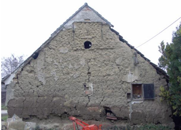
Abb. 163: Obersulz, NÖ, Nr. 5, *Lehmwuzel*-Mauer eines Presshauses (2015 abgebrochen), Aufnahme 2014
