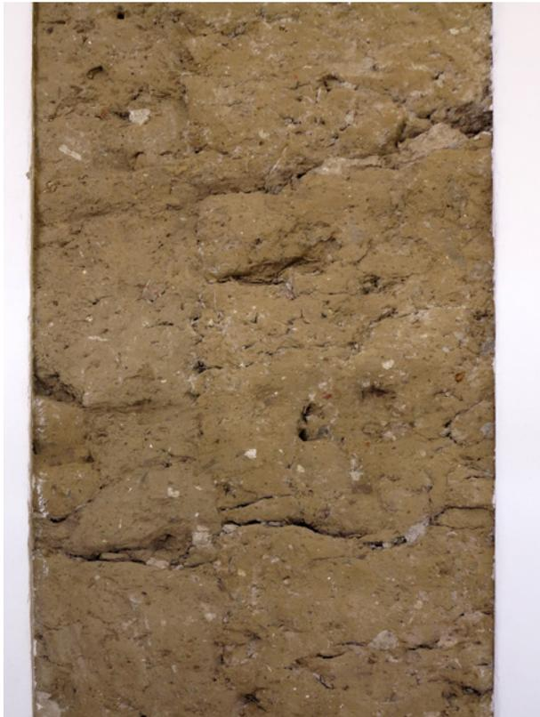
Abb. 157: Poysdorf, NÖ, Eisenhuthaus, Ausschnitt aus einer *gesetzten* Mauer mit sichtbaren Satz­fugen
