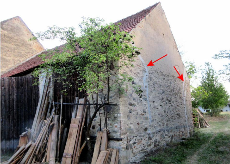
Abb. 173: Kühnring, NÖ, mit hellem Mörtel ausgebesserte, breite Risse (siehe Pfeile) zeigen Mauerwerksschäden durch seitlichen Schub des Dachstuhls infolge defekter Bundtramm-Verankerung
