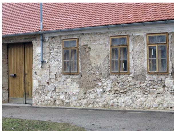
Abb. 165: Parisdorf, NÖ, Mischmauerwerk eines Hauses
