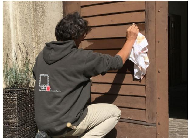
Abb. 155: Pflegen des Leinölanstrichs auf Holz durch Nachölen mit Leinölfirnis, um den in der Oberfläche durch Bewitterung abgebauten Bindemittelanteil wieder rückzuführen
