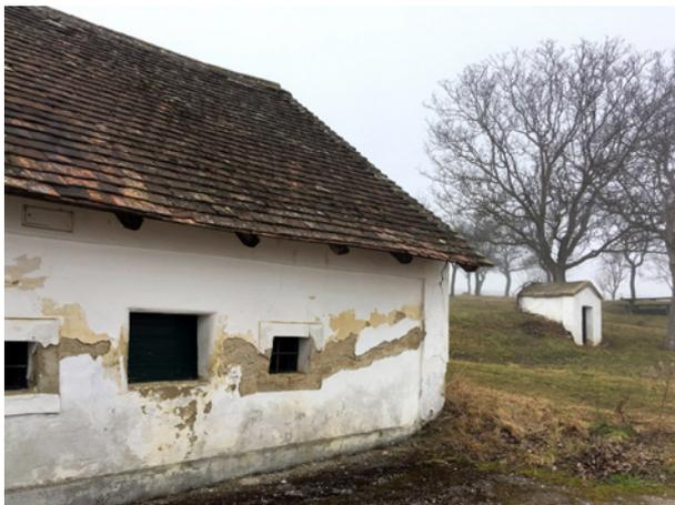
Abb. 150: Poysdorf, NÖ Kellergasse Alte Geringen, Presshaus aus Lehmziegel mit Lehmputz und Kalkanstrich
