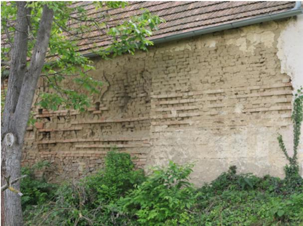
Abb. 166: Gösing, NÖ, Mauer in Sparbauweise
