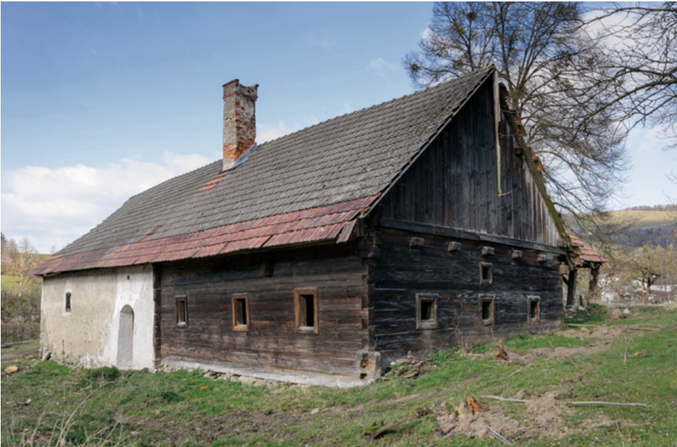
Abb. 7: Krumbach (NÖ). Spätmittelalterliches Gehöft Tannbauer in Unterhaus (Blick Richtung Nordosten).
