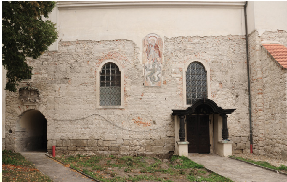
Abb. 23: Reinprechtspölla (Mnr. 10128.15.01). Ausschnitt des abgeschlagenen Außenwandbereichs der Pfarrkirche hl. Pankraz mit romanischer Langhaussüdmauer, barockem Westturm (links) und östlichen Erweiterungsanbauten (rechts).
