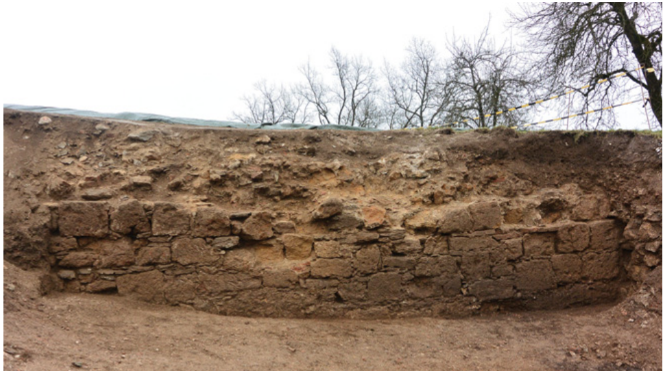
Abb. 7: Seggauberg (Mnr. 66172.15.01). Spätmittelalterlich-frühneuzeitliche Basteimauer (SE 4) des Schlosses Seggauberg.
