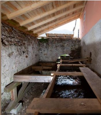
**Über dem Wasserradhof** wurde ein Pultdach zum Schutz der Holzkonstruktion errichtet, das sowohl vor starker Sonneneinstrahlung im Sommer als auch vor Schnee und Eis im Winter schützt. Dass ehemals ein derartiges Pultdach zum Schutz des Radgrabens vorhanden war, ließ sich an einer Mauerbank an der Fassade der Schmiede ablesen.
