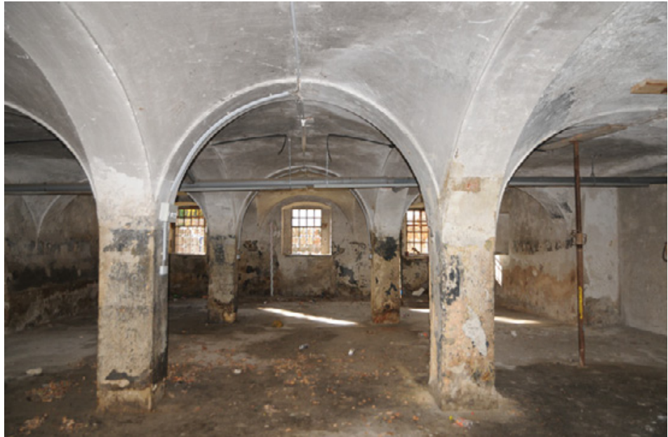
Abb. 16: Lichtenwörth, Nadelburg. Ehemaliger Pferdestall im Erdgeschoßraum 02 des »Langen Ganges« (Blick gegen Süden).
