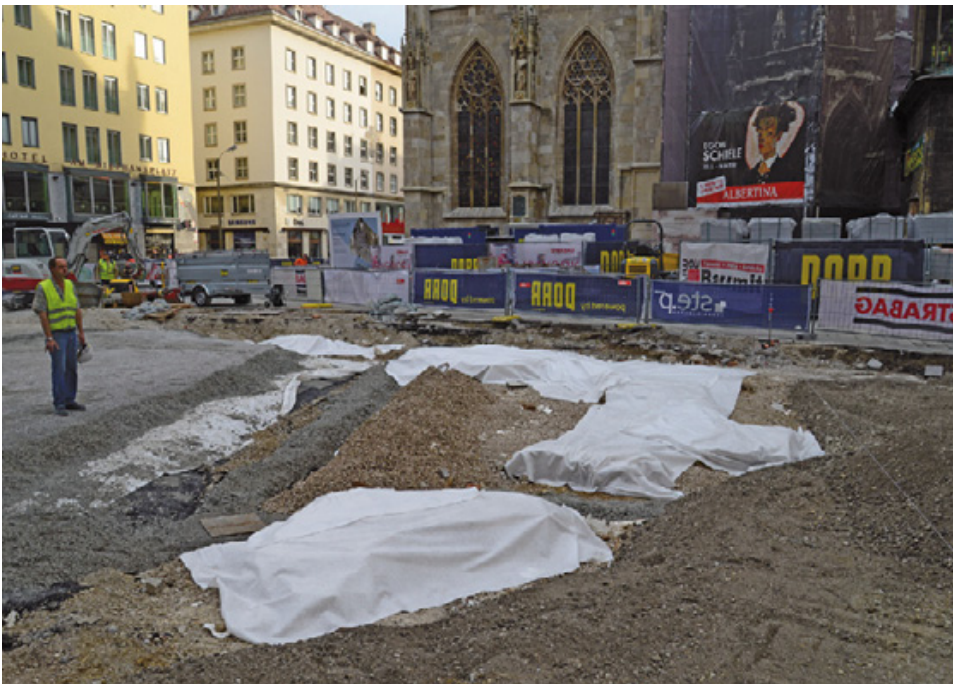
Abb. 16: Wien, Innere Stadt. Sicherungsmaßnahmen über der Virgilkapelle.
