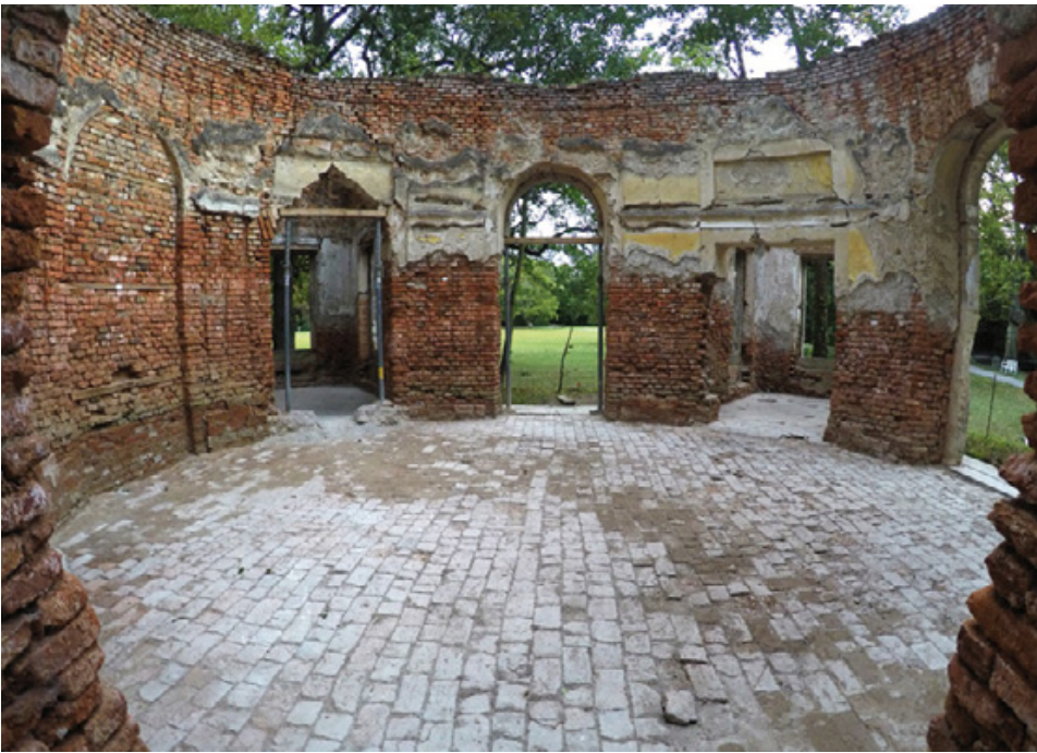
Abb. 17: Laxenburg (Mnr. 16117.17.01). »Haus der Laune« im Schlosspark Laxenburg. Blick in den ellipsoiden Zentralraum mit Ziegelsubstruktion für den abgenommenen Kalksteinplattenboden.
