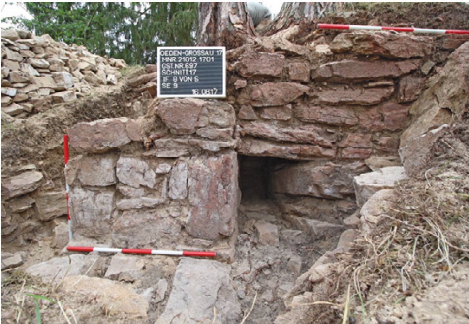
Abb. 10: Großau (Mnr. 21012.17.01). Westliche, ›kielförmig‹ ausgeprägte Beringecke des Kernwerks (feldseitig) mit Resten einer Laibung und daran ansetzenden Schwellensteinen. Unmittelbar daran anschließend eine tiefe Nische (Riegelkasten?), welche die gesamte Ringmauer bis zum anstehenden Felsstock durchzieht.
