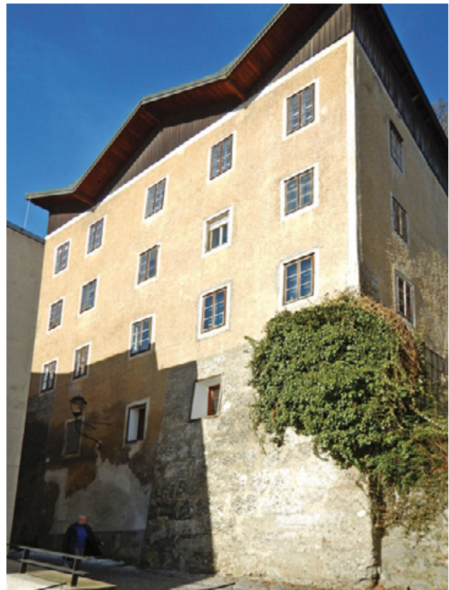
Abb. 7: Salzburg, Bürgerhaus Steingasse Nr. 69. Straßenansicht des Gebäudes.
