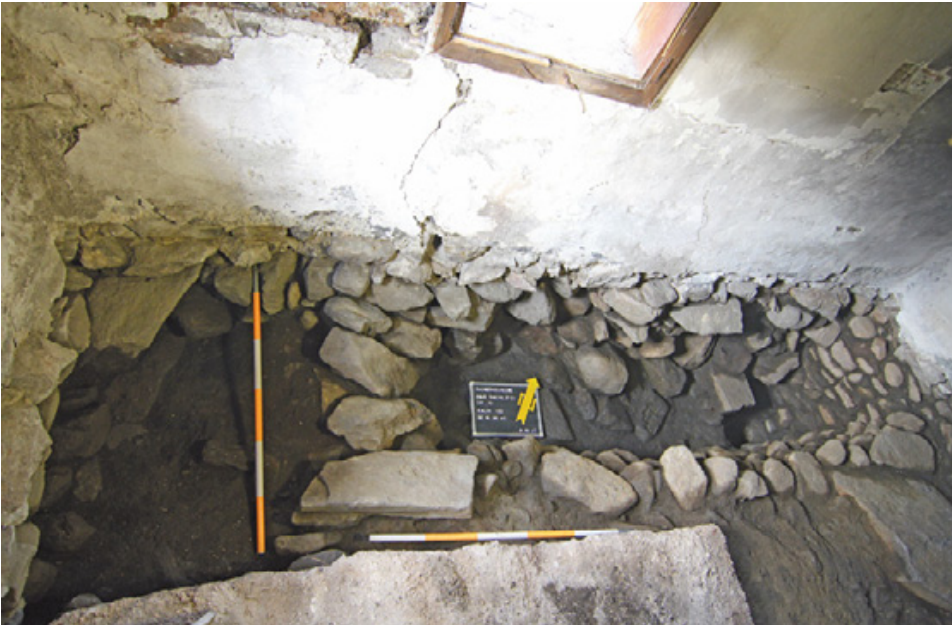
Abb. 8: Ramingstein (Mnr. 58019.17.01). Die wohl als Keller anzusprechende Mauerung im nordwestlichen Raum der Rainerkeusche. Die rezente Gebäudenordmauer sitzt auf der Kellerverfüllung auf, während außerhalb des Kellers ein annähernd lagiges Fundamentmauerwerk sichtbar ist (Ansicht von Südwesten).
