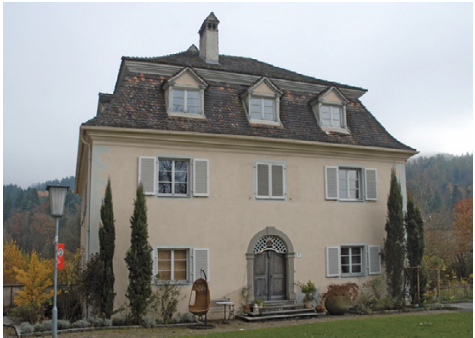
Abb. 1: Bregenz, Praebendehaus. Ansicht des Gebäudes.
