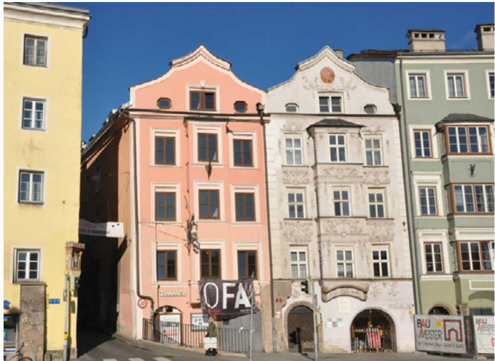
Abb. 5: Innsbruck, Gasthaus »Zum Einhorn«. Das Gebäude und seine Nachbarhäuser (Ansicht von Westen).
