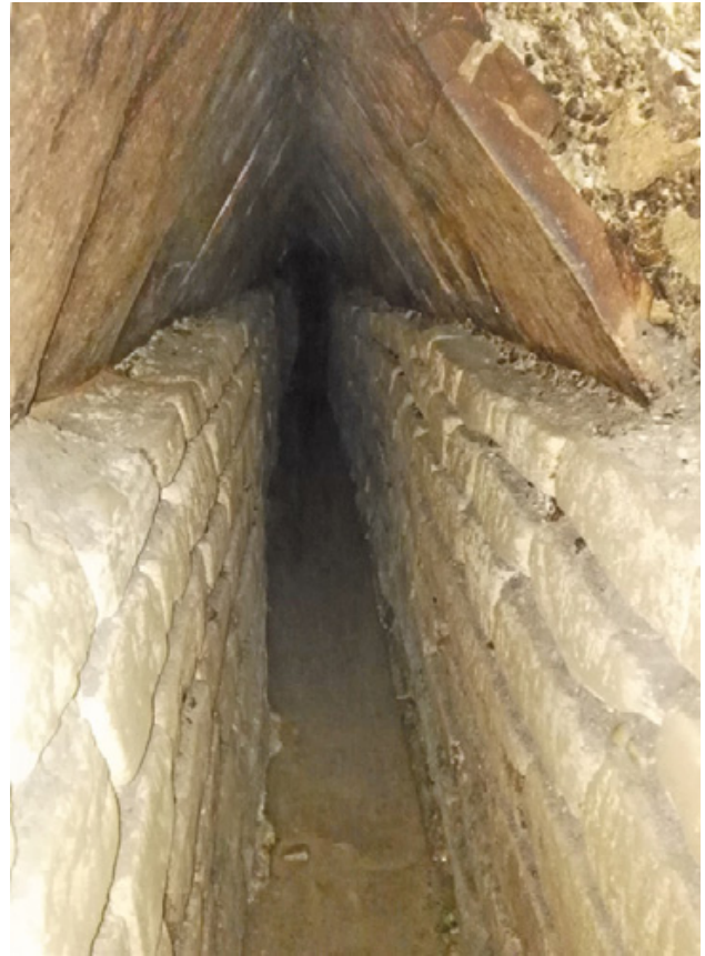
Abb. 21: Petronell (Mnr. 05109.17.08). Blick in die römische Wasserleitung (nach Westen) mit originaler Überdeckung.
