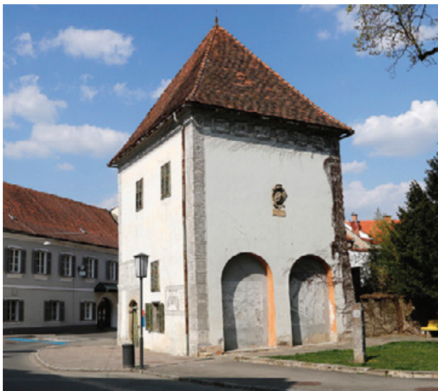
Abb. 1: Radkersburg, Puchhaus. Außenansicht des Gebäudes.
