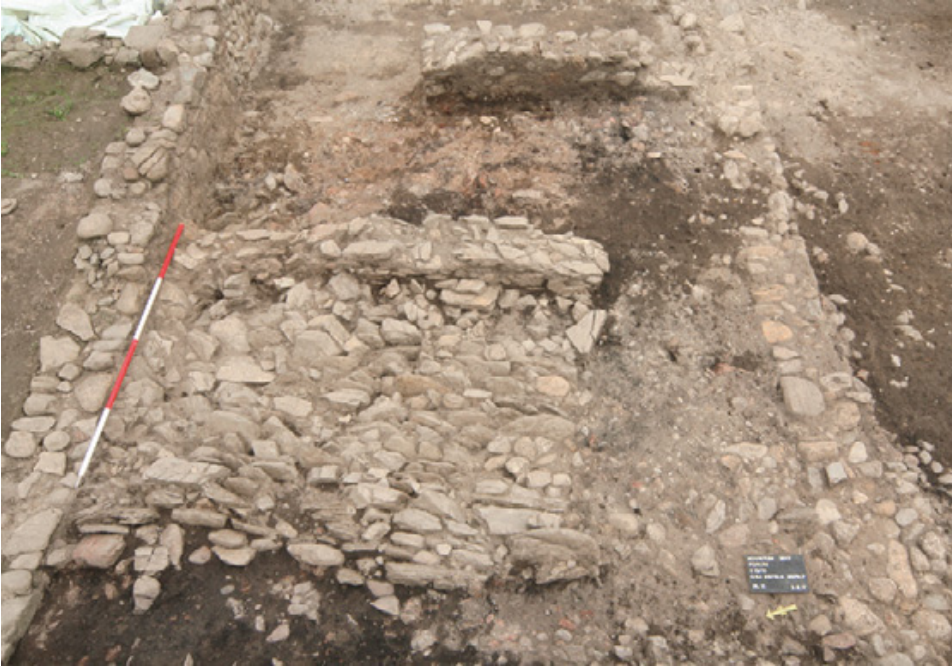
Abb. 9: Stribach (Mnr. 85034.17.01). Forum, nördlicher Umgang R 292. Ostteil des Ganges mit sekundär eingefügter Mauer in Sturzlage (Ansicht von Westen).
