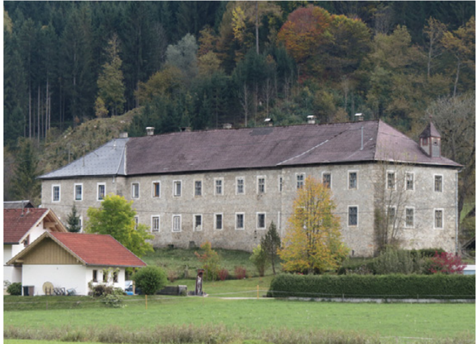
Abb. 1: Bruggen, ehemaliges Hieronymitenkloster Waisach. Nordwestansicht des bestehenden Gebäudes.
