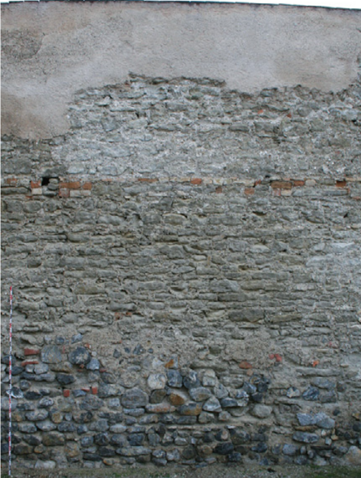
Abb. 9: Großenzersdorf, Stadtbefestigung. Primäres Kompartimentmauerwerk der Stadtmauer mit Ziegelabschluss auf der Höhe des ersten Wehrgangs, darüber die Aufzonzung um 1400 (Gst. Nr. 27/2); unten Ausbesserung des 20. Jahrhunderts.
