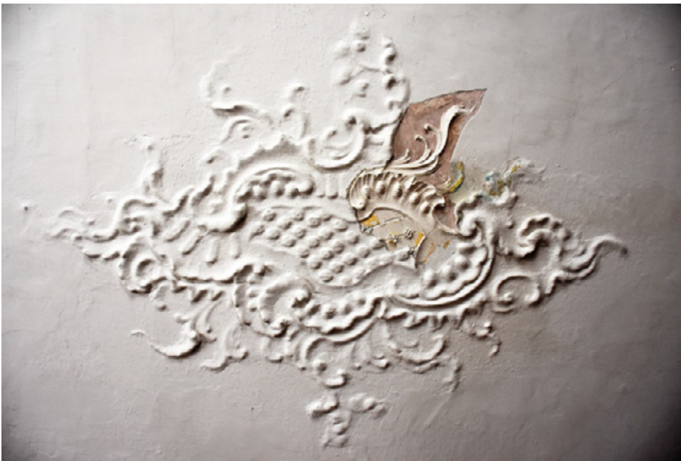
Abb. 10: Straßburg Stadt, Pfarrhof Lieding. Detailaufnahme des teilweise freigelegten zentralen Stuckfeldes in Raum 1.05.
