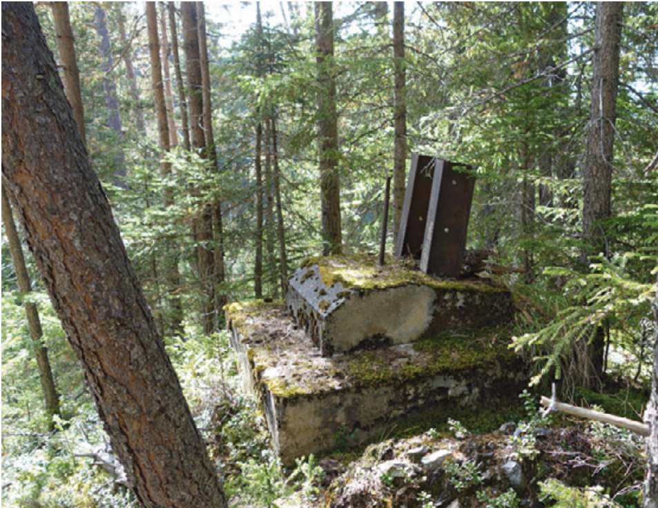
Abb. 4: Haiming (Mnr. 80101.17.02). Betonsockel mit Stahlträger einer Stütze der Materialseilbahn über den Amberg.
