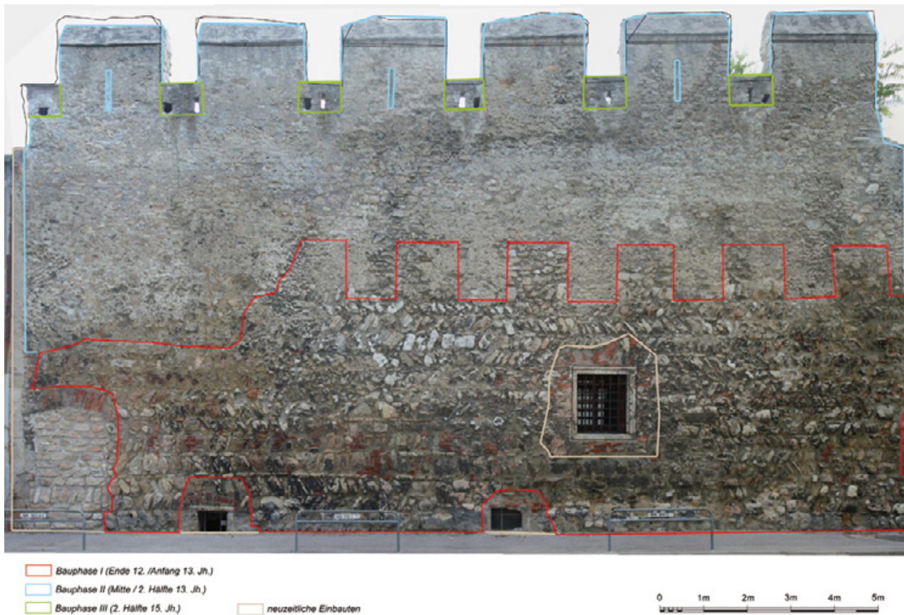
Abb. 43: Wiener Neustadt, Stadtbefestigung. Feldseite der Stadtmauer mit Kartierung der Bauphasen (Bereich Beethovengasse).
