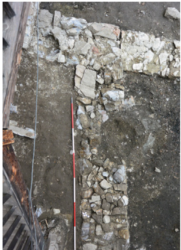
Abb. 3: Friesach (Mnr. 74302.17.01). Mauerwerk des romanischen Kernbaus (SE 141).
