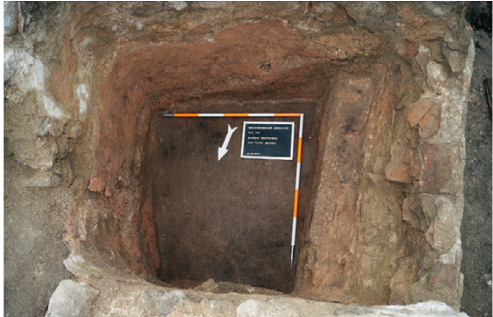
Abb. 1: Engelhartszell (Mnr. 48004.17.01). Wasserbecken im Westturm des Quadriburgus von Oberranna.
