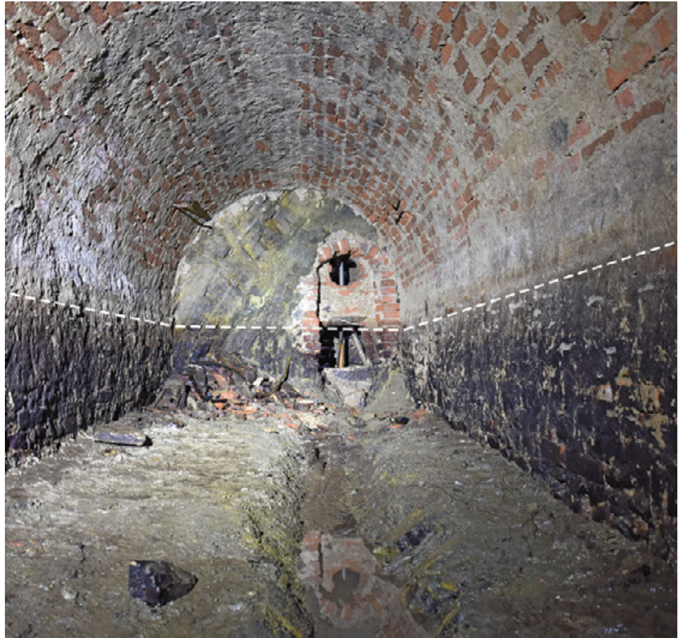
Abb. 33: Thaya, Haidlkeller. Blick gegen Westen in die geleerte Tankzisterne (August 2016). Am Ende des Gewölbes ist die Öffnung zum Brunnenschacht erkennbar, am Boden die noch mit Wasser gefüllte Abflussrinne sichtbar. Die strichlierte Linie markiert den derzeitigen Wasserhöchststand.
