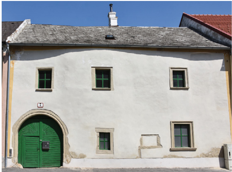
Abb. 3: Bruck an der Leitha, Bürgerhaus Burgenlandstraße Nr. 7. Ansicht der Südfassade.
