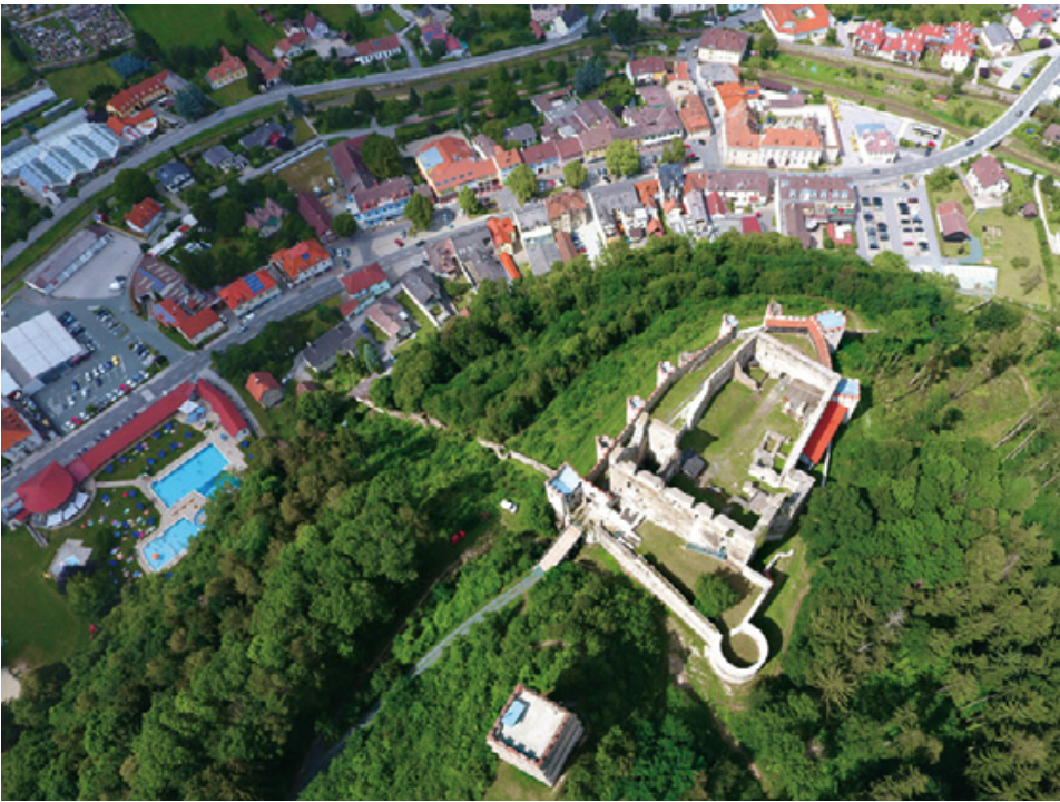
Abb. 11: Kirchschlag, Marktbefestigung. Luftaufnahme der Buranlage mit talwärts führender Ringmauer. Im Talboden der von der Marktmauer umschlossene Innere Markt.
