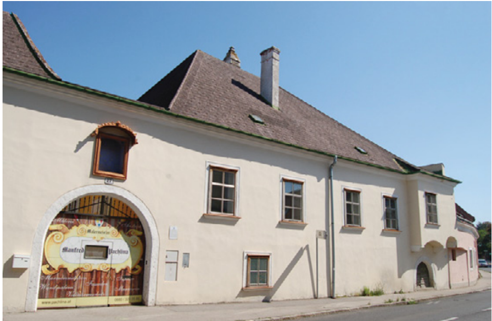
Abb. 18: Maria Enzersdorf, Schnepfenhof. Straßenfassade.
