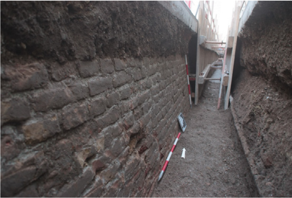
Abb. 7: Innere Stadt (Mnr. 01004.17.15). Ziegelschale der frühneuzeitlichen Kurtine vor dem Haus Dominikanerbastei Nr. 16.
