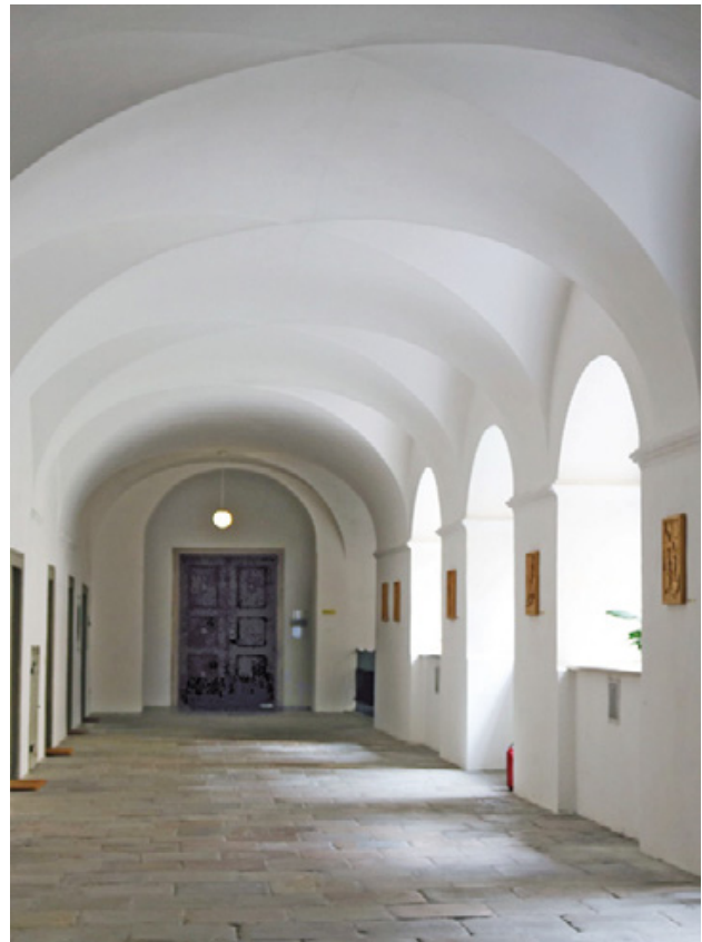
Abb. 31: Seitenstetten Markt, Stift Seitenstetten. Nördlicher Kreuzgangarm (Blick nach Osten).
