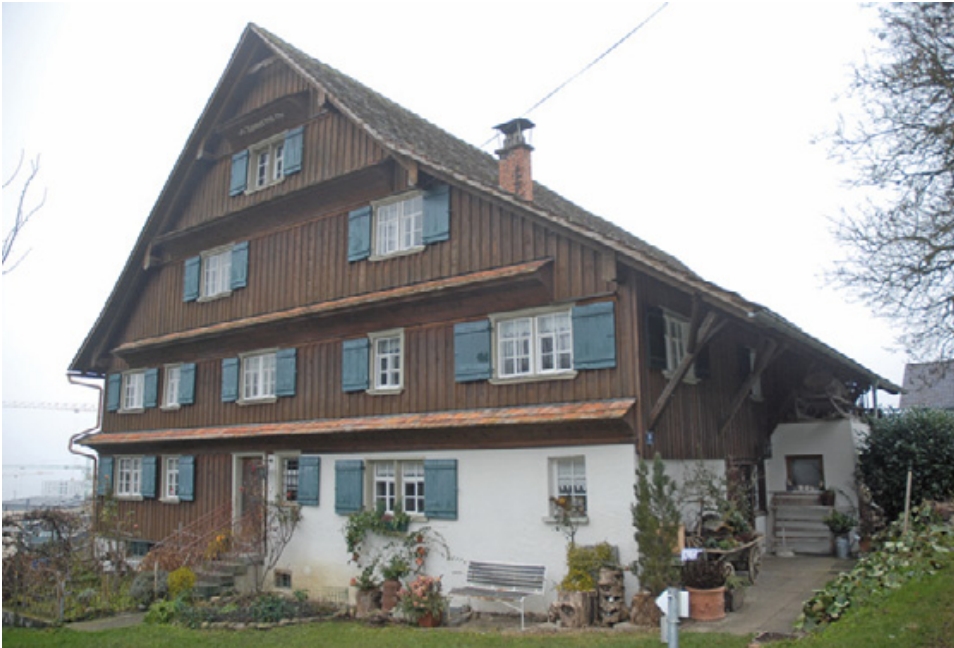
Abb. 3: Lochau, Milzhaus. Südfassade des Bauernhauses mit Klebdächern; Schalungsbretter, Fensterläden und Vorfenster wurden 1998 erneuert.
