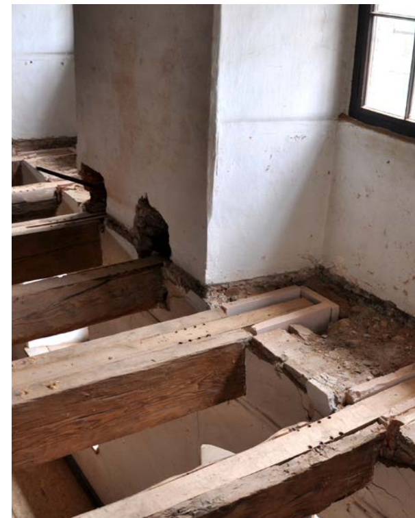
Balkenkopfsanierung
