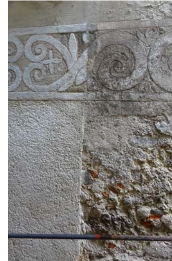
Musterfläche zur Restaurierung der Sgraffitofassade (Detail)
