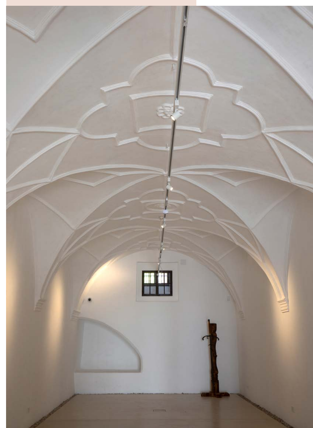
Gewölberaum im Erdgeschoss
