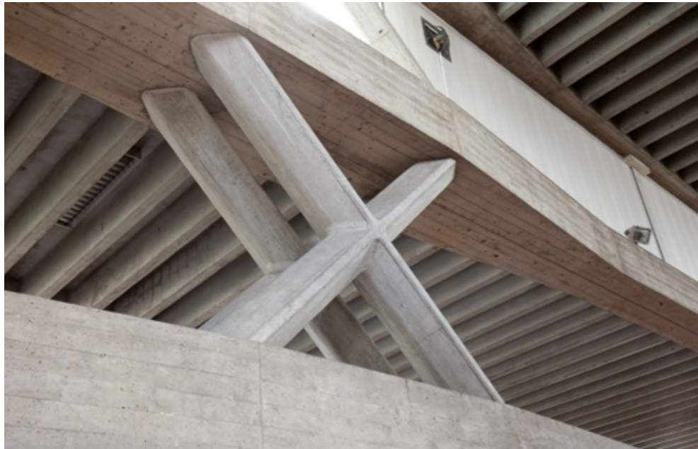
X-förmige Stützen aus schalrein belassenem Beton © BDA, Foto: Irene Hofer
