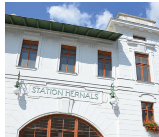
Station Hernalds mit Türen und Fenstern im rekonstruierten historischen Erscheinungsbild © BDA, Foto: Robert Linke
