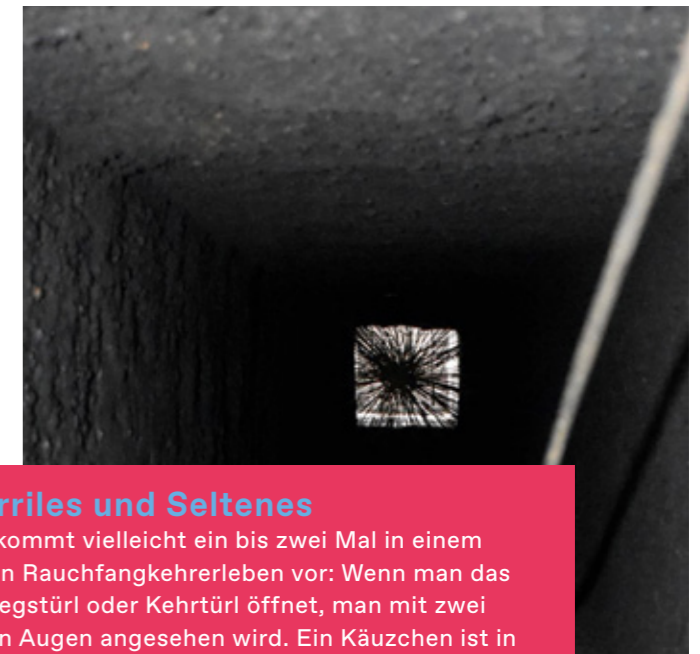
Reinigen mit der Schlieferbürste im Rauchfang © Andrea Fraiss
