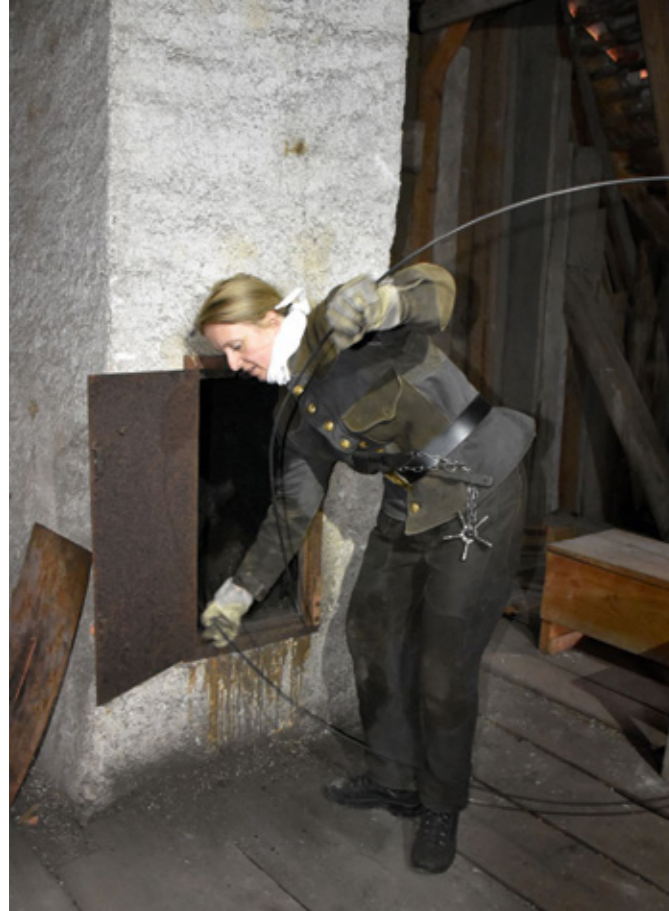
Reinigen mit der Schlieferbürste © Andrea Fraiss
