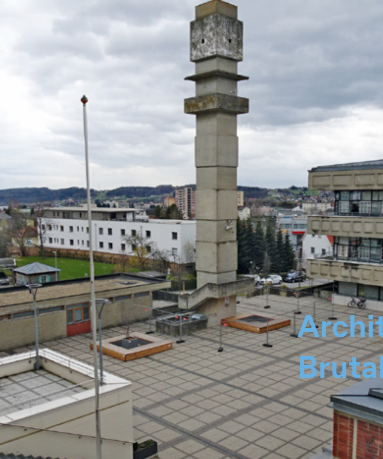
Neue Mittelschule Weiz, Steiermark, 1965 bis 1968 errichtet von Viktor Hufnagl © BDA, Foto: Sabine Weigl
