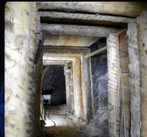
Der Zugang zur Fundstelle Enderwerk (Mi.) nach der Sanierung © H. Reschreiter/NHM Wien
