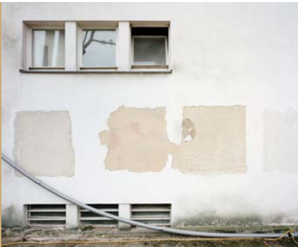
Probeflächen zur Freilegung der historischen Fassadenoberfläche
