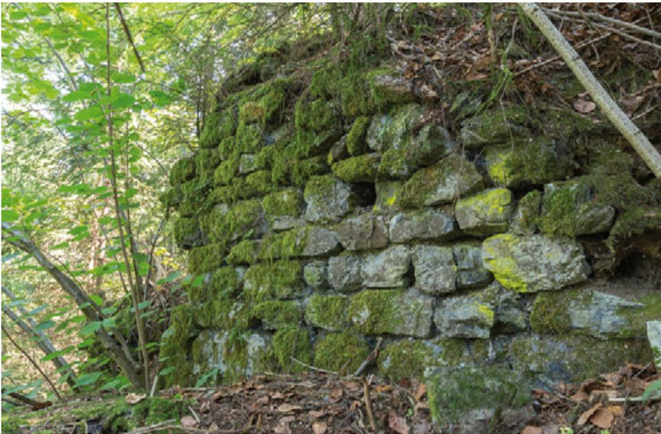
**Abb. 7:** Möderndorf, Burgruine Malenthein. Quaderhaftes, streng lagiges Mauerwerk der Bauphase I (12. Jahrhundert; Blick Richtung Südosten).
