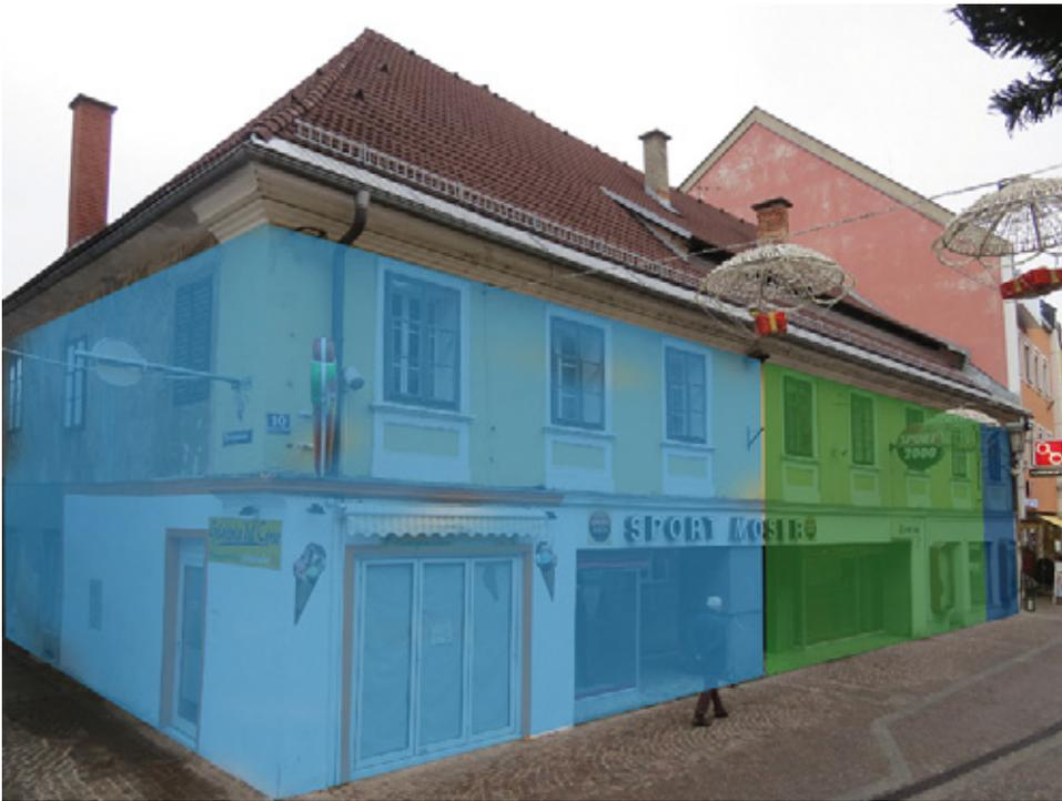
**Abb. 9:** St. Veit an der Glan, Haus Unterer Markt Nr. 10. Ansicht des Gebäudes mit farblich unterlegten Bauphasen (hellblau – Kernbau, grün – erste Erweiterung, dunkelblau – Stadtmauer).
