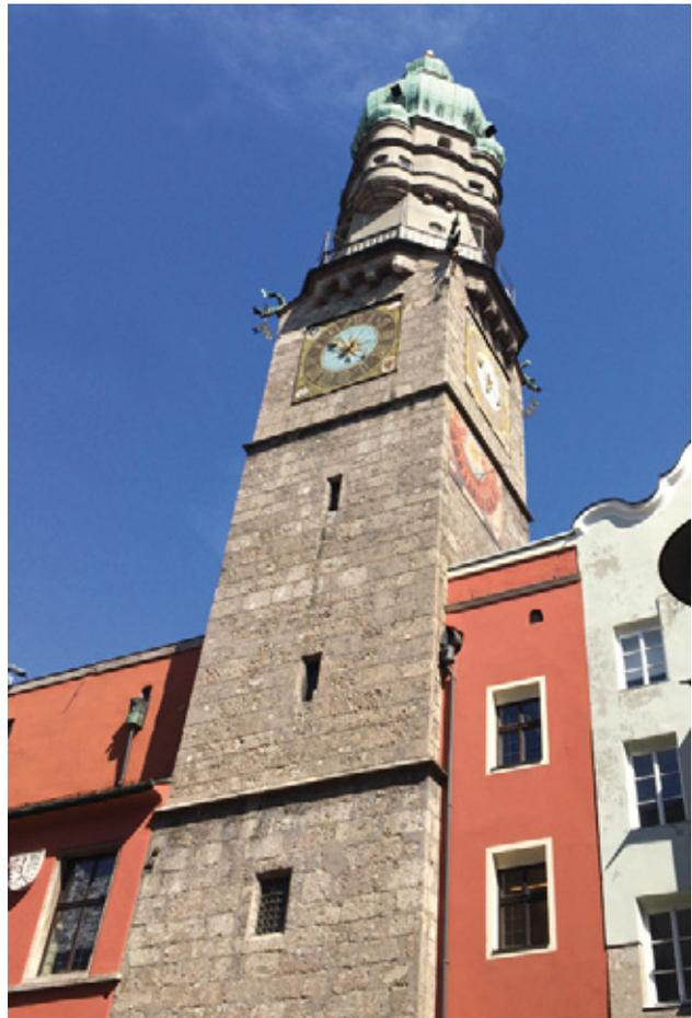
**Abb. 3:** Innsbruck, Stadtturm. Quadratischer, steinsichtiger Unterbau und über der Umgangebene folgender achteckiger Aufbau mit Zwiebelhaube und Laterne.
