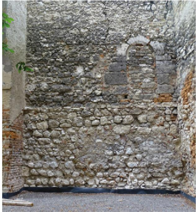
Abb. 23: Laa an der Thaya, Stadtbürg. Spätromanisches Mauerwerk des Nordostturmes.
