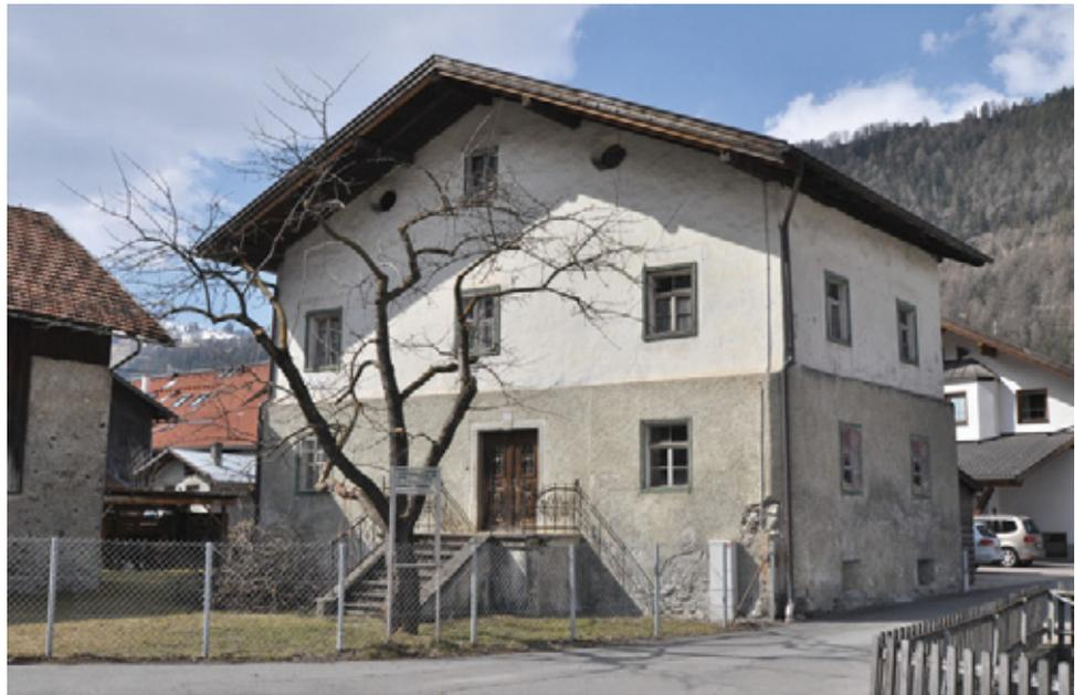
**Abb. 7:** Ried, ehemaliges Widum. In dem frühbarock überprägten Gebäude steckt ein gotischer Kernbau des 14. Jahrhunderts mit zwei spätgotischen Erweiterungsphasen (Ansicht gegen Südwesten).
