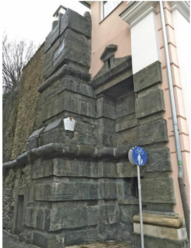
**Abb. 4:** Klagenfurt, Villacher-Bastei. Mauerzug Richtung Nordosten mit der in den 1980er-Jahren in die Stadtmauer gebrochenen Fußgängerpassage.
