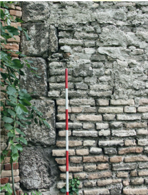
Abb. 17 Orth an der Donau, Schloss. Südostturm. Südostecke mit Ortsteinsetzung, um 1200 (Aufnahme 2004).
