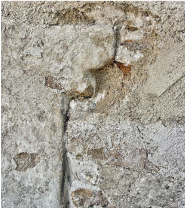
Abb. 54 Orth an der Donau, Schloss. Südwestturm, Westfassade. Nach Osten laufende Traufgesimskante des Westtrakts auf heutiger Traufhöhe, ab 1523 (Aufnahme 2004).
