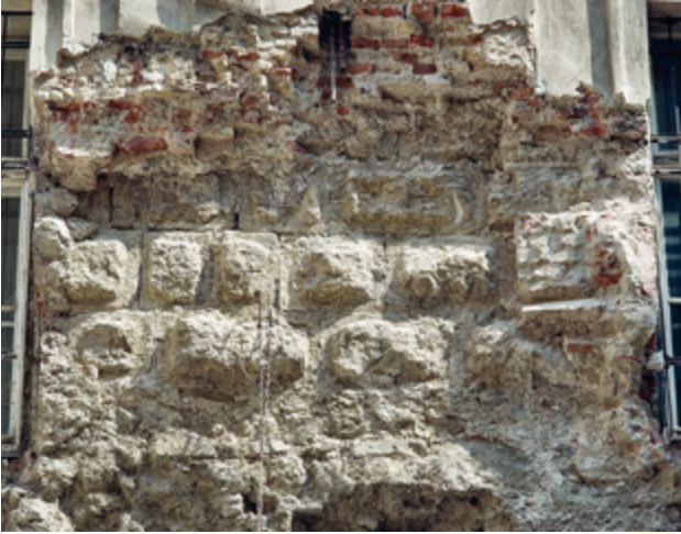
Abb. 220 Wien, Hofburg. Südwestfront der Alten Burg. Buckelquader, um 1240 (2005 während Umbauarbeiten kurzfristig freiliegend sichtbar).
