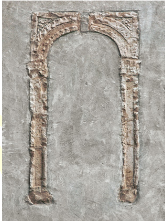
Abb. 80 Orth an der Donau, Schloss. Westtrakt, Westfassade. Vermauertes Rundbogenfenster aus Sandstein, ab 1531 (um 1550 an dieser Stelle spoliert eingesetzt).
