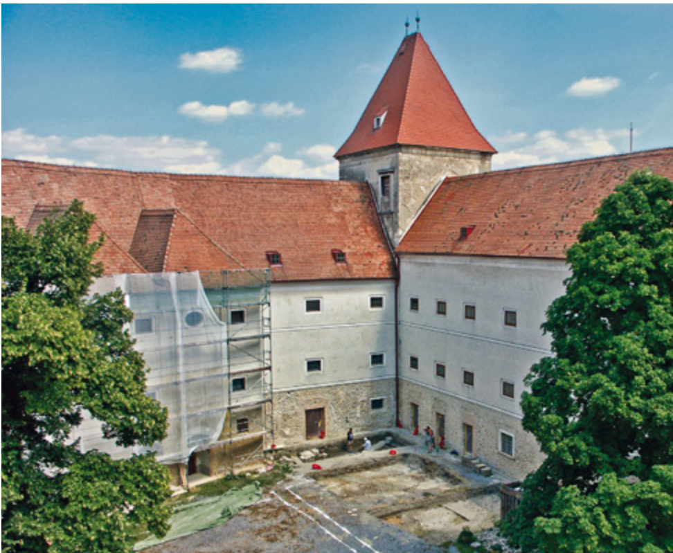
Abb. 5 Orth an der Donau, Schloss. Grabungsarbeiten im Innenhof (Juni 2004).
