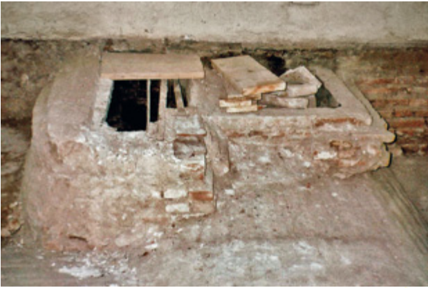
Abb. 188 Orth an der Donau, Schloss. Westtrakt. Freilegung des oberen Ausstiegs der Wendeltreppe in Raum 10G6 (Aufnahme 2004).
