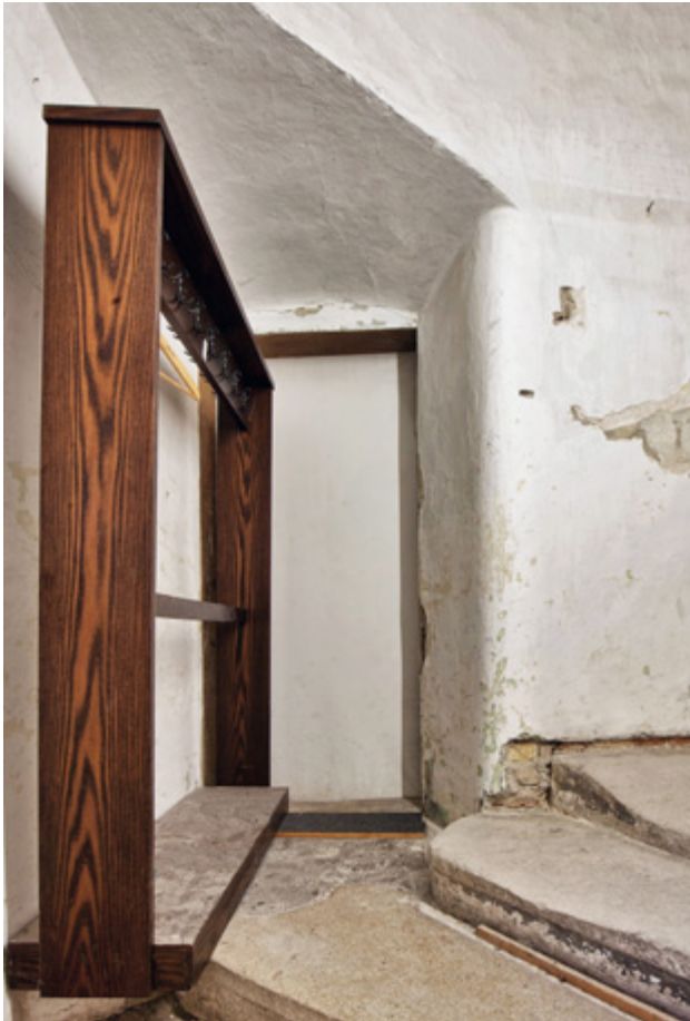
Abb. 173 Orth an der Donau, Schloss. Wendeltreppenturm. Sekundär errichtete Tür in das 1. Obergeschoß des Westtrakts.
