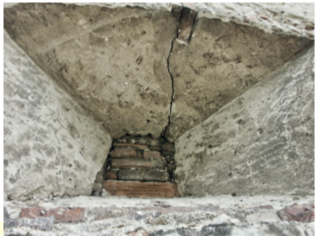
Abb. 130 Orth an der Donau, Schloss. Südwestturm, Südfassade. Maulscharte mit Prellholz im 3. Turmobergeschoß (Aufnahme 2004).
