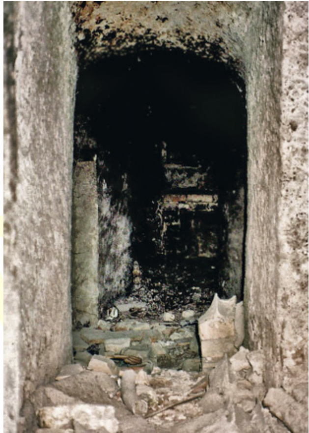
Abb. 189 Orth an der Donau, Schloss. Nordwestturm, Raum 10G10. Barocke Rauchküche mit neu durchbrochenem Fenster (Blick nach Westen).
