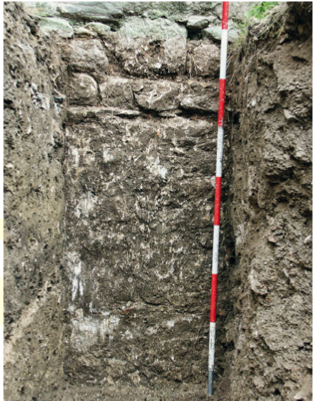
Abb. 18 Orth an der Donau, Schloss. Südostturm. Bruchsteinmauerwerk in Einzellagen an der Westseite, um 1200 (Aufnahme 2004).
