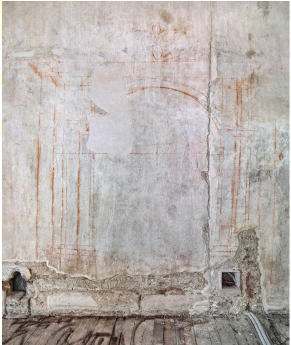
Abb. 168 Orth an der Donau, Schloss. Westtrakt, 2. Obergeschoß. Architekturzeichnung von Georg Haas (?) an der Nordwand der Empore, um 1577.
