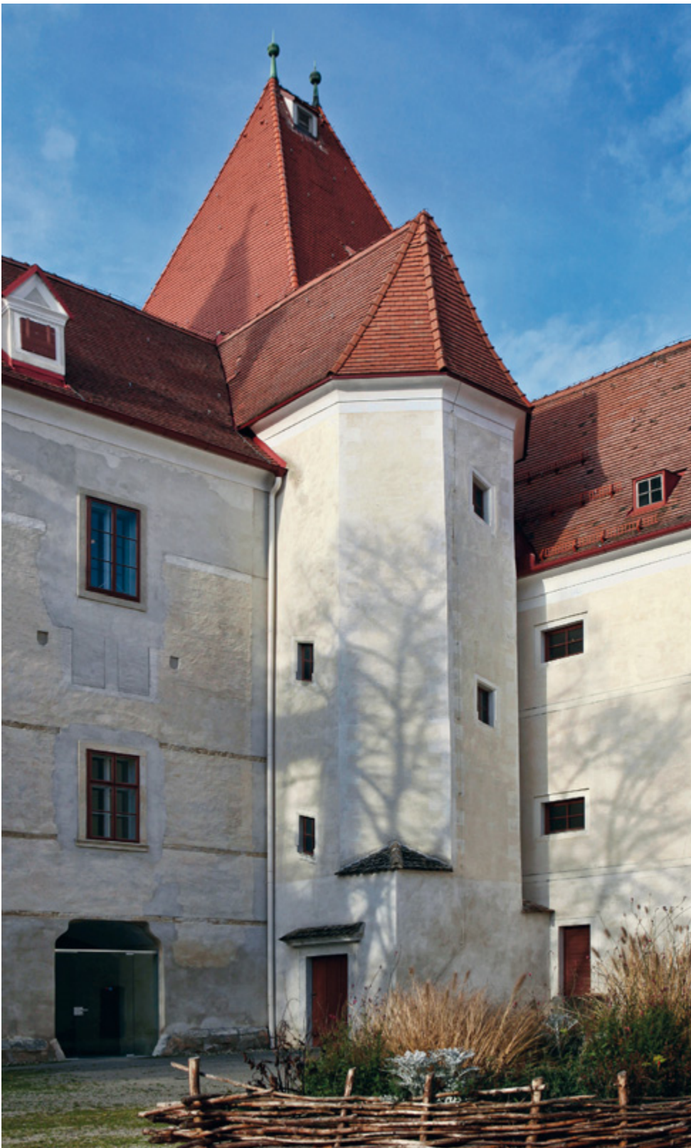
Abb. 48 Orth an der Donau, Schloss. Nordwestecke des Innenhofs mit Nordtrakt (rechts) und ursprünglich gleich hohem Westtrakt (links) sowie Wendeltreppenturm, ab 1523 (Aufnahme 2011).
