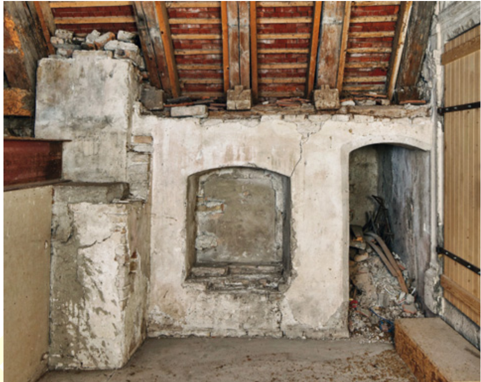
Abb. 170 Orth an der Donau, Schloss. Westtrakt, Empore. Westseite mit Zugang zum Aborterker, vermauertem Fenster und Kamin (von rechts nach links).
