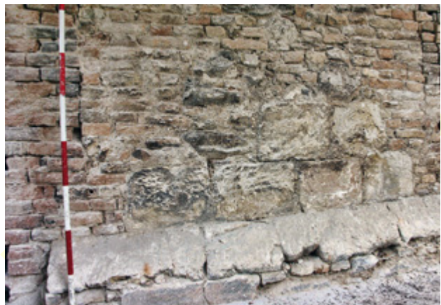
Abb. 45 Orth an der Donau, Schloss. Westtrakt. Sockel an der Ostfassade, ab 1523 (Aufnahme 2004).
