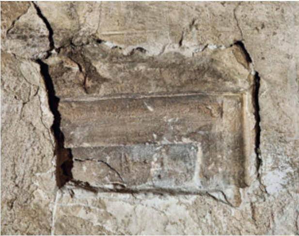
Abb. 60 Orth an der Donau, Schloss. Südostturm, ehemalige Nordfassade (heute am Dachboden des Osttrakts einsehbar). Detail eines gekehlten Fensterrahmens, ab 1523.
