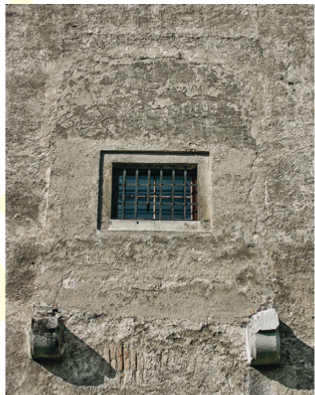
Abb. 37 Orth an der Donau, Schloss. Nordtrakt. Konsolen des östlichen Erkers an der Nordfassade, vermutlich um 1444 (Aufnahme 2004).
