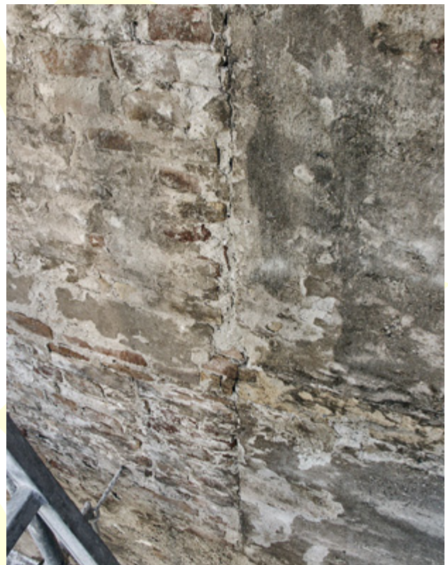
Abb. 125 Orth an der Donau, Schloss. Baunaht zwischen Südwestturm (links) und Westtrakt (rechts) mit primär endendem, sekundär abgeschlagenem Steingesims (Aufnahme 2004).
