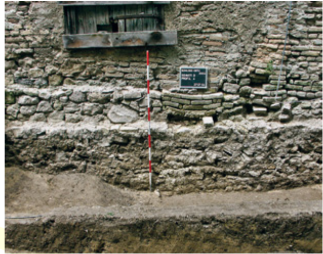
Abb. 24 Orth an der Donau, Schloss. Osttrakt. Niedriges Kompartimentmauerwerk über dem Fundamentvorsprung, spätes 13. Jahrhundert (Aufnahme 2004).
