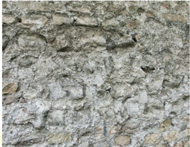
Abb. 31 Orth an der Donau, Schloss. Westtrakt. Bruchsteinmauerwerk einer ehemaligen Ringmauer an der Westfassade, vermutlich um 1334 (Aufnahme 2004).
