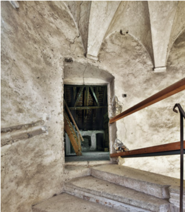
Abb. 143 Orth an der Donau, Schloss. Wendeltreppenturm. Zugang zur ehemaligen Empore mit darüber befindlichem Gewölbefuß.
