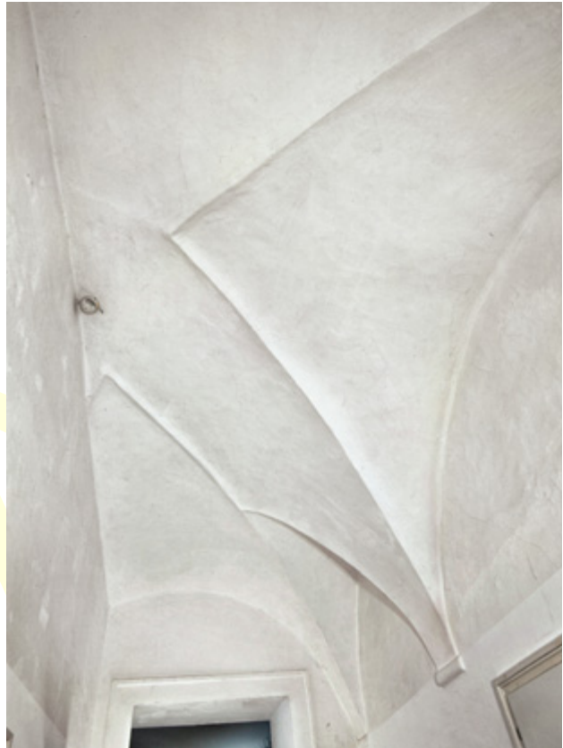
Abb. 121 Orth an der Donau, Schloss. Westtrakt, Raum 10G7. Nördlicher Abschluss der Stichkappentonne von 10G6 mit Mulde und Stichkappenkranz, ab 1550.
