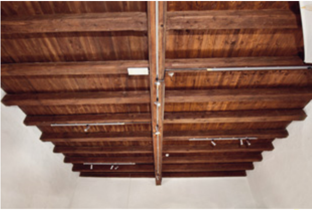
Abb. 198 Orth an der Donau, Schloss. Osttrakt. Balkendecke in Raum 2OG14, 1830.
