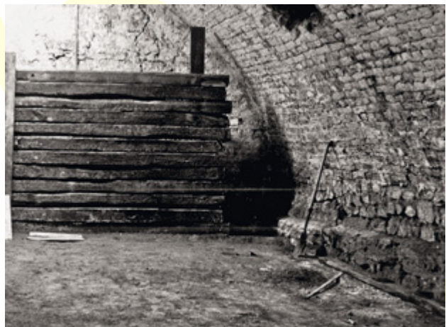
Abb. 35 Orth an der Donau, Schloss. Nordtrakt. Nordmauer des Raums EG15 (im Bild rechts), vermutlich um 1444 (Aufnahme 1991).
