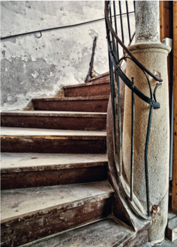
Abb. 196 Orth an der Donau, Schloss. Wendeltreppenturm. Holzbretter auf den Stufen und Schmiedeeisengeländer der Wendeltreppe, spätes 18. Jahrhundert.
