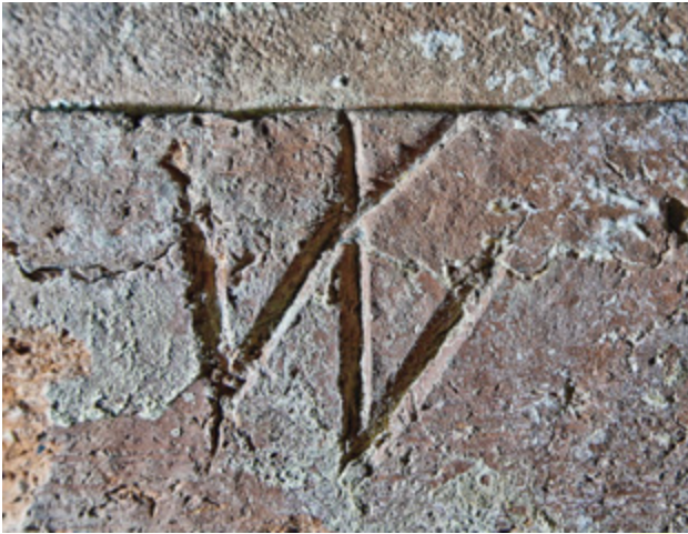
Abb. 113 Neuburg am Inn, Schloss. Gewölberippe mit Buchstaben »W«.
