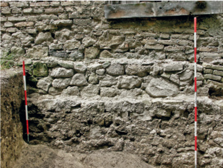
Abb. 255 Orth an der Donau, Schloss. Schnitt 3. Aufgehendes und Fundament der Ostmauer der Burg, spätes 13. Jahrhundert (mit jüngeren Ergänzungen und Flickungen aus Ziegeln).
