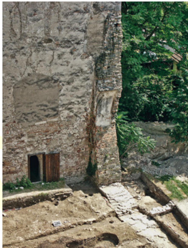
Abb. 281 Orth an der Donau, Schloss. Schnitt 1, SE 127. Neu geschaffener Strebpfeiler mit ehemaliger Laibung einer Nische. Darüber ehemalige Tür zum Wehgang auf die Ringmauer (?).
