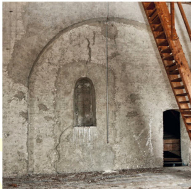
Abb. 76 Orth an der Donau, Schloss. Südostturm. Verfülltes Rundbogenfenster im 3. Obergeschoß, das ehemals dem älteren Dach des Osttrakts auswich.
