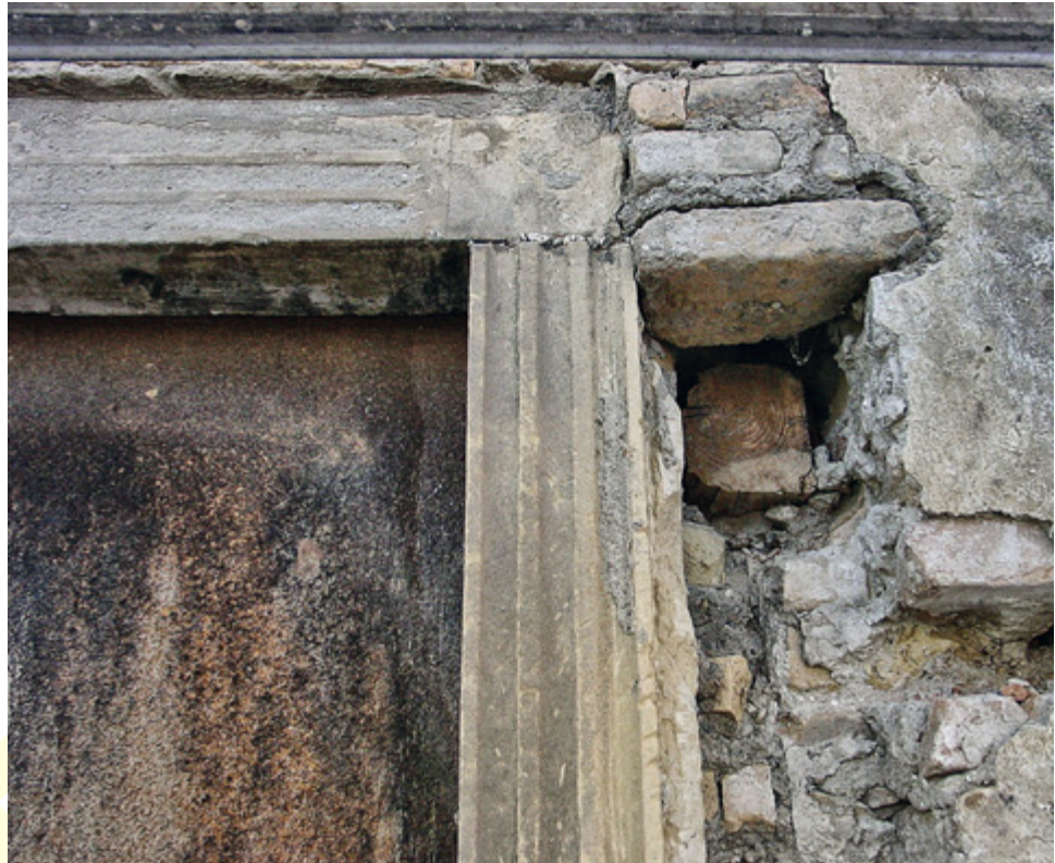
Abb. 194 Orth an der Donau, Schloss. Nordwestturm, Nordseite. Fenster des späten 18. Jahrhunderts im 3. Turmobergeschoß mit spolierten Fensterrahmen.
