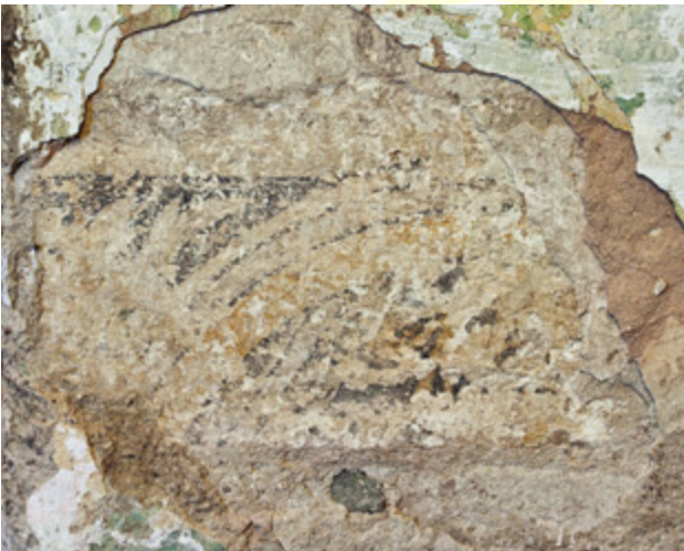
Abb. 57 Orth an der Donau, Schloss. Wendeltreppenturm. Südmauer mit gemaltem Bogenprofil in grauem Verputzband, ab 1523.
