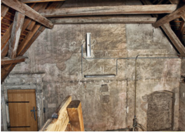
Abb. 153 Orth an der Donau, Schloss. Empore (DG1). Nordmauer mit Verputzkante des ehemaligen oberen Raumabschlusses.
