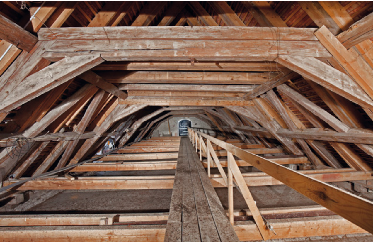
Abb. 178 Orth an der Donau, Schloss. Westtrakt. Dachstuhl, ab 1662.
