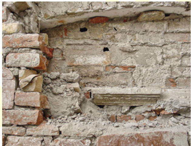
Abb. 81 Orth an der Donau, Schloss. Westtrakt, Ostfassade. Fensterverfüllung des späten 18. Jahrhunderts mit sekundär vermauertem Terrakottafragment des 16. Jahrhunderts (Aufnahme 2004).
