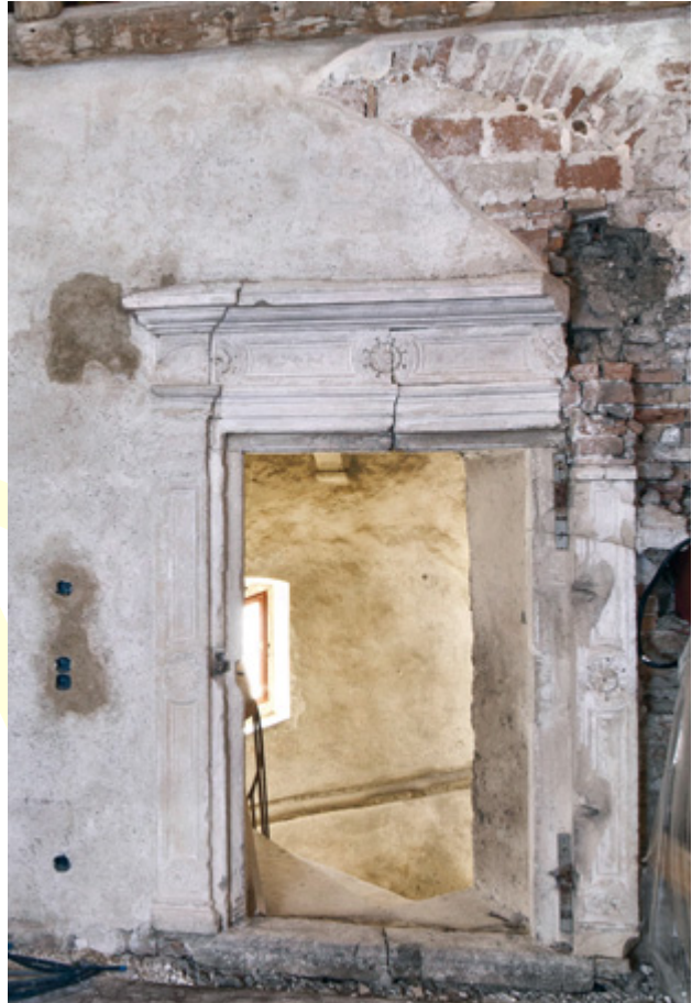
Abb. 134 Orth an der Donau, Schloss. Westtrakt, Raum DG1. Portal zum Wendeltreppenturm an der Ostmauer, um 1550. Der Entlastungsbogen darüber gehört zu einem unwesentlich älteren Portal, das weiter nach Süden (im Bild rechts) geweitet war.
