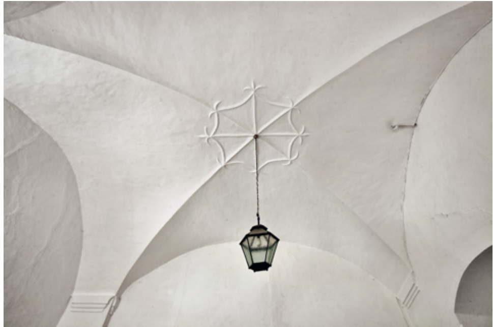
Abb. 180 Orth an der Donau, Schloss. Südostturm. Vermutlich nicht authentisch erhaltenes Gewölbe in Raum 20G15.
