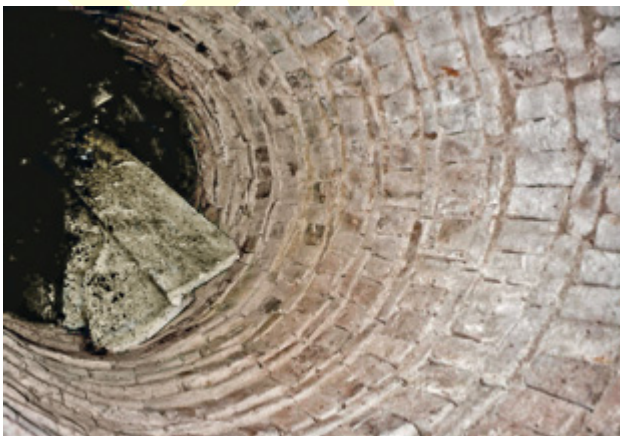
Abb. 123 Orth an der Donau, Schloss. Osttrakt. Blick in den Brunnen in Raum EG26 (Aufnahme 2004).
