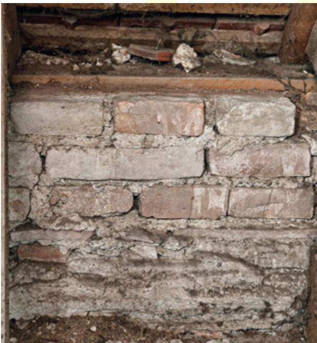
Abb. 44 Orth an der Donau, Schloss. Nordtrakt, Dachgeschoß. Unter drei Ziegellagen ist das zerstörte Gesims eines ehemaligen Raums im 2. Obergeschoß zu erkennen; bei dem im Bild rechts unten gerade noch erkennbaren Balken handelt es sich um den Bundtram von 1534.
