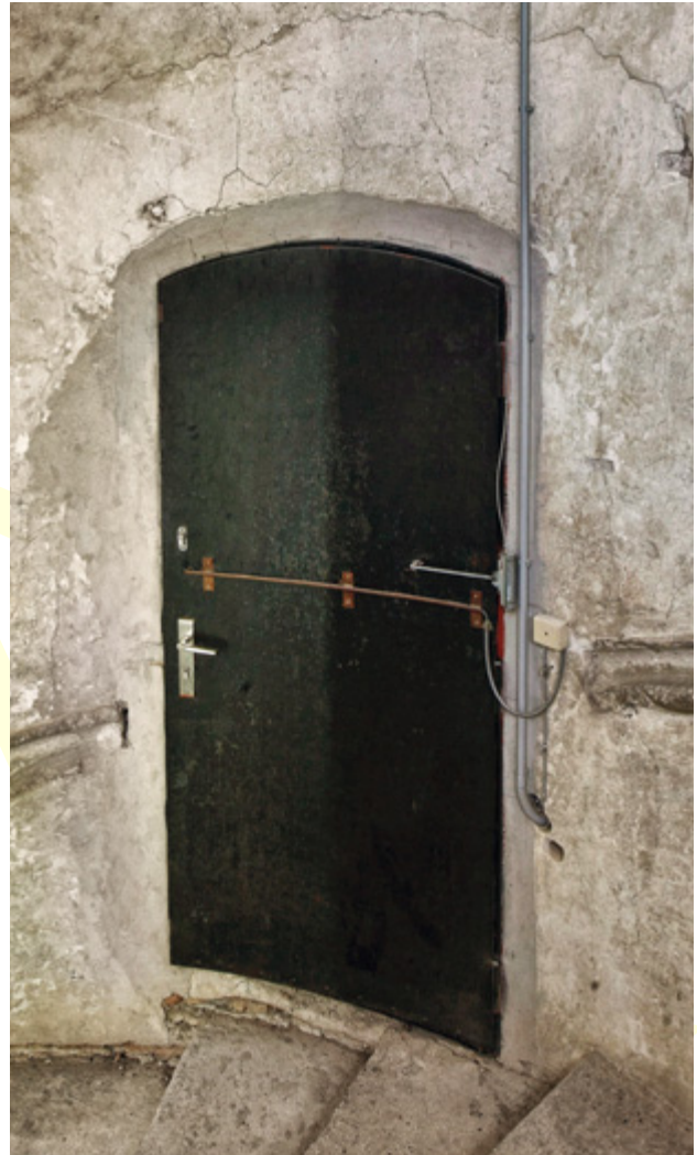
Abb. 174 Orth an der Donau, Schloss. Wendeltreppenturm. Sekundär errichtete Tür in das 2. Obergeschoß des Westtrakts.
