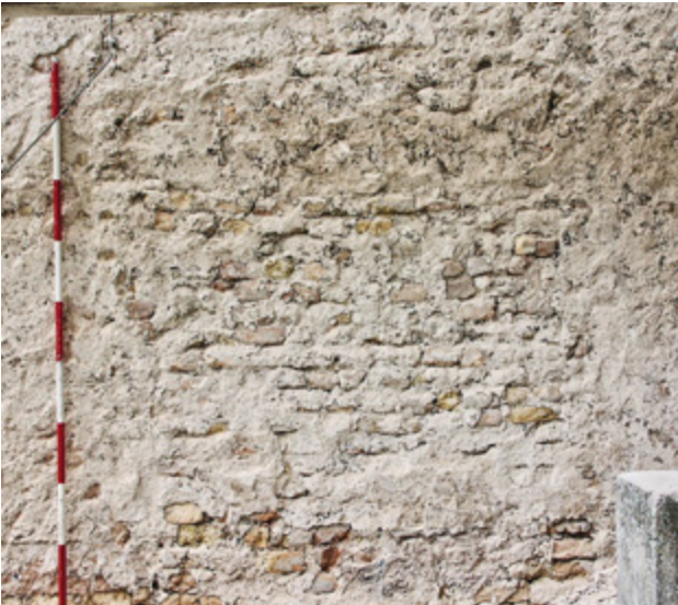
Abb. 56 Orth an der Donau, Schloss. Wendeltreppenturm. Ostfassade mit primärer, später verfüllter Türöffnung, ab 1523 (Aufnahme 2004).
