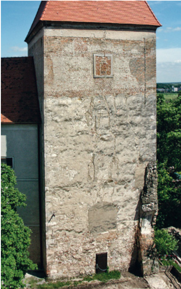
Abb. 23 Orth an der Donau, Schloss. Südostturm. Westfassade mit Ortsteinsetzungen (Aufnahme 2004).
