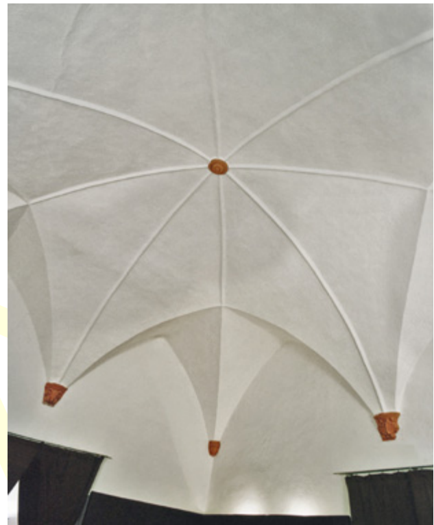
Abb. 102 Orth an der Donau, Schloss. Nordostturm. Sternratgewölbe in Raum 10G20, vor 1540.
