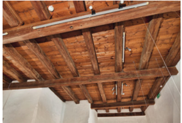
Abb. 124 Orth an der Donau, Schloss. Osttrakt. Balkendecke in Raum 2OG12, 1560.
