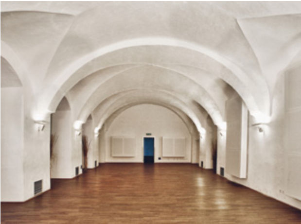
Abb. 120 Orth an der Donau, Schloss. Westtrakt. Blick nach Süden in den Raum 10G6. Zwischen dem südlichen Teil mit Kreuzgratgewölbe und dem nördlichen mit Stichkappentonne bestand ehemals eine Binnenmauer, ab 1550.
