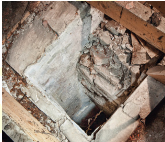
Abb. 195 Orth an der Donau, Schloss. Nordtrakt, Nordseite. Verputzte Lüftungsöffnung.
