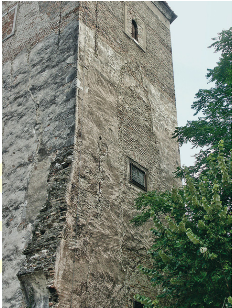
Abb. 59 Orth an der Donau, Schloss. Südostturm, Südfassade. Ziegelvorblendung mit ehemaligen Rechtecköffnungen und großem Ziegelbogen im 2. Obergeschoß (für einen ehemaligen Erker?), ab 1523 (Aufnahme 2004).
