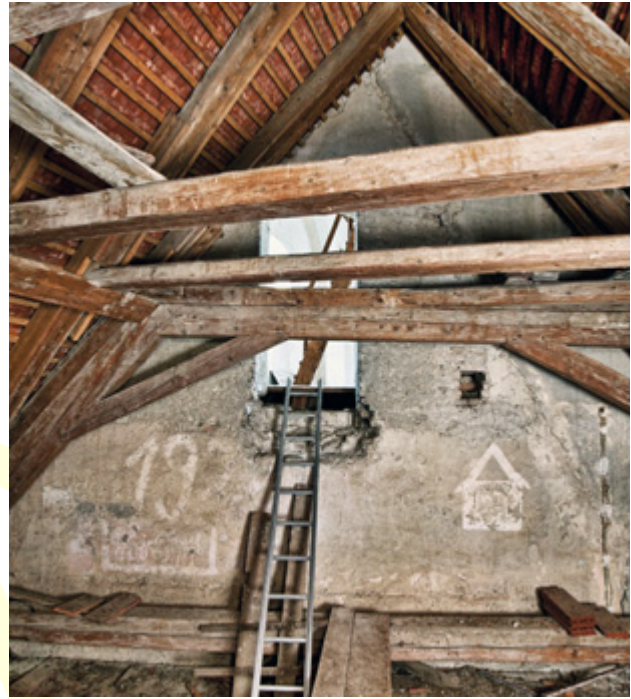
Abb. 69 Orth an der Donau, Schloss. Südostturm, Nordfassade. Abdruck eines niedrigeren Satteldachs des Osttrakts, 1530er-Jahre (Ansicht vom Dachboden des Osttrakts).
