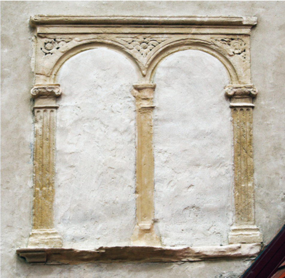
Abb. 73 Orth an der Donau, Schloss. Nordwestturm, Südfassade. Sandsteinbiforium, ab 1531 (Aufnahme 2011).
