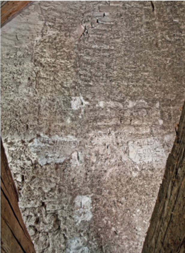
Abb. 78 Orth an der Donau, Schloss. Wendeltreppenturm. Links die Nordfassade mit verputzter Nordwestkante, rechts die angestellte Mauer des Westtrakts.
