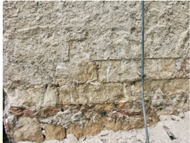
Abb. 55 Orth an der Donau, Schloss. Wendeltreppenturm. Ostfassade mit ehemals vorkragendem, abgeschlagenem Sockel aus Quadermauerwerk mit Ziegeldurchschuss, ab 1523 (Aufnahme 2004).
