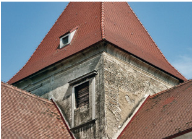
Abb. 75 Orth an der Donau, Schloss. Nordostturm. Das Fenster an der Westfassade (1530er-Jahre) weicht dem Dach des Nordtrakts aus (Aufnahme 2004).
