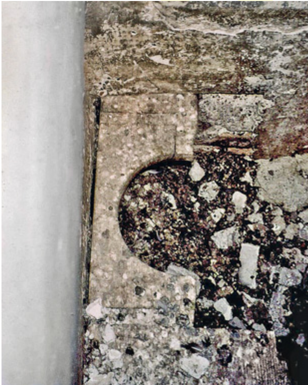
Abb. 128 Orth an der Donau, Schloss. Südwestturm. Abort mit Sitzbrett im 2. Turmobergeschoß (Aufnahme 2004).
