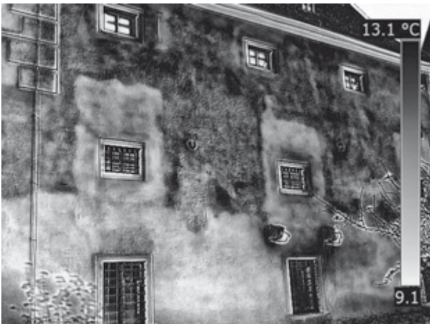
Abb. 38 Orth an der Donau, Schloss. Nordtrakt. Der östliche vermauerte Erker an der Nordfassade, vermutlich um 1444 (thermografische Aufnahme 2017).
