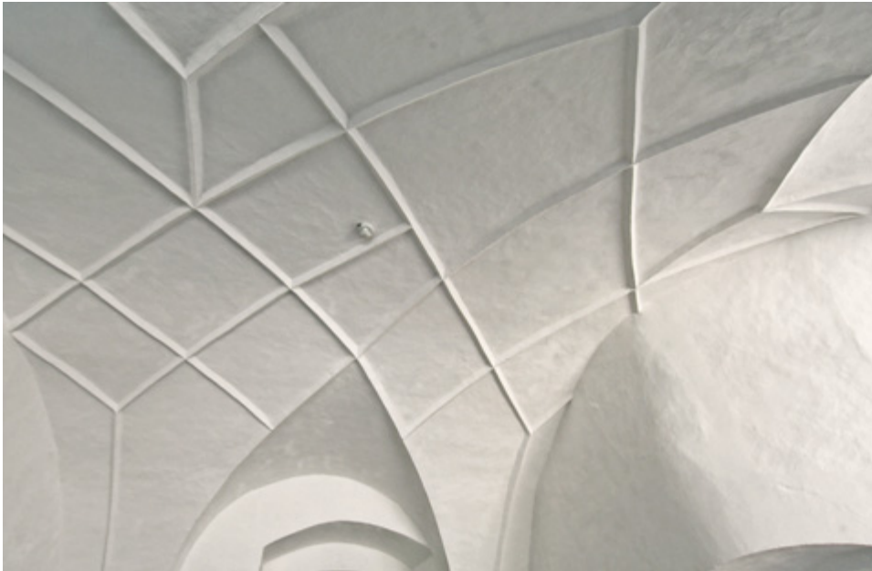
Abb. 127 Orth an der Donau, Schloss. Südwestturm. Netzgratgewölbe in Raum 1OG1, ab 1550.
