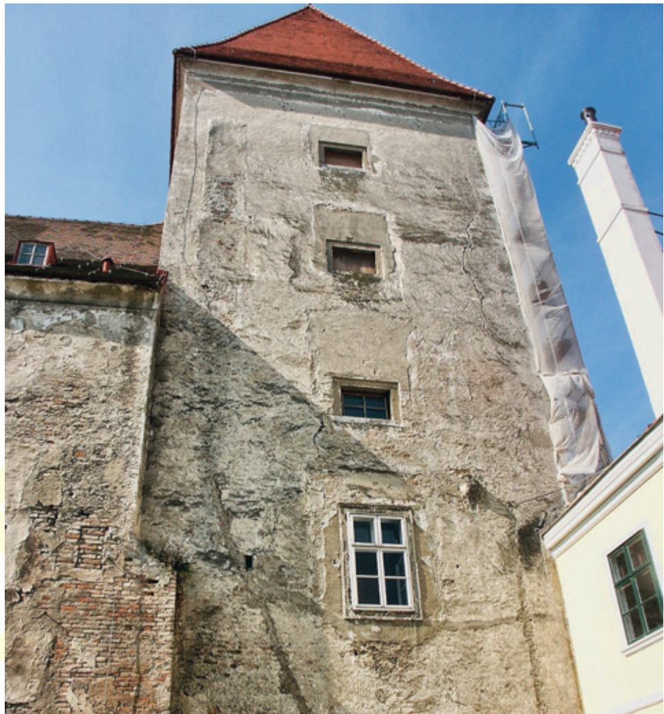
Abb. 72 Orth an der Donau, Schloss. Nordwestturm. Nordfassade mit verkleinerten Fenstern des späten 18. Jahrhunderts und der Fehlstelle eines ehemals zweigeschoßigen Aborterkers links von den Fenstern der beiden obersten Geschoße (Aufnahme 2004).
