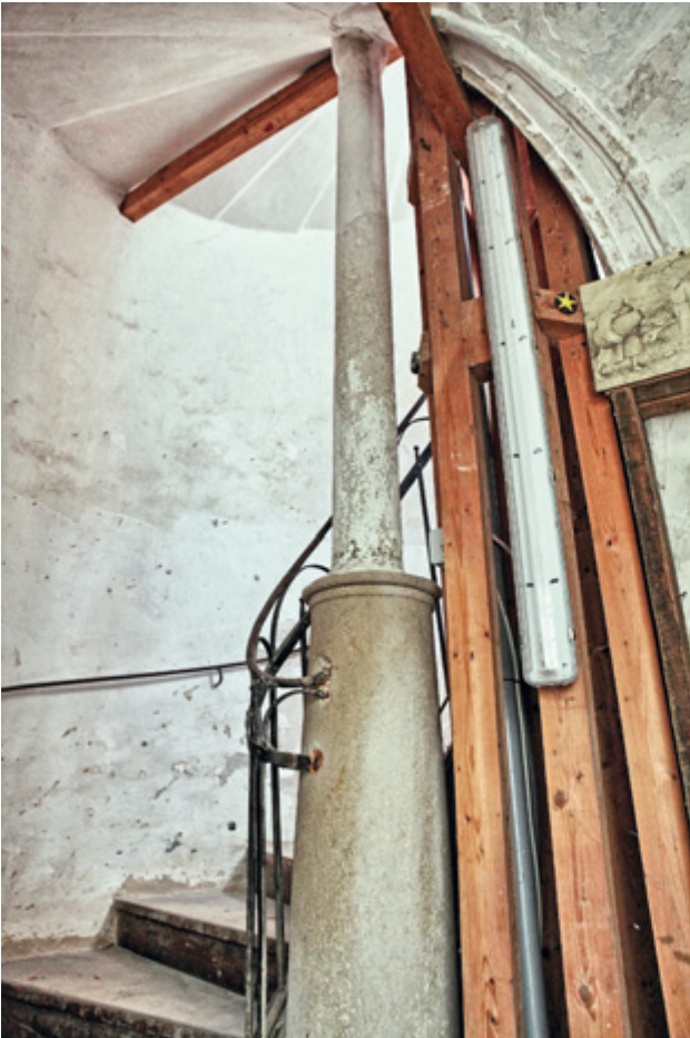
Abb. 136 Orth an der Donau, Schloss. Hohlspindeltreppe mit einer Wangensäule, kurz nach 1548. Verschiedene Ansichten.
