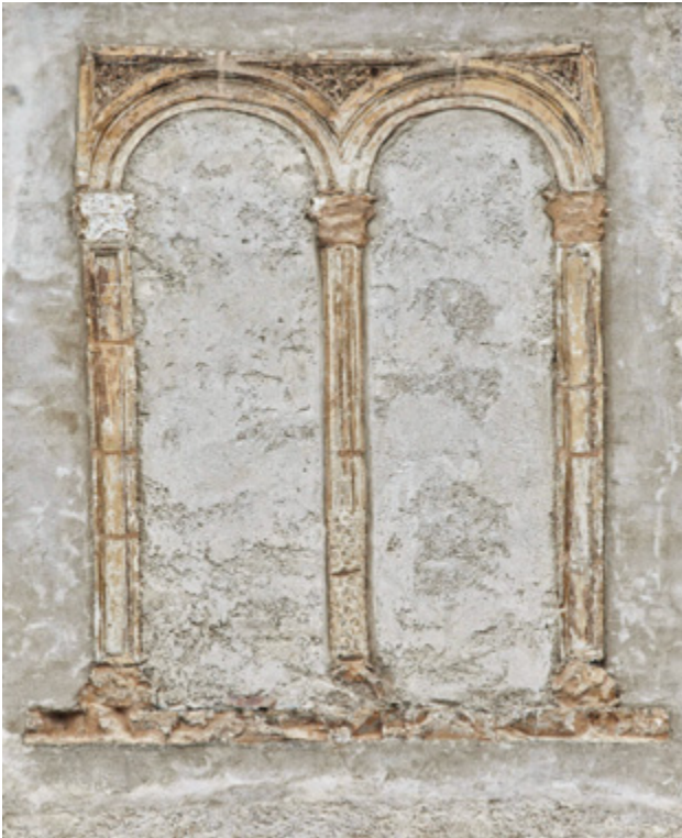
Abb. 66 Orth an der Donau, Schloss. Nordtrakt, Nordfassade. Sandsteinbiforium im 2. Obergeschoß, ab 1531.
