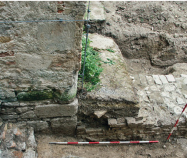
Abb. 16 Orth an der Donau, Schloss. Südostturm. Nordwestecke mit Ortsteinsetzung, um 1200 (Aufnahme 2004).
