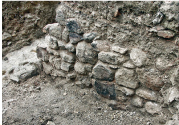
Abb. 258 Orth an der Donau, Schloss. Kanal 1/9/11, SE 550. Mauerwerk eines spätmittelalterlichen Steingebäudes mit Spuren eines Brands.
