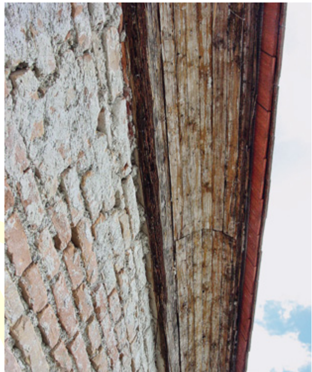
Abb. 183 Orth an der Donau, Schloss. Südostturm. Remonadengesims an der Ostseite, 1679.
