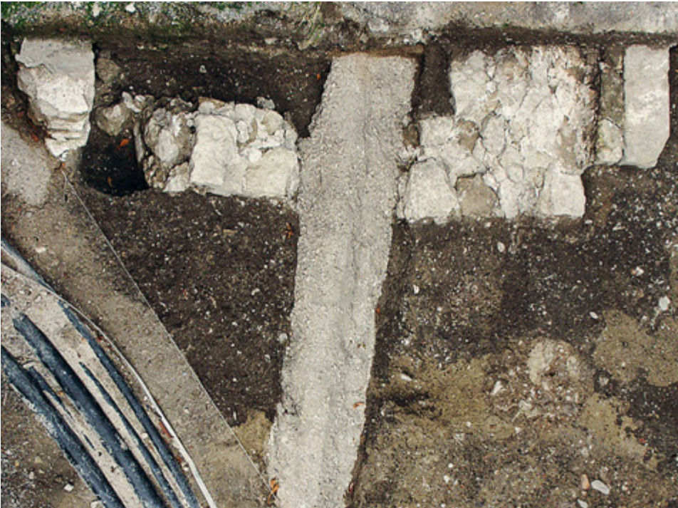
Abb. 266 Orth an der Donau, Schloss. Schnitt 4, Obj. 1/2. Mögliche Basis einer Freitreppe aus Phase 4 mit in Phase 5 angebaute Stufe (rechts). In der Mitte schneidet eine jüngere Leitung das Fundament.
