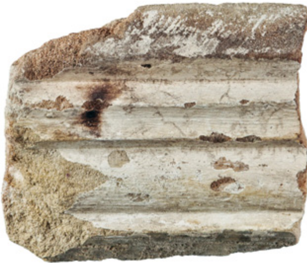
Abb. 176 Orth an der Donau, Schloss. Teil eines Sohlbankgesimses aus Kalksandstein mit Brandspuren.
