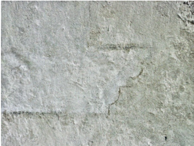
Abb. 49 Orth an der Donau, Schloss. Westtrakt. Profil einer Sohlbank an der Ostfassade als Steinimitat in Form einer Nagelrisszeichnung im Putz, ab 1525.
