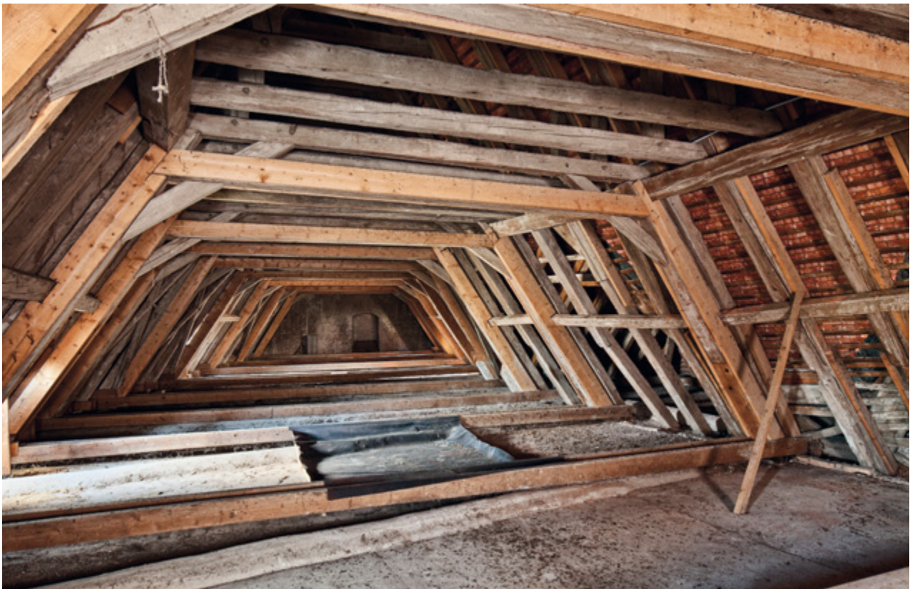
Abb. 64 Orth an der Donau, Schloss. Nordtrakt. Sparrendach, nach 1533.
