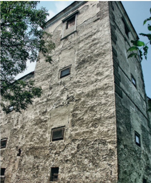
Abb. 74 Orth an der Donau, Schloss. Nordostturm. An der Nord- und der Ostfassade sind die vermauerten großen Rechtecköffnungen zu erkennen (Aufnahme 2004).
