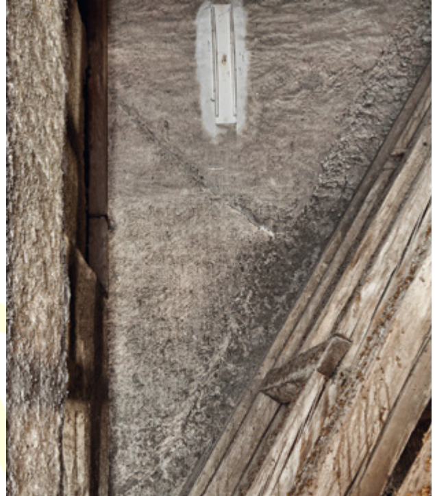
Abb. 154 Orth an der Donau, Schloss. Nordwestturm, Ostfassade am Dachboden des Nordtrakts. Die rechte Putzkante bezieht sich auf den Dachstuhl des Nordtrakts (ab 1533), die linke, stratigrafisch jüngere Putzkante auf die Abwalmung des ehemaligen Satteldachs des Osttrakts, um 1550.
