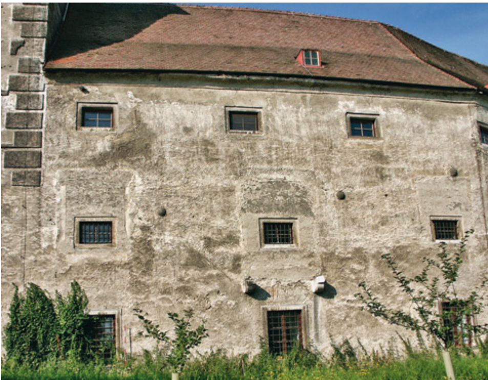
Abb. 43 Orth an der Donau, Schloss. Nordtrakt. Die drei Kanonenkugeln stecken primär in der Ziegelvorblendung der Nordfassade, vermutlich ab 1523 (Aufnahme 2004).
