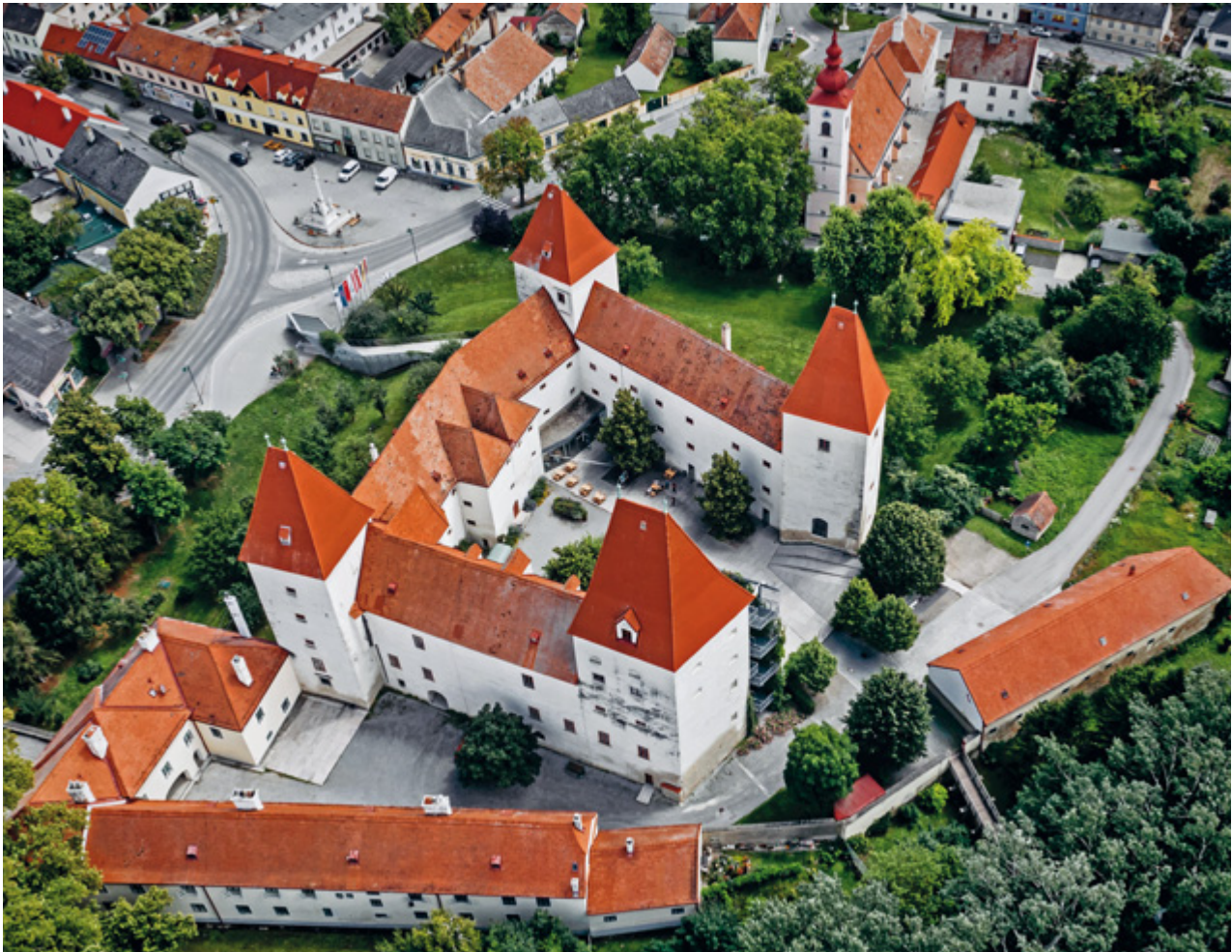
Abb. 1 Orth an der Donau, Schloss. Ansicht des Gesamtkomplexes von Südwesten (Aufnahme 2020). Am oberen Bildrand ist rechts die Pfarrkirche zu sehen.
