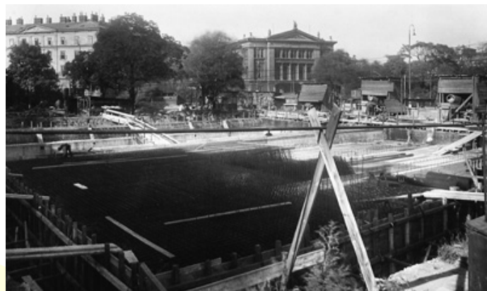
Abb. 103: Baustelle Ostbahnhof-Bunker: 22. 9. 1942. Hintergrund: Südbahnhof (Mitte) und Direktionsgebäude (links).
