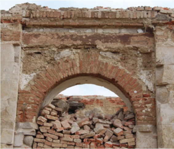
Abb. 86: Vestibül, Südmauer, Detail eines Bogens.
