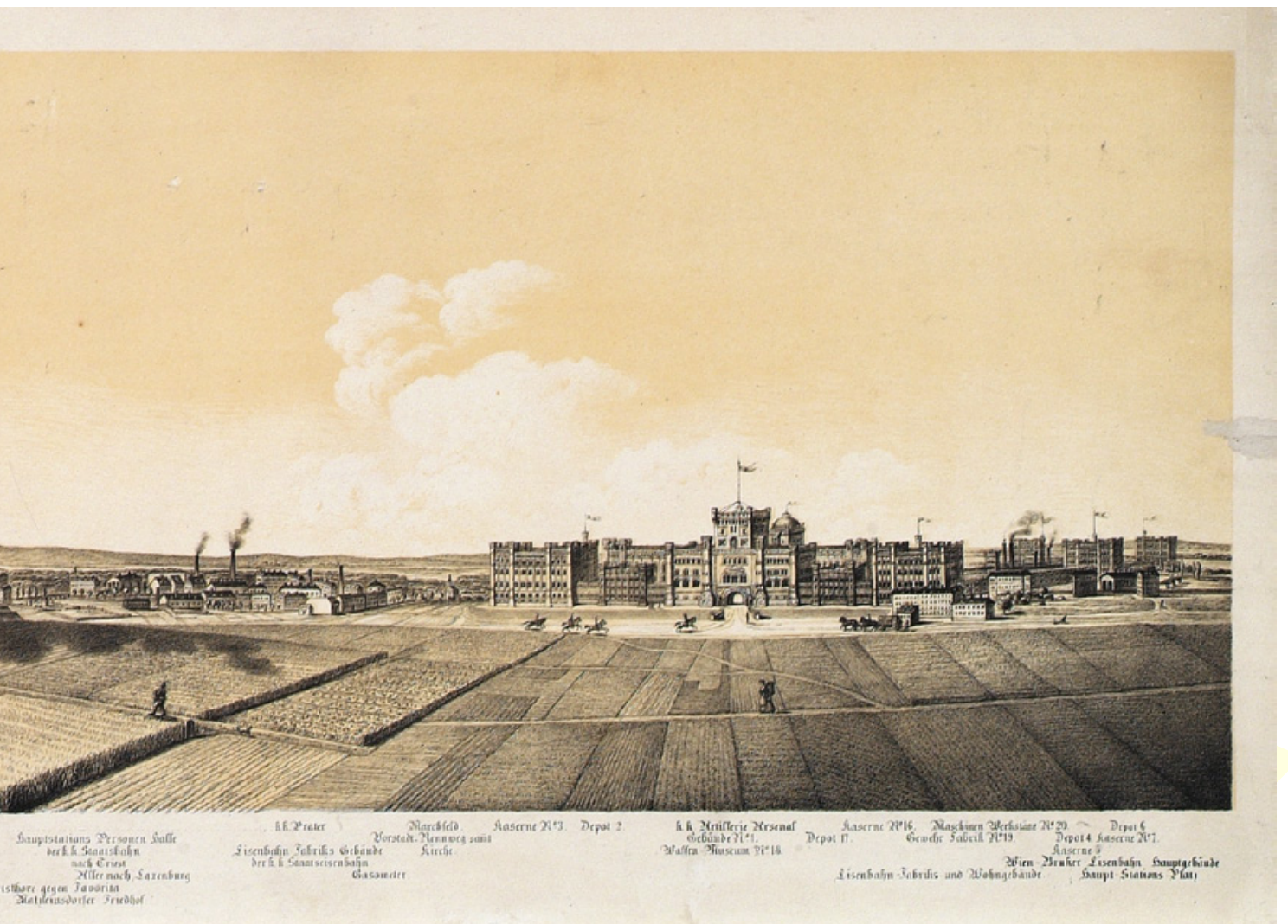
Zwischen der Denksäule und der kleinen „Siedlung vor der Favoriten-Linie“ ist der Viadukt der Gloggnitzer oder Südbahn bei der Matzleinsdorfer Linie zu sehen.
