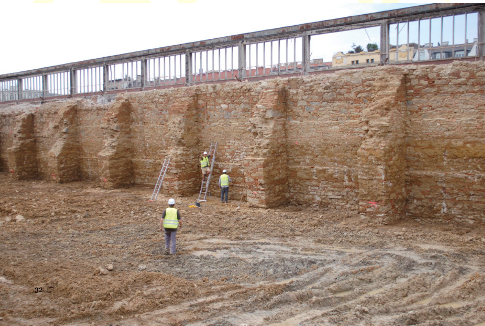
Abb. 37: Substruktion für die Gleiskörper des Südbahnhofes I.
