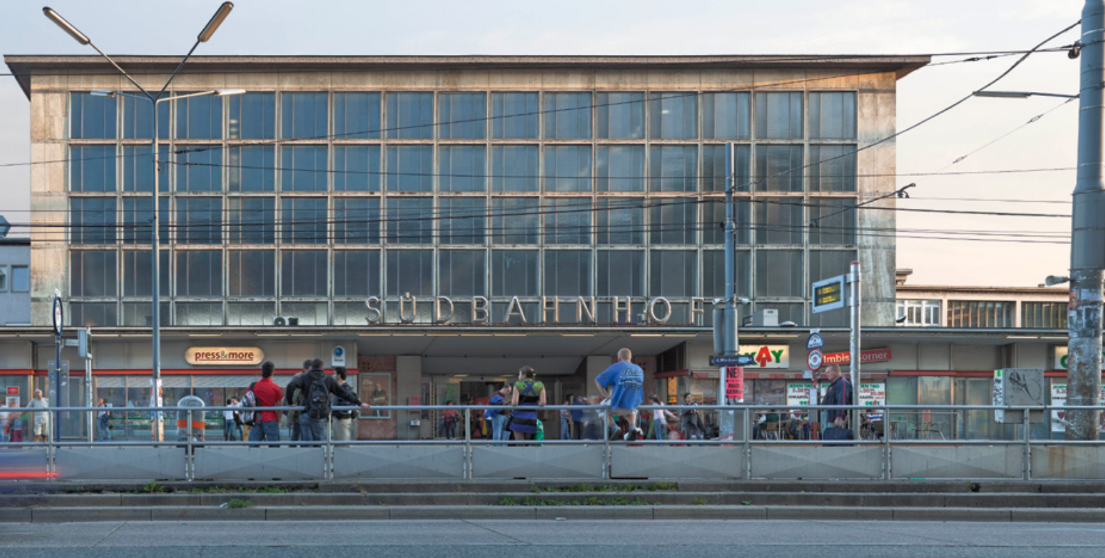
Abb. 18: Südbahnhof, Aufnahmegebäude, Nordfassade Bestand, am 07. Oktober 2009.
