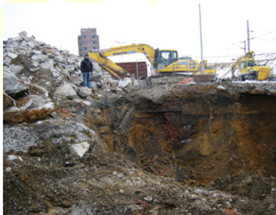
Abb. 129: Abbruchgrube. Auch dieser Bunker wurde komplett entfernt.
