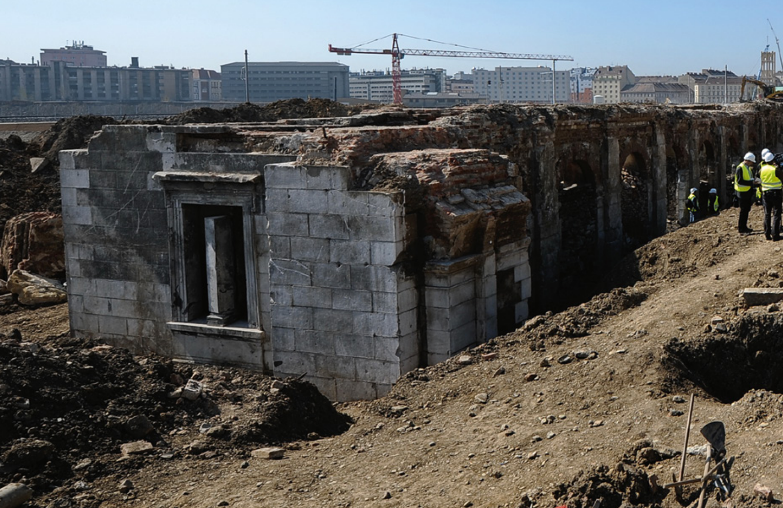
Abb. 22: Kassenhalle Südbahnhof II zu Beginn der Freilegungsarbeiten, am 7. April 2010.
