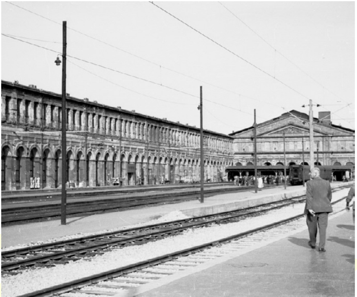
Abb. 77: Blick auf die Rückfront des Vestibüls, am 29. September 1959.
