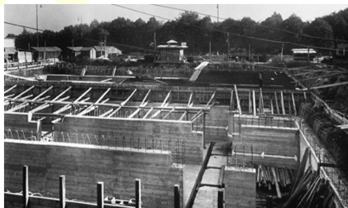
Abb. 104: Baustelle Ostbahnhof-Bunker: 22. 9. 1942. Hintergrund: Schweizergarten.
