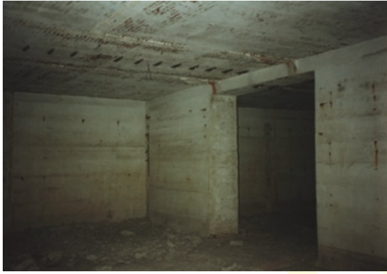
Abb. 111: Im Inneren des Südbahnhof-Bunkers. Die Innenwände, welche den Bunker in kleine Kammern aufteilen, fehlen bereits (1996). An der Decke dichte Stahlarmierungsmatten.
