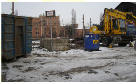
Abb. 126: Abgangsbauwerk zum ehemaligen Bunker für das Bahnpersonal (Mitte). Hintergrund: Arsenal und Lokschuppen (rechts).
