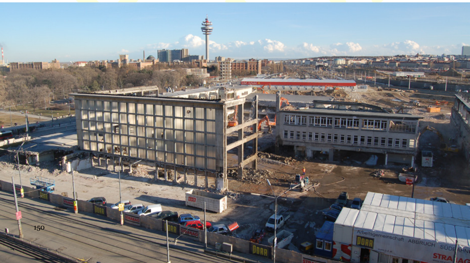
Abb. 204: Abbruch des dritten Wiener Südbahnhofes, am 1. März 2010.
