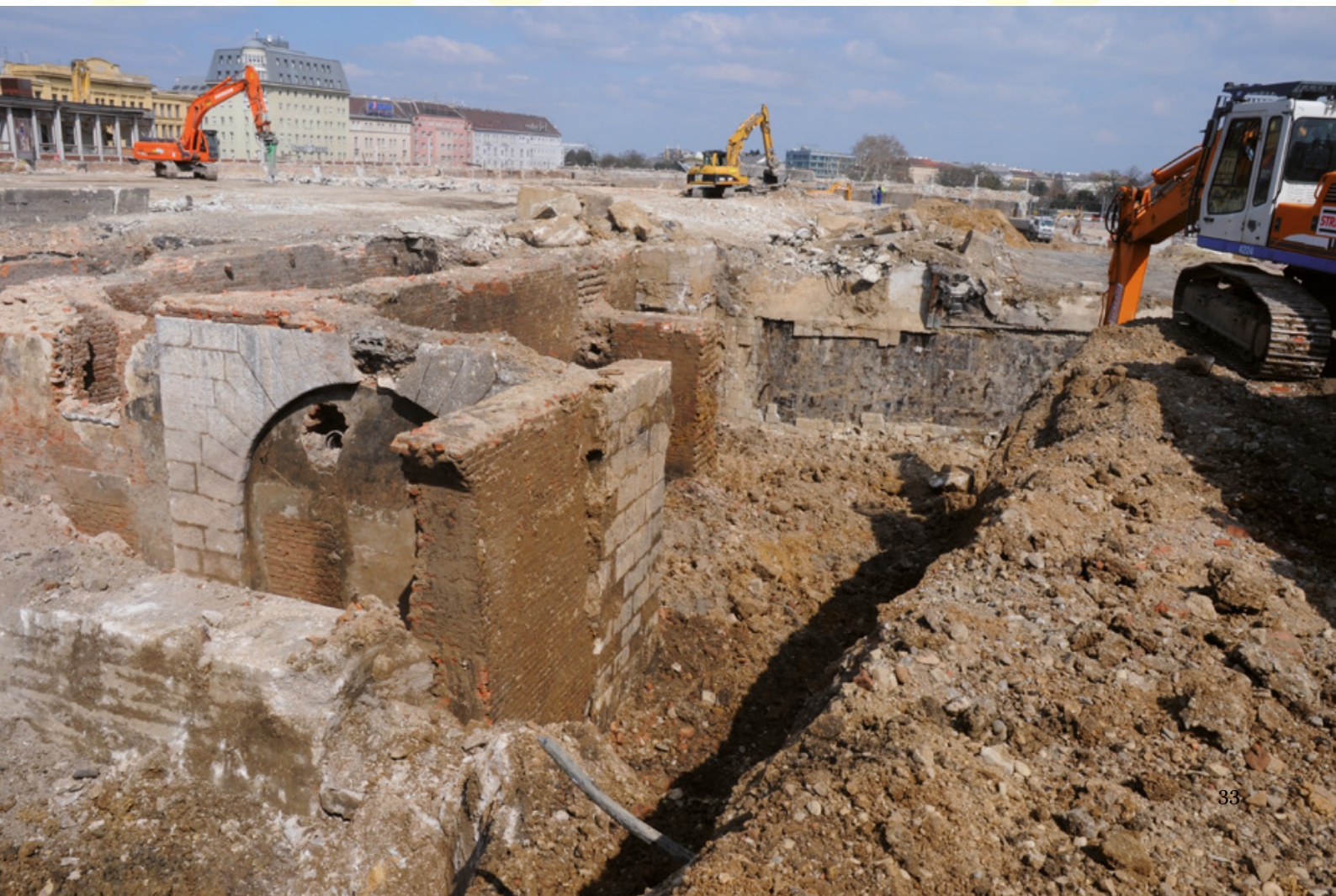
Abb. 39: Südwestbereich Südbahnhof II bei der Freilegung.
