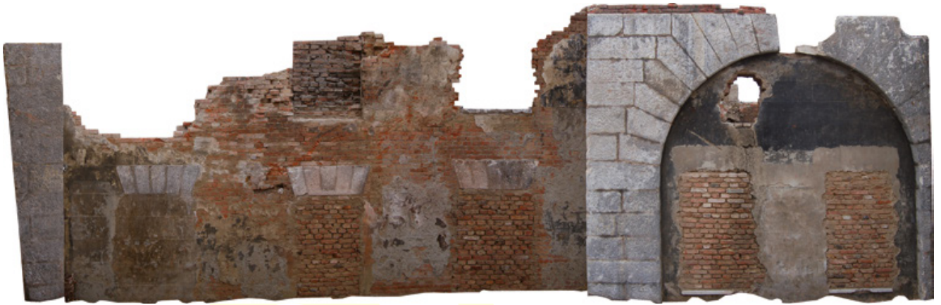
Abb. 38: Abwicklung der Ziegelmauer mit einem Portal im Südwesten von Südbahnhof II, Photogrammetrie.
