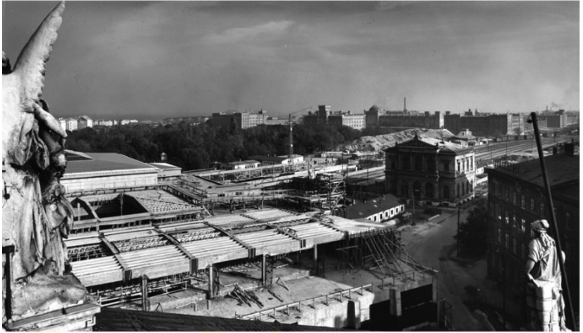
Abb. 7: Blick von Südbahnhof II auf die neue Kassenhalle und die Ruine des Ostbahnhofes, am 1. November 1955.
