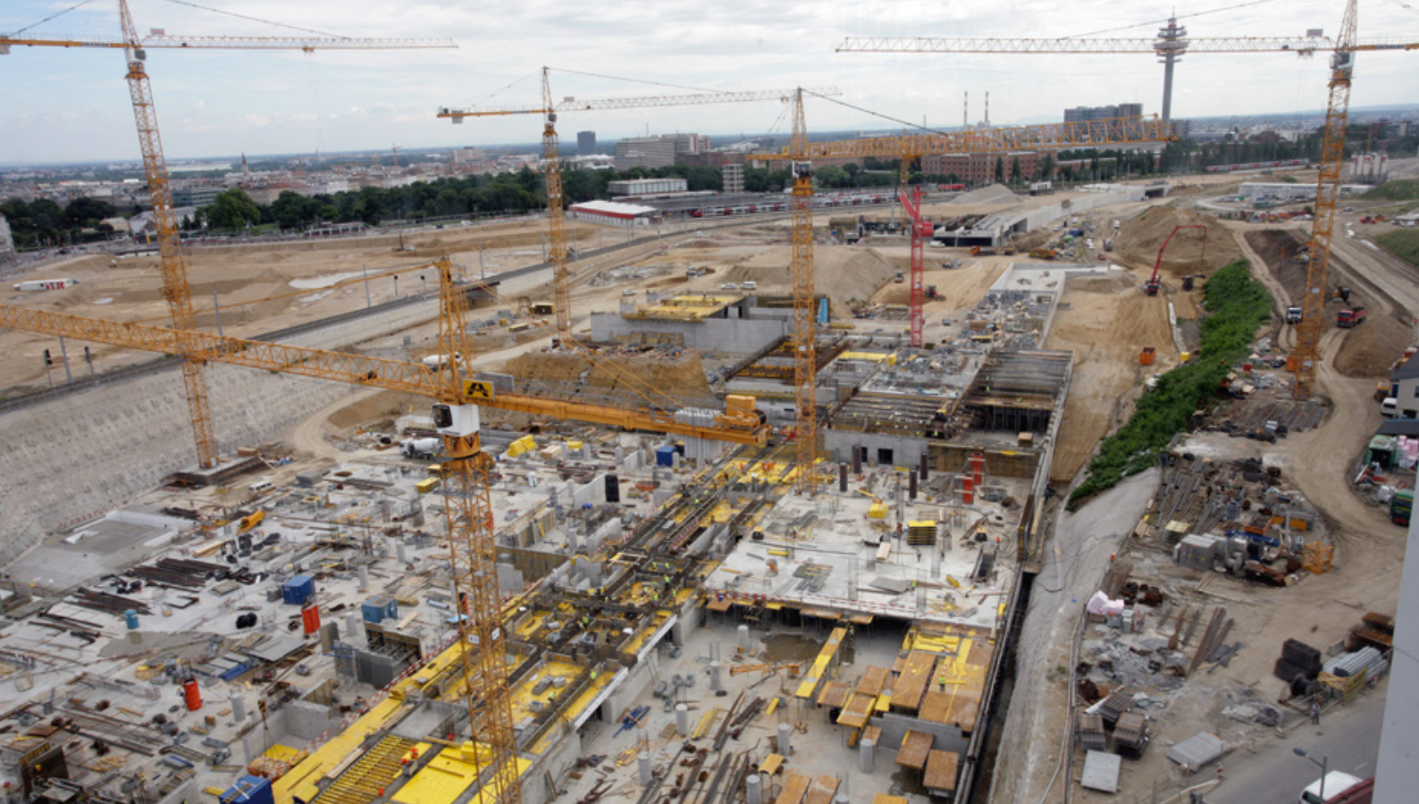
Abb. 206: Baustelle Hauptbahnhof Wien, August 2010.
