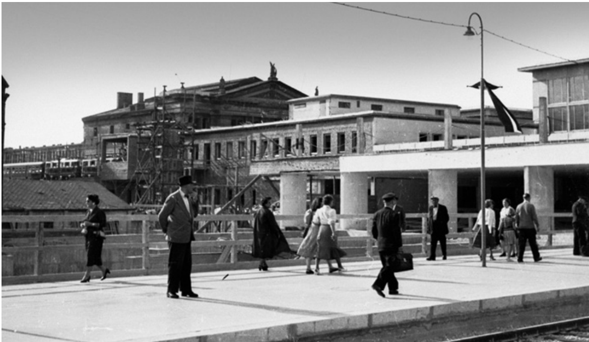
Abb. 6: Neuer Bahnsteig Ostbahn, im Hintergrund Südbahnhof II, am 29. September 1956.
