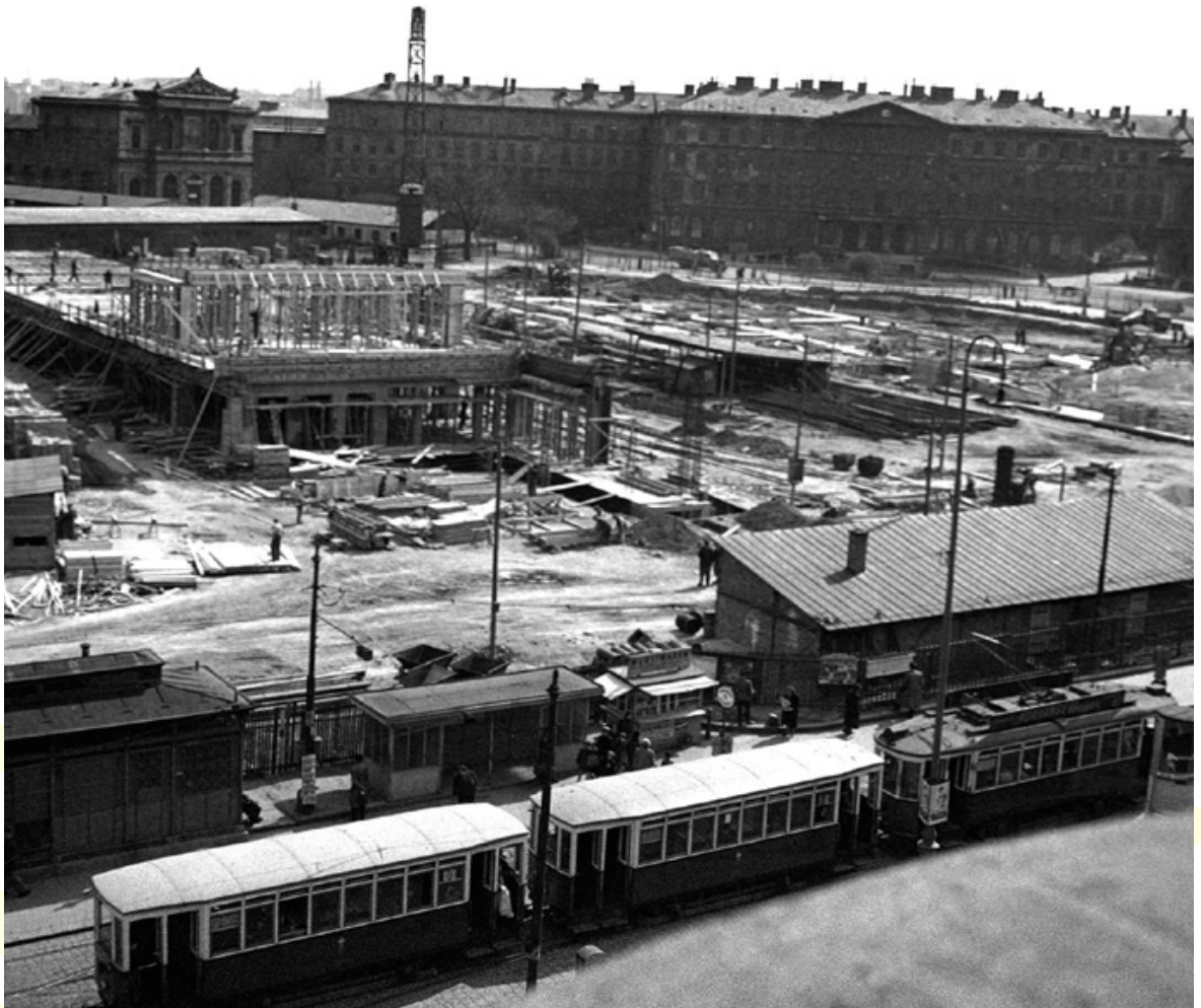
Abb. 66: Bau des dritten Wiener Südbahnhofes, im Hintergrund das Betriebsgebäude und die Ruine des Ostbahnhofes.
