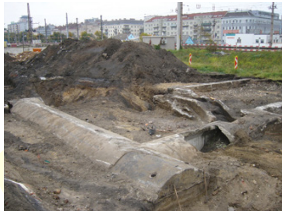
Abb. 132: Teilabschnitt eines Ganges des LS-Deckungsgrabens Landgutgasse. Lüftungslöcher in der aufgesetzten, gewölbten, dünnen Decke. Im Hintergrund der Margaretegrütel.
