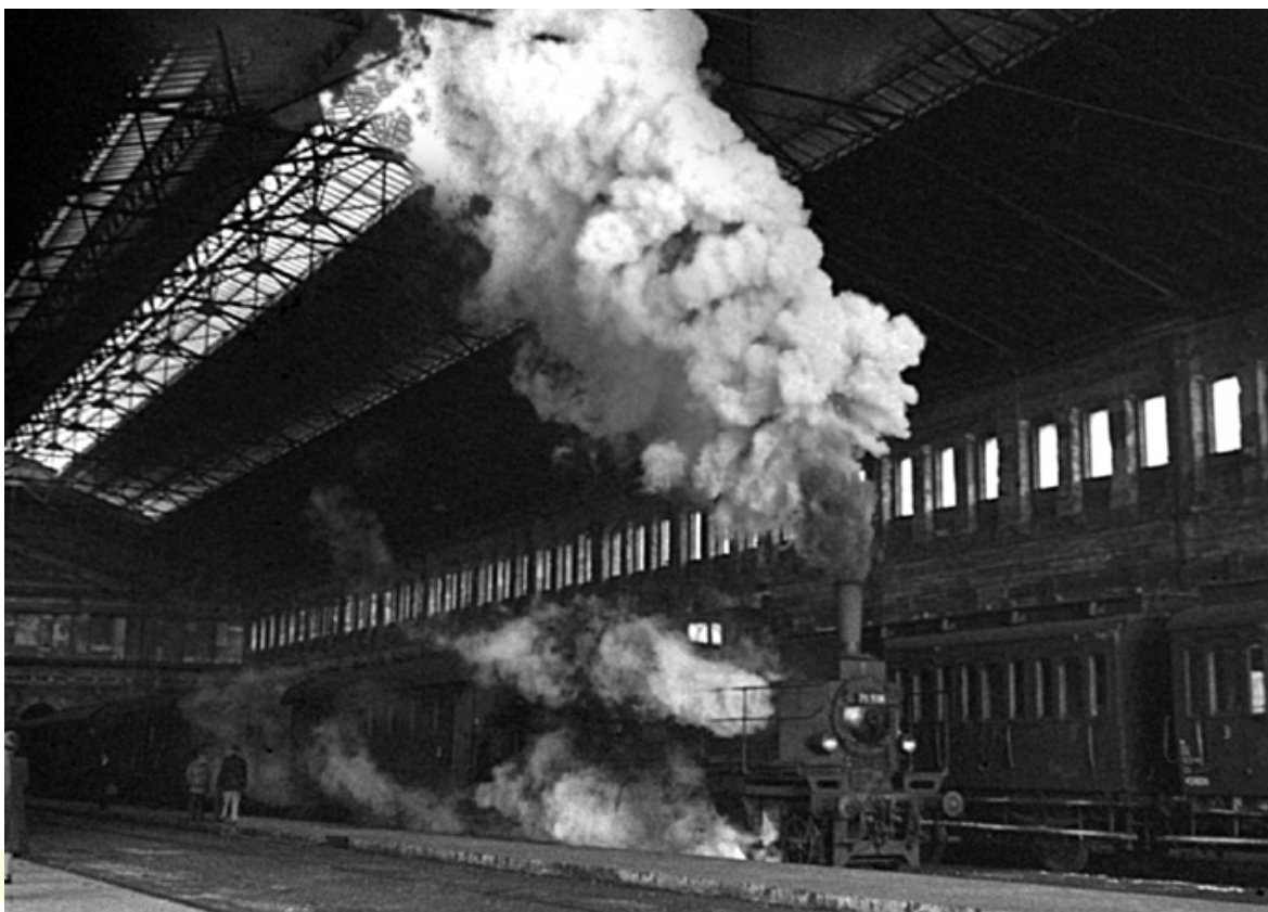
Abb. 60: Ankunftseite des kriegsbeschädigten Gebäudes, Südbahnhof II.
