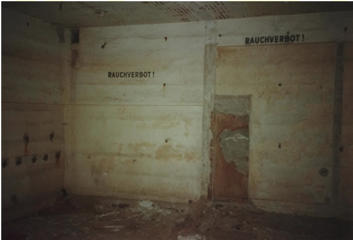
Abb. 110: Bereiche der sanitären Räume (Aborte, Waschräume) im Südbahnhof-Bunker. Ordnungsaufschriften; Zwischenwände herausgerissen (1996).
