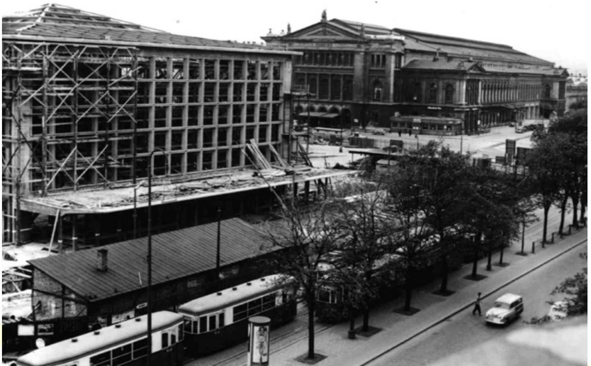
Abb. 71: Der Südbahnhof des Historismus (hinten) und der Nachkriegszeit (vorne, in Bau).
