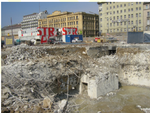
Abb. 130: Abbruch des Südbahnhof-Bunkers. Im Hintergrund der Wiedner Gürtel. Bereich der Gasschleuse (Vgl.: Abb. 109).
