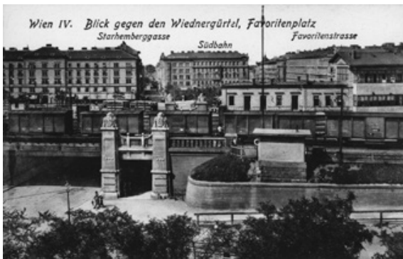
Abb. 99: Die Südbahn und der Wiedner Gürtel von der äußeren Favoritenstraße aus, 1917.
