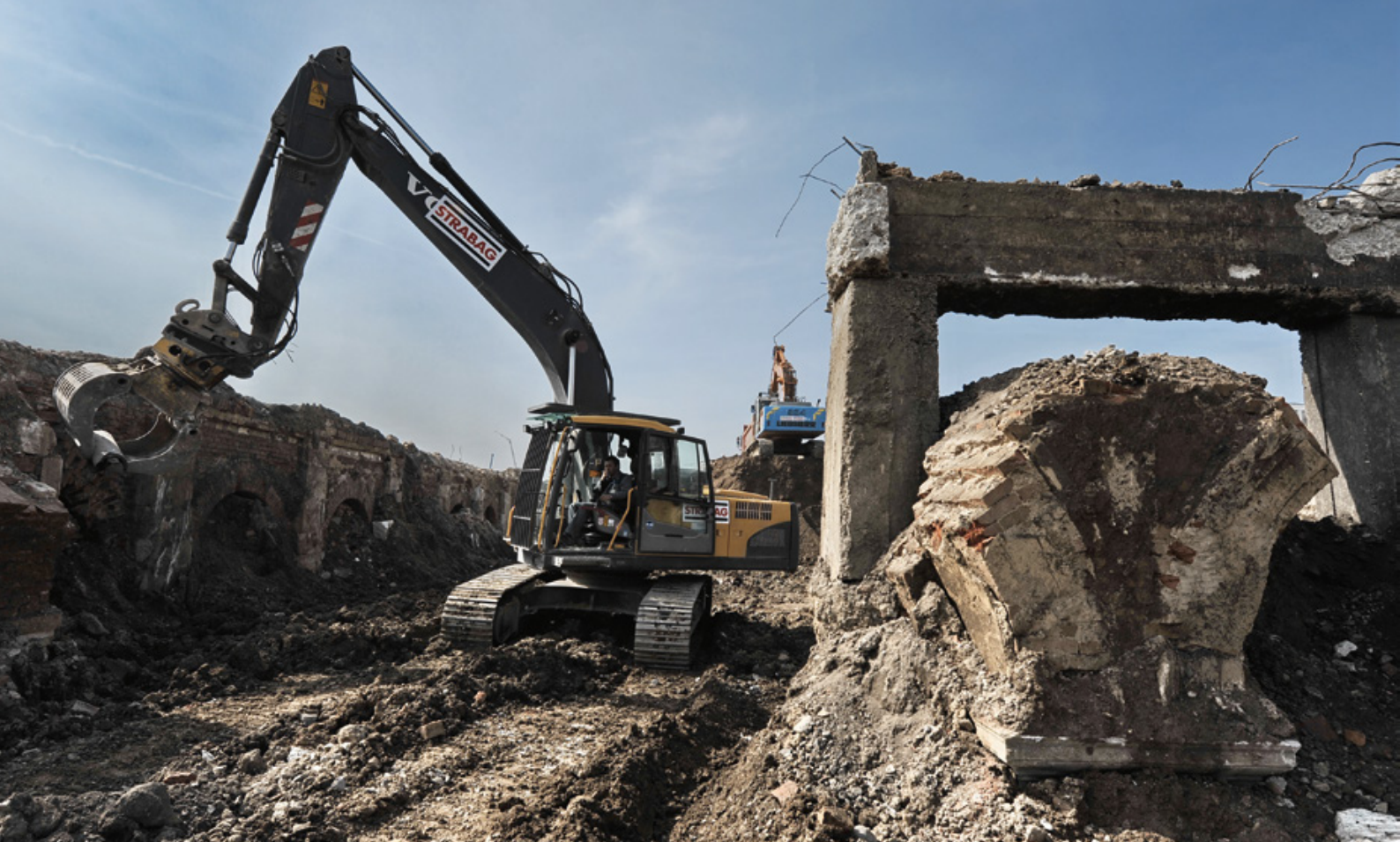
Abb. 27: Entfernen der Betonreste und oberen Schuttschichten, Vorbereitung für die archäologische Bauaufnahme, 23. März 2010.
