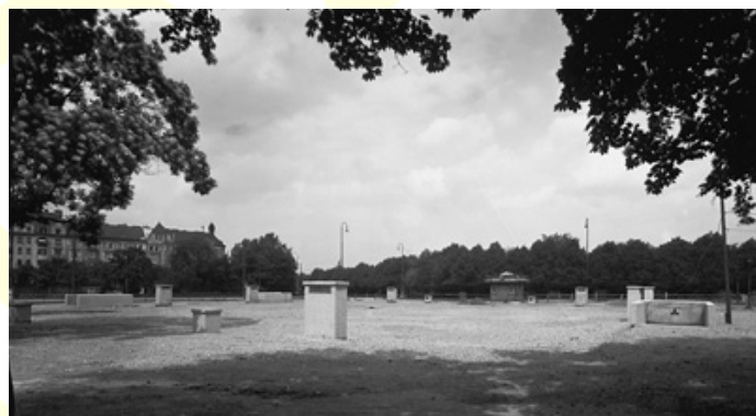
Abb. 105: Herbst 1943. Bunker ist schon bezugsfähig. Blick Richtung Wiedner Gürtel und Schweizergarten. Zu erkennen sind die betonierten Lüftungsschächte und die beiden Treppenabgänge.
