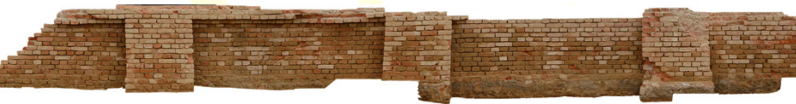
Abb. 32: Fundament und aufgehendes Mauerwerk des Ostbahnhofes, Photogrammetrie.
