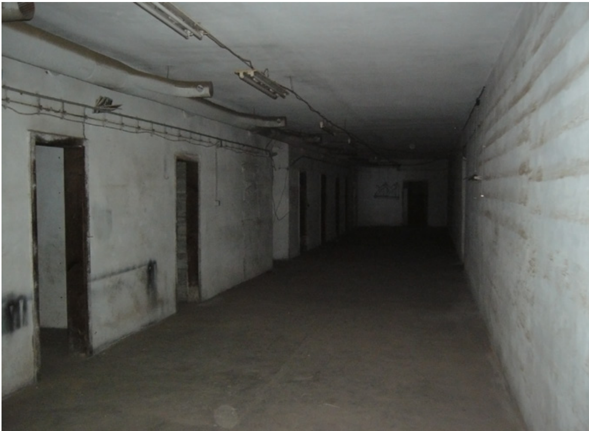
Abb. 114: Im Inneren des Ostbahnhof-Bunkers. Lüftungsrohre sind noch an der Decke montiert.
