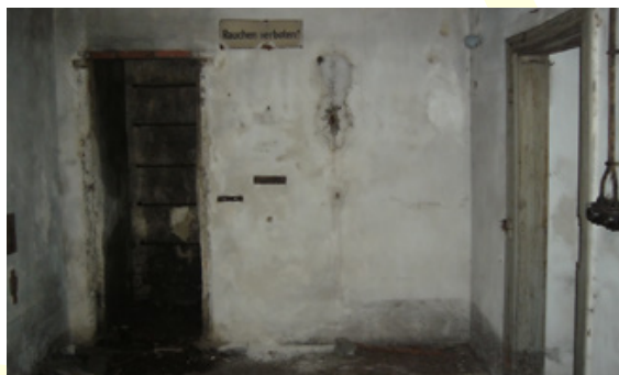
Abb. 127: Inneres des Bahnpersonal-Bunkers mit Notausstieg (Sprossen).
