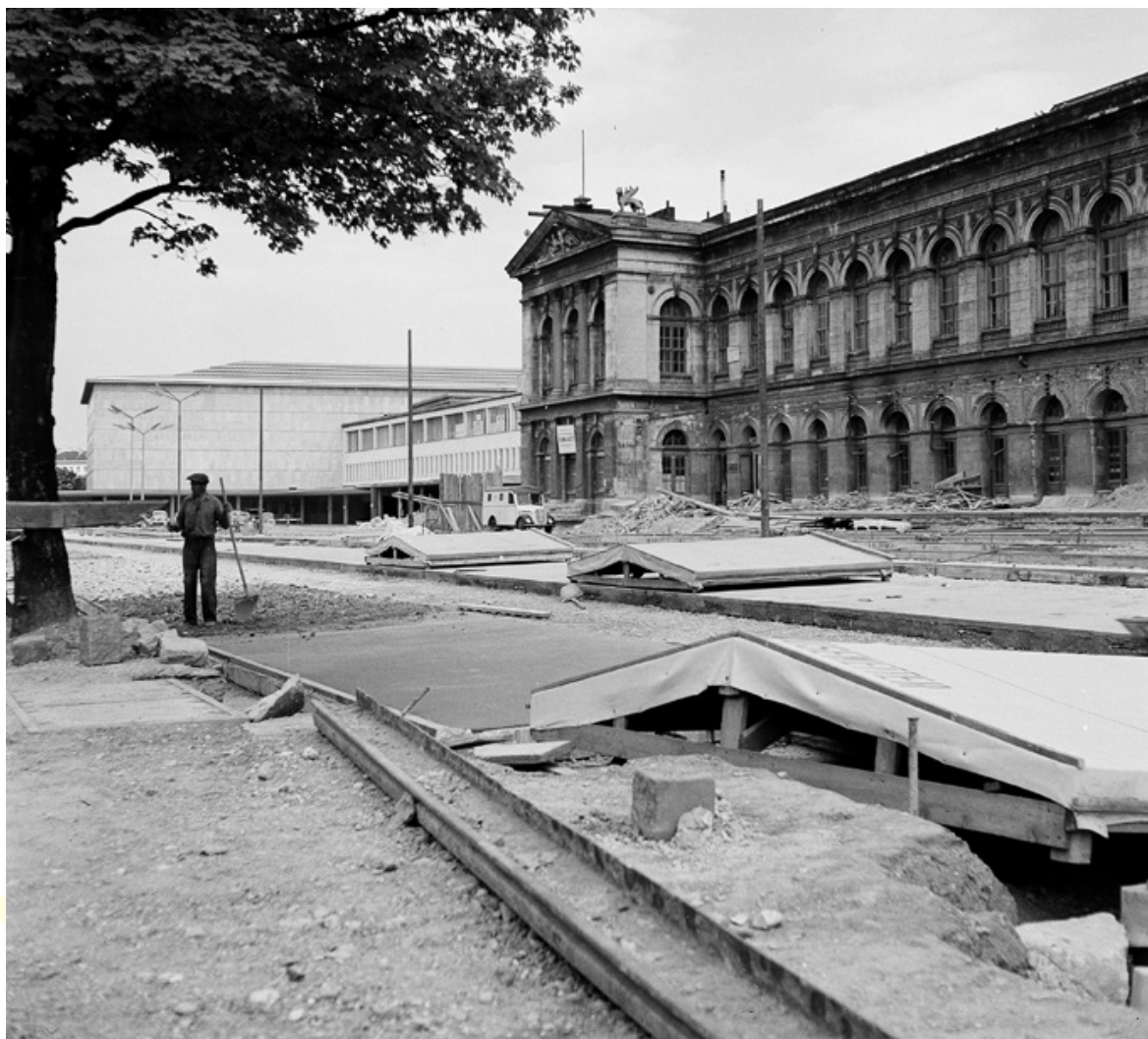
Abb. 65: Abbruch des zweiten Wiener Südbahnhofes.
