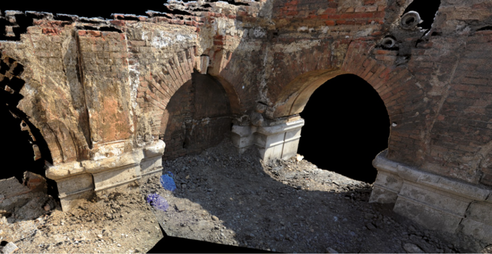
Abb. 47: Perspektivische Darstellung einer colorierten und gereinigten Punktwolke.
