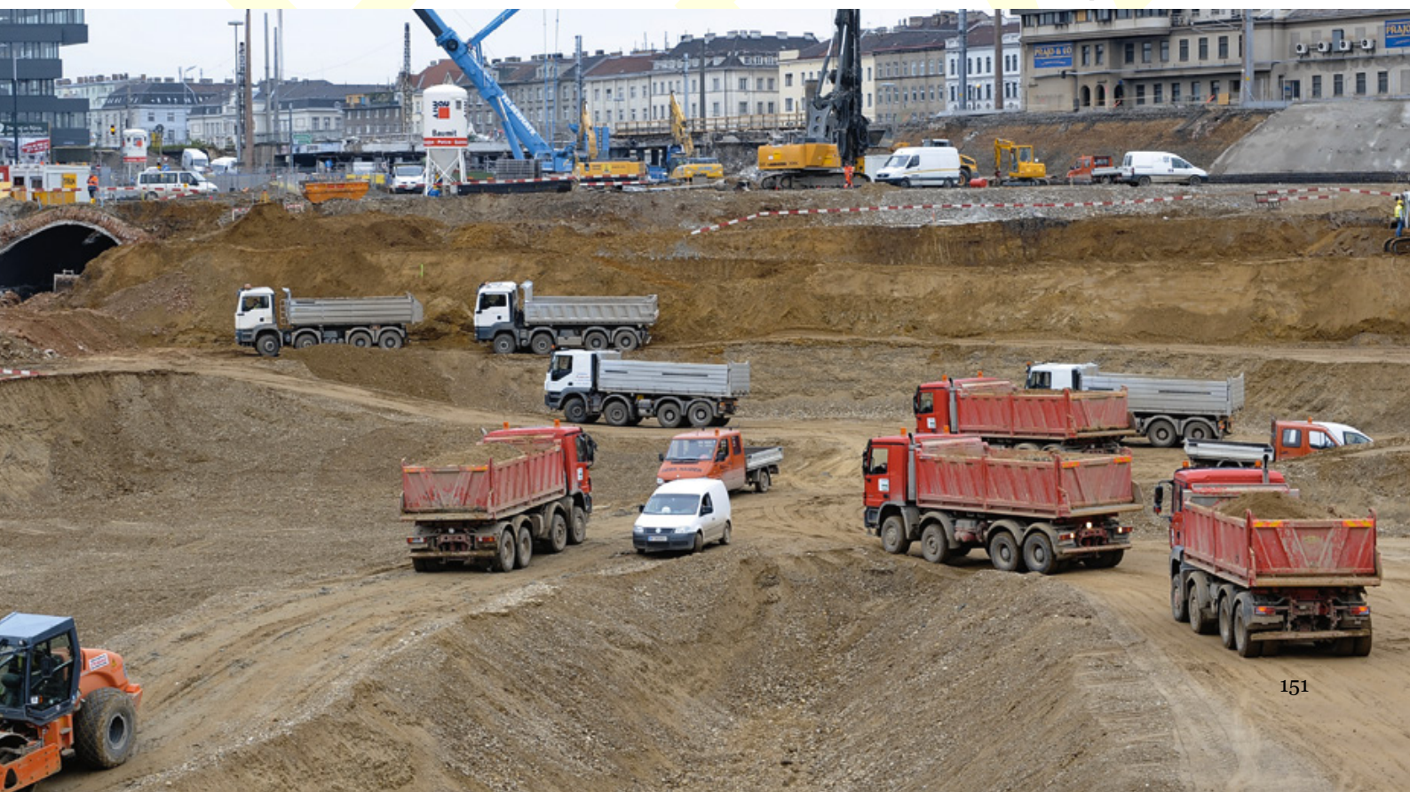
Abb. 205: Baustelle Hauptbahnhof Wien, 5. Mai 2010.
