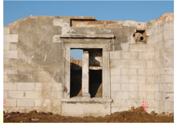
Abb. 81: Fassade mit Fenster und unterschiedlichem Steinmaterial.
